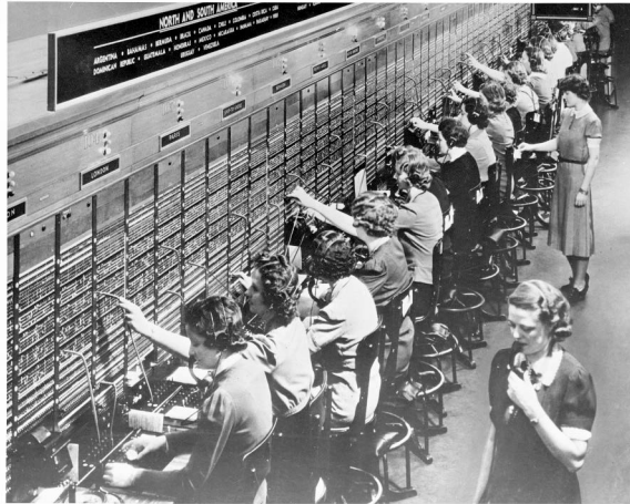
Abb. 3: Telefonistinnen arbeiten an einem Bell System International Telefon Switchboard, ca. 1939–1945. 4
