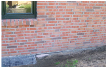
Bild 88: Mangelhafte Sockelabdichtungen
