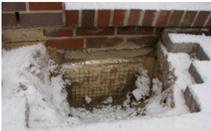
Bild 89: Fehlende Abdichtung und Dämmung
