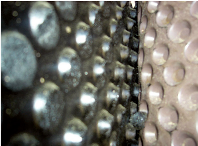
Bild 63: Mangelhafte Schutzschicht ohne Gleitschicht und Lastverteilung
