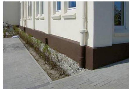
Bild 117: fertige Sockelausbildung
