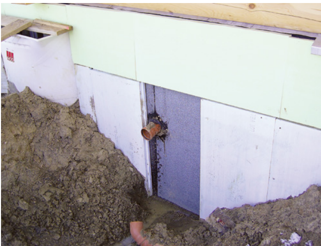
Bild 147: Fugen nicht verschlossen
