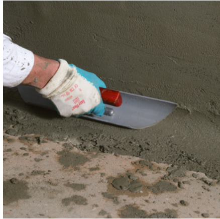
Bild 188: An sämtlichen Mauerwerksvorsprüngen bzw. im Wand-/Bodenanschluss werden Dichtungskehlen mit 5,0 cm Schenkellänge aus Dichtmörtel hergestellt.
