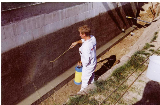
Bild 73: Grundierung der Wandflächen
