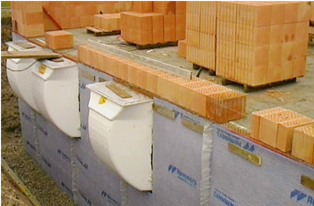
Bild 60: Beispiel: Anschluss an Lichtschächte
