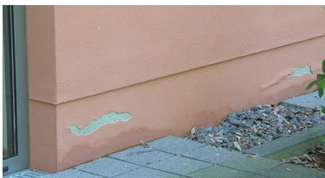
Bild 97: Sockelausbildung mit Feuchtigkeitsschäden
