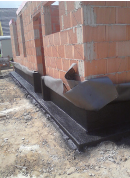
Bilder 123 und 124: Sockelabdichtungen nach DIN 18195 und DIN 1053
