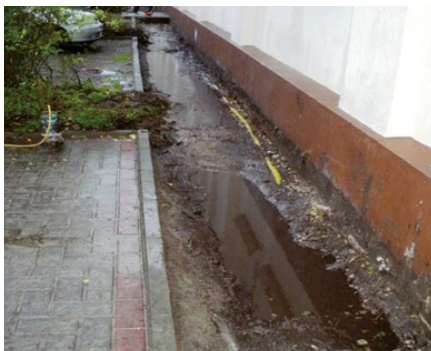
Bilder 112 und 113: freigelegter Sockel und Untergrundvorbereitung [Quelle: Remmers Baustofftechnik]
