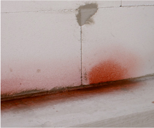
Bild 160: Vermörtelung bei Vertiefungen > 5 mm
