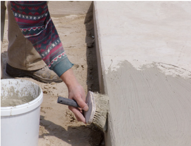
Bild 38: Auftragen der Dichtschlämme
