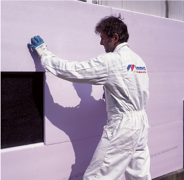
Bild 62: Vollflächige Verklebung mit Stufenfalz
