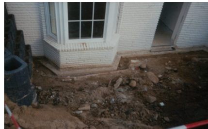
Bild 90: Fehlende Bodenplattenabdichtung
