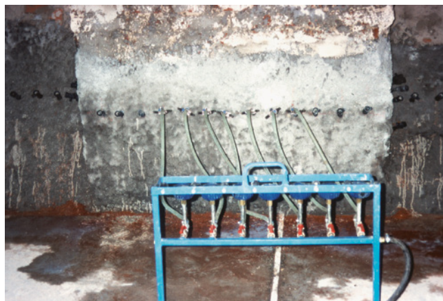
Bilder 174 und 175: Das für die Injektion vorbereitete Mauerwerk und Durchführung der Injektion mit einer sogenannten Injektionsgalerie
