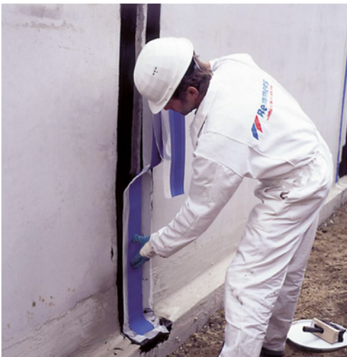
Bild 30: Einbau des Fugenbandes
