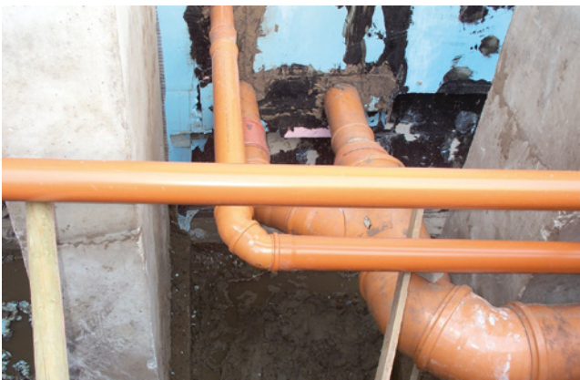
Bild 143: Fehlerhafte Eindichtung
