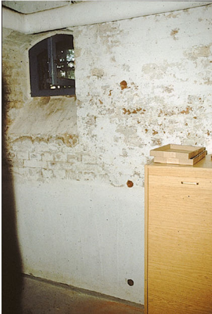
Bilder 163 und 164: Beispiel Kellerinstandsetzung vorher/nachher
