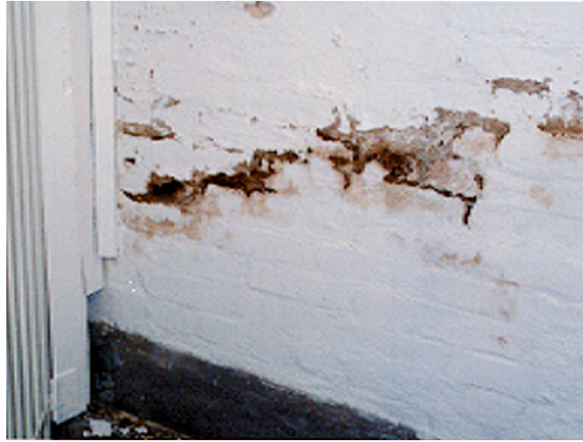
Bild 136: Schäden durch aufsteigende Mauerfeuchtigkeit und Salze
