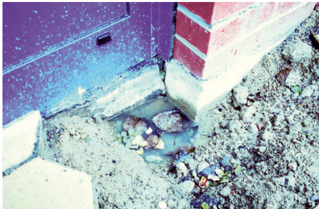
Bild 131: Mangelhafter Türabdichtungs- anschluss
