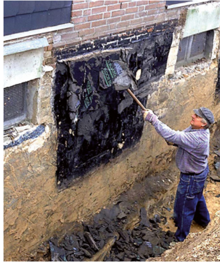
Bild 182: Mauerwerk, Putz oder vorhandene Abdichtungen sind dann zu reinigen und sämtliche Verschmutzungen und nicht festhaftende Teile müssen dabei entfernt werden.
