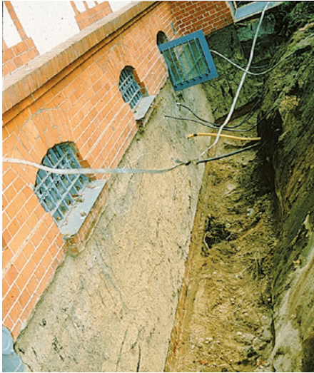
Bild 181: Aufnahmen der gesamten Pflasterung/Plattenbelages einschließlich Unterbau entlang der Außenwände und Freilegen des Grundmauerwerks bis zu Unterkante Bodenplatte
