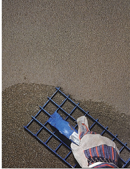
Bild 200: Die Oberflächen der unteren Putzlagen müssen jeweils nach dem Ansteifen gründlich aufgeraut werden.
