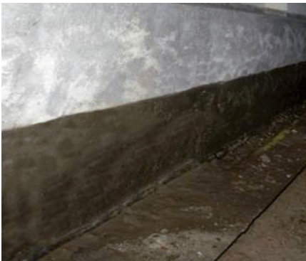
Bild 114: ausgeführte Sulfatexschlämme
