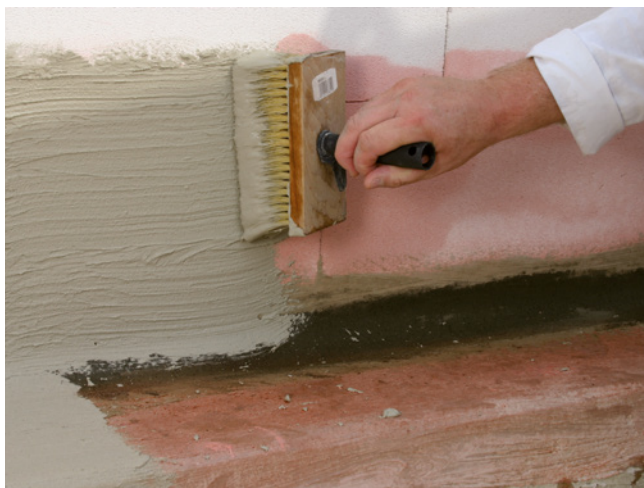
Bild 40: Dichtschlämme als Haftbrücke
