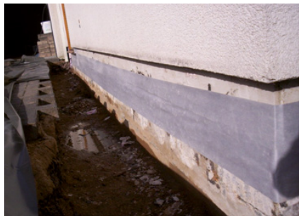
Bild 125: Vorbereitung mit Verstärkungseinlage [Quelle: Fa. Hölscher Duisburg]
