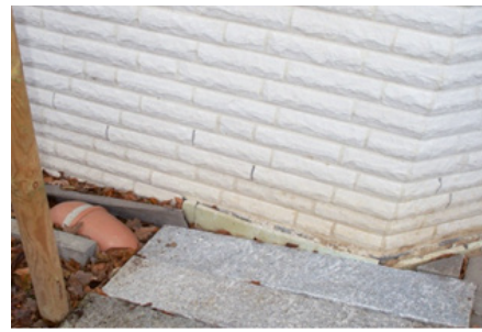
Bilder 93 und 94: Instandsetzung einer Abdichtung im Sockelbereich
