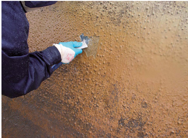
Bild 162: Teilweise leicht vom Beton abzulösende Schlämme
