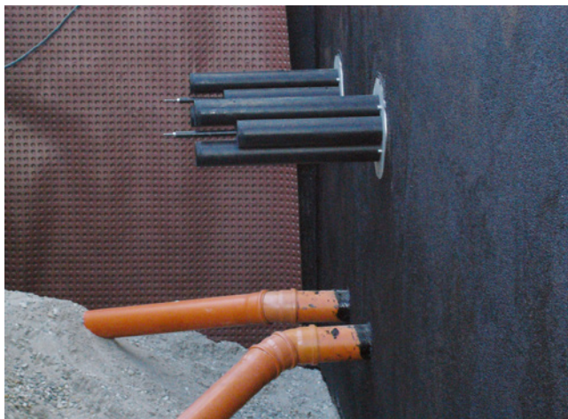
Bild 144: Unterschiedliche Varianten von Durchdringungen
