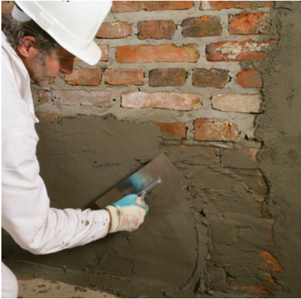
Bild 187: Offene Fugen mit Mörtel verschließen und Ausbruchstellen und Wandflächen mit Grundputz egalisieren
