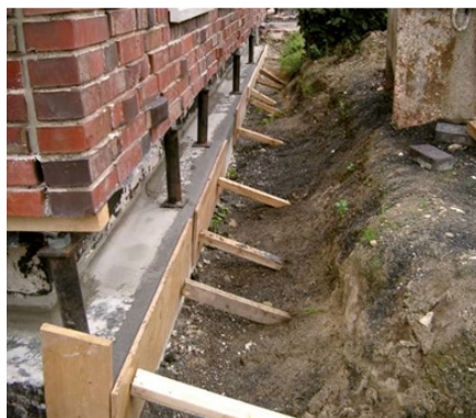
Bilder 109 und 110: Objektbeispiel für einen nachträglichen Einbau einer Sockelabdichtung in einer zweischaligen Wandkonstruktion.
