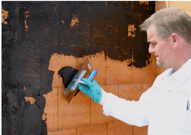
Bild 158: Kratzspachtelung mit KMB bei Fehlstellen <5 mm
