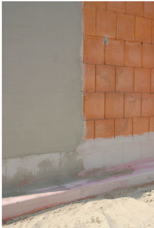
Bild 36: Einbau einer mit Dichtungskehle
