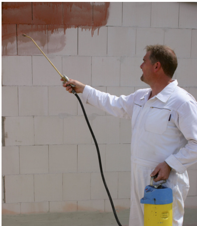
Bild 43: Grundierung
