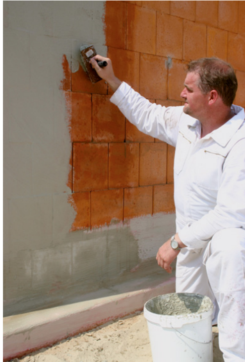
Bild 35: Egalisierung der Untergründe mit der Dichtschlämme
