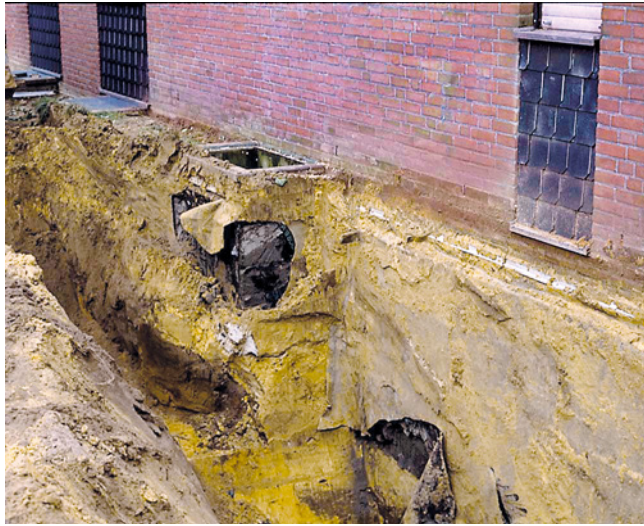
Bild 139: Zu tief angeordneter Sockel
