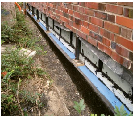
Bilder 109 und 110: Objektbeispiel für einen nachträglichen Einbau einer Sockelabdichtung in einer zweischaligen Wandkonstruktion.
