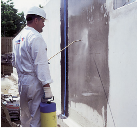
Bild 151: vollflächige Grundierung
