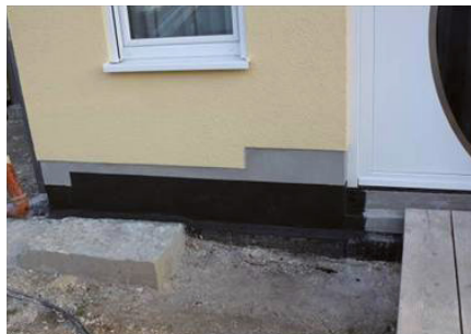
Bild 120: Sockel mit flexibler Dichtungsschlämme abgedichtet [Quelle: Stefan G. Hock, Fa. Adikon]
