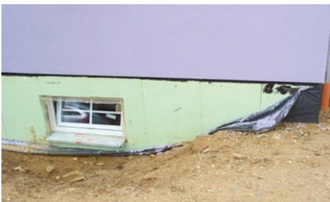
Bilder 101 und 102: mangelhafte Schutzsysteme
