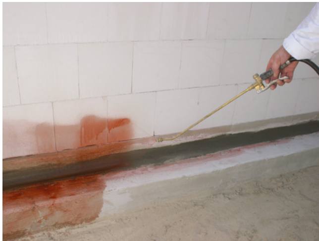
Bild 39: Grundierung
