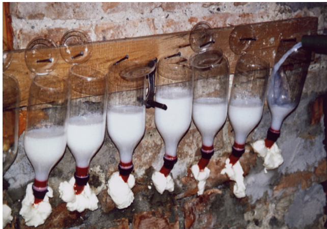
Bild 170: Drucklose Injektion über Vorratsgefäße mit einer Siliconemulsion
