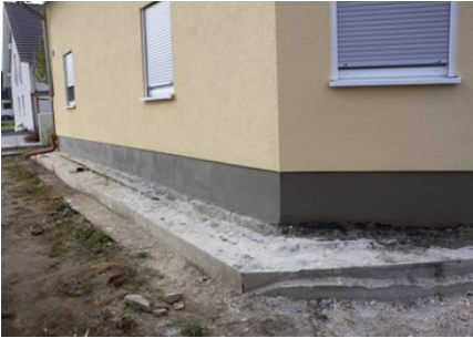
Bild 121: ausgeführter Sockelputz [Quelle: Stefan G. Hock, Fa. Adikon]
