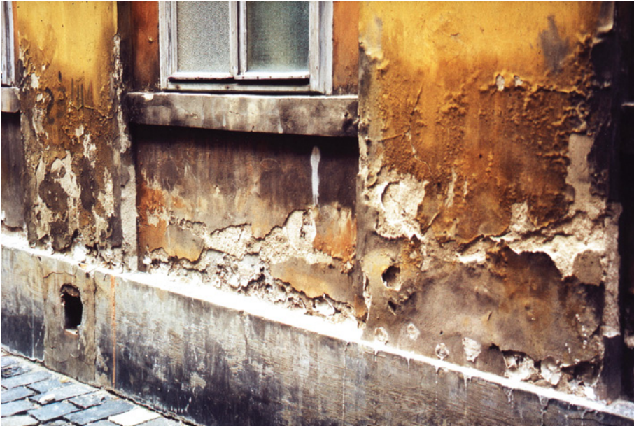
Bild 10: Feuchteschäden an einem Objekt durch aufsteigende Mauerfeuchtigkeit und hygroskopisch wirkende Salze
