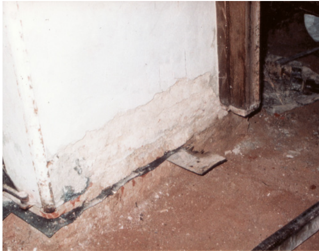
Bild 168: Mauersägeverfahren
