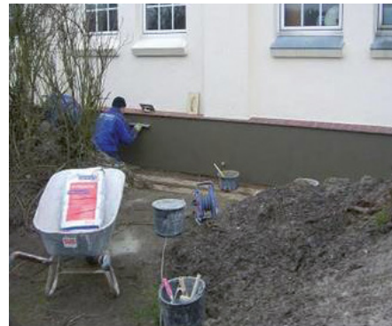
Bild 115: Ausführung mit Dichtspachtel
