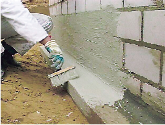
Bild 17: Auftragen der Dichtschlämme als Hinterfeuchtungsschutz
