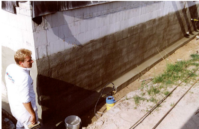
Bild 72: Vorbereiteter Untergrund
