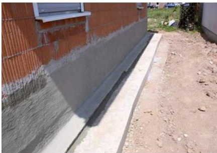
Bild 119: Auftrag der Dichtungsschlämme [Quelle: Stefan G. Hock, Fa. Adikon]
