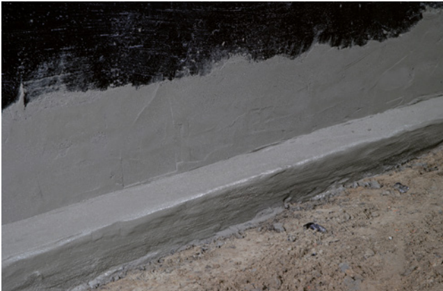
Bild 141: Grundabdichtung und Hinterfeuchtungsschutz mit Dichtschlämme
