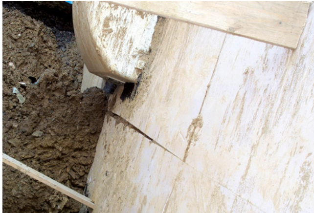
Bild 64: Fehlerhafte Plattenverlegung bei Druckwasser
