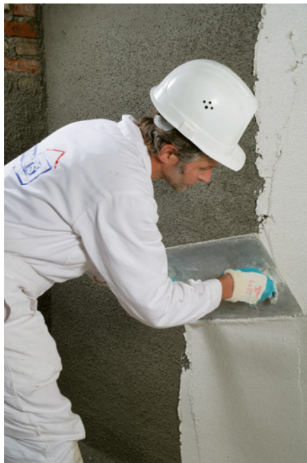
Bild 190: Sanierputzauftrag
