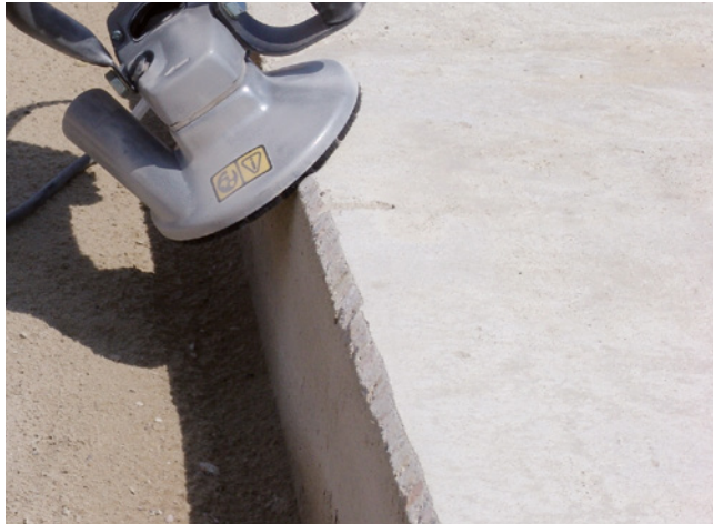
Bild 71: Ansicht einer gefasteten Bodenplatte
