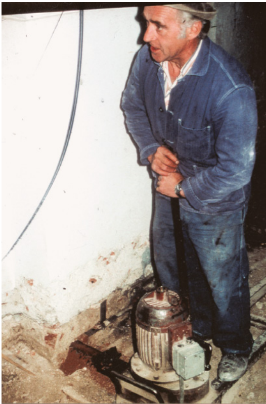
Bild 167: Mäuersägeverfahren
