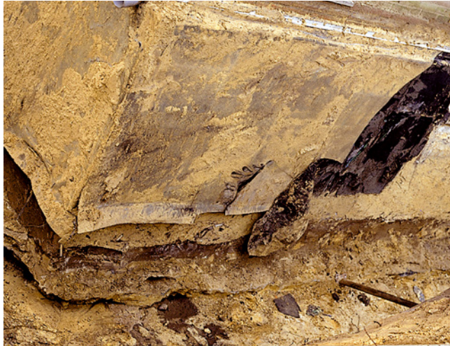
Bild 140: Fehlende mechanische Befestigung zur Bodenplatte
