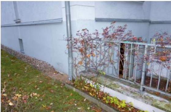
Bild 100: Feuchtigkeit im Sockelputz
