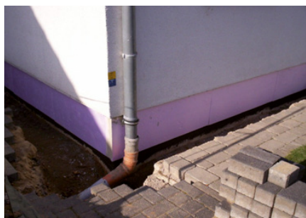
Bild 128: fertiggestellte Sockeldämmung [Quelle: Fa. Hölscher Duisburg]
