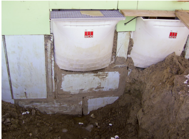
Bild 148: Lichtschacht nicht fachgerecht angebracht
