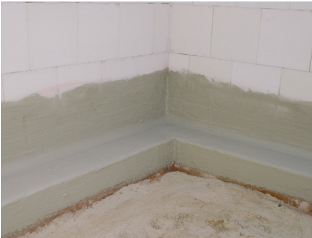
Bild 42: Fertiger Dichtungskehlenbereich
