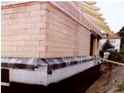
Bilder 102 und 103: Beispiel einer mangelhaften Sockelabdichtung bei zweischaligen Konstruktionen
