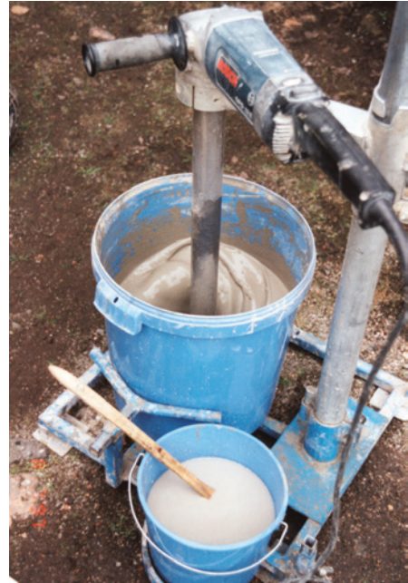
Bild 172: Anrühren des Injektionsmörtels für die Mehrstufeninjektion
