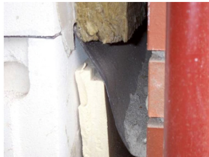
Bilder 102 und 103: Beispiel einer mangelhaften Sockelabdichtung bei zweischaligen Konstruktionen
