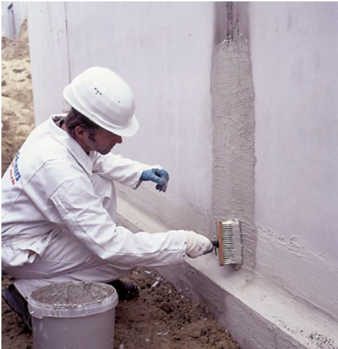
Bild 29: Auftrag der Dichtschlämme
