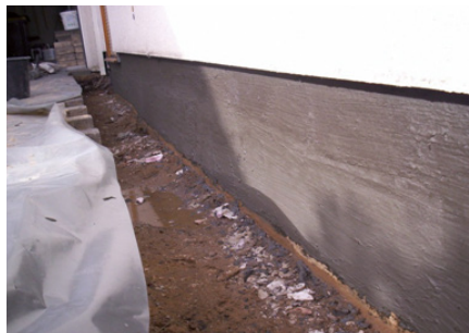
Bild 126: egalisiert und mit Multi-Baudicht abgedichtet [Quelle: Fa. Hölscher Duisburg]
