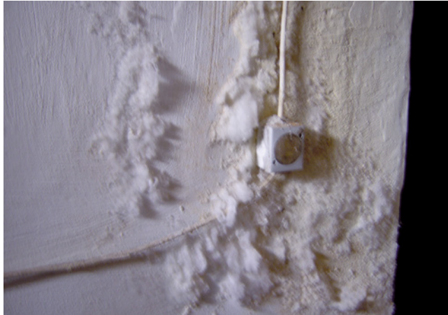
Bild 194: Salzschäden
