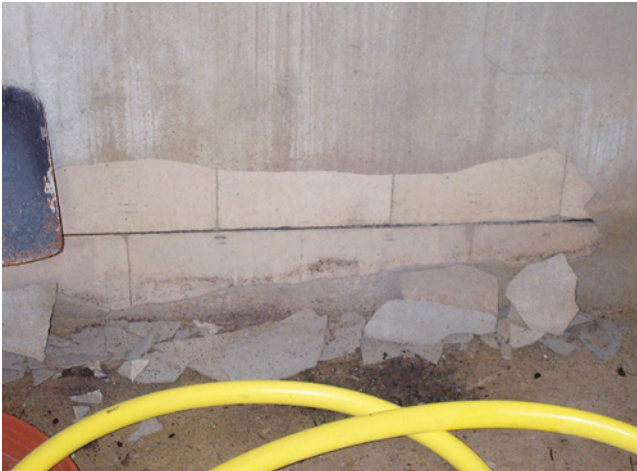
Bild 134: Durchfeuchtungen im Wand-Bodenanschluss bis zur ersten waage- rechten Abdichtung.
