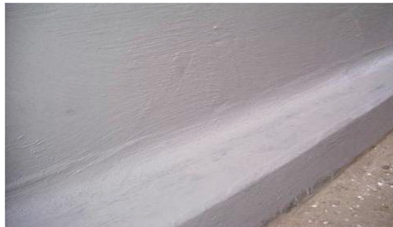
Bild 16: Vorbereitung zum wasser- dichten Anschluss mit Dichtungsschlämmen.
