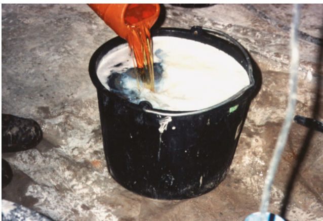
Bild 173: Anmischen der Siliconmikroemulsion
