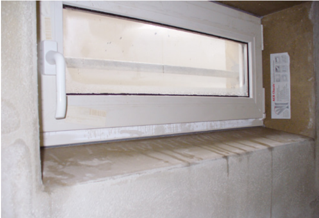
Bild 59: Fehlende Laibungsdämmung
