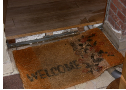
Bild 92: Mangelhafter Anschluss Terrassentür an der Hauseingangstür
