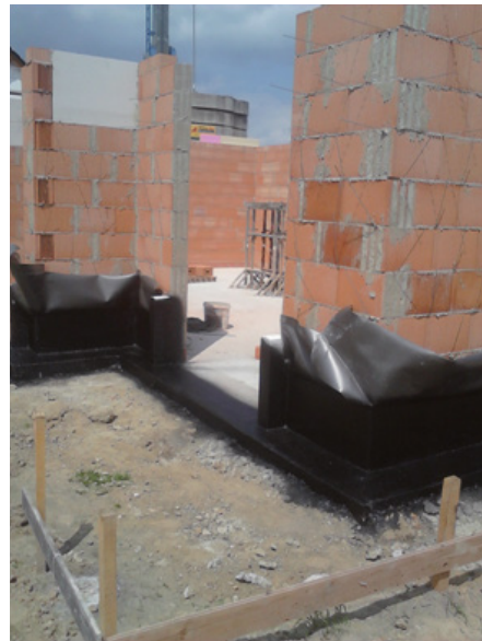
Bilder 123 und 124: Sockelabdichtungen nach DIN 18195 und DIN 1053
