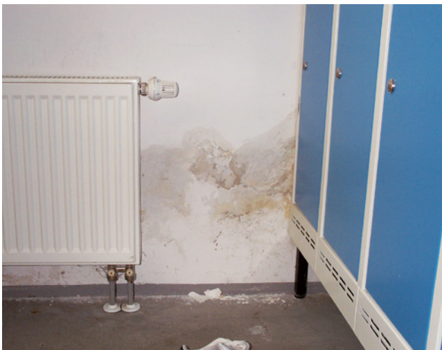
Bild 165: Feuchte und Salzschäden in einem Kellerraum
