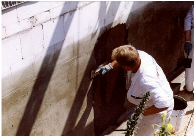
Bild 159: Auftrag von Dichtschlämmen bei Fehlstellen <5 mm
