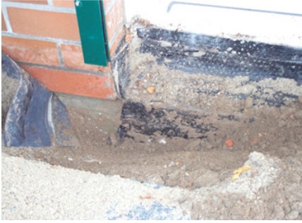
Bild 91: Mangelhafter Anschluss Terrassentür
