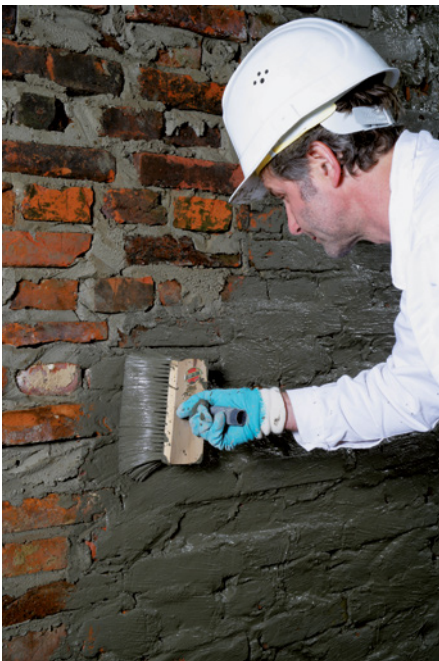
Bild 189: Aufbringen der Dichtschlämme
