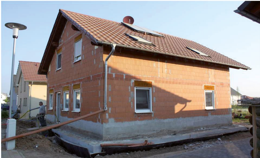
Bild 118: Objektansicht Bodenplatte schon angehoben [Quelle: Stefan G. Hock, Fa. Adikon]
