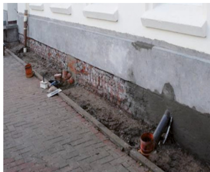
Bilder 112 und 113: freigelegter Sockel und Untergrundvorbereitung [Quelle: Remmers Baustofftechnik]
