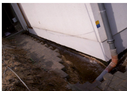
Bild 130: fertiger Sockelanschluss [Quelle: Fa. Hölscher Duisburg]
