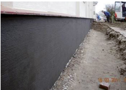
Bild 116: Überarbeitung mit rissüberbrückender Dichtschlämme
