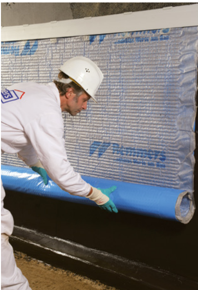
Bild 61: Schutz mit Gleit- und Lastverteilungsschicht
