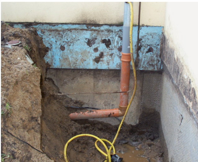
Bild 177: Schürfgrube zur Feststellung von Schäden
