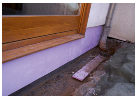
Bild 129: Abdichtung und Dämmung [Quelle: Fa. Hölscher Duisburg]
