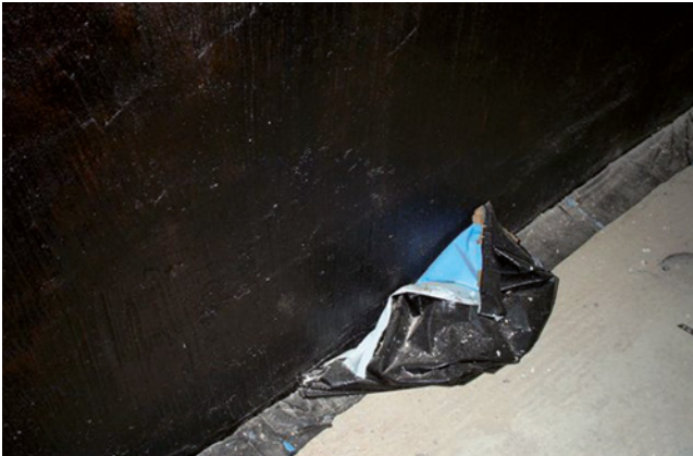
Bild 153: Abrutschen der Dichtungsbahn
