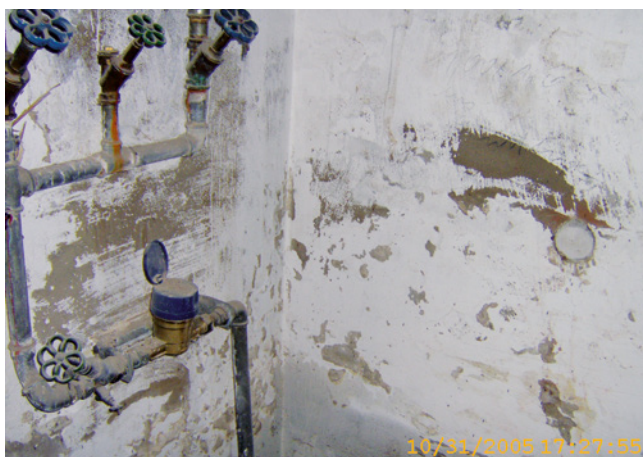
Bild 196: Innenliegende Versalzungen
