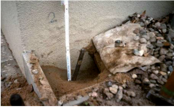
Bild 99: aufsteigende Feuchtigkeit im Sockelputz
