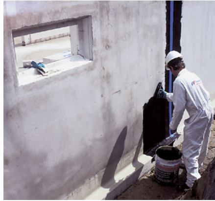
Bild 152: Vollflächige Kratzspachtelung auf Beton
