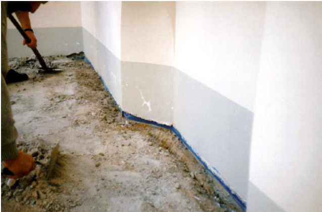
Bild 145: Ausblühungen und Abplatzungen
