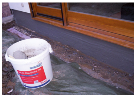
Bild 127: Abdichtungsanschluss an Terrassentür [Quelle: Fa. Hölscher Duisburg]
