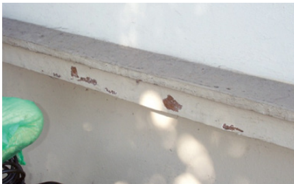
Bild 87: Anstrich und Putzschaden
