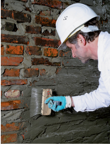
Bild 199: Auftragen der Dichtschlämme
