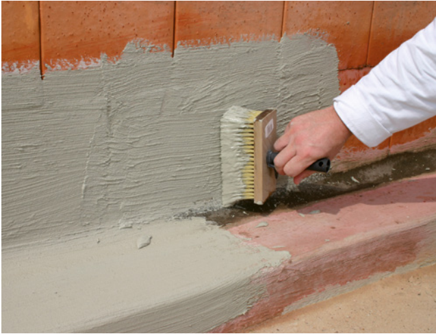
Bild 41: Hinterfeuchtungsschutz
