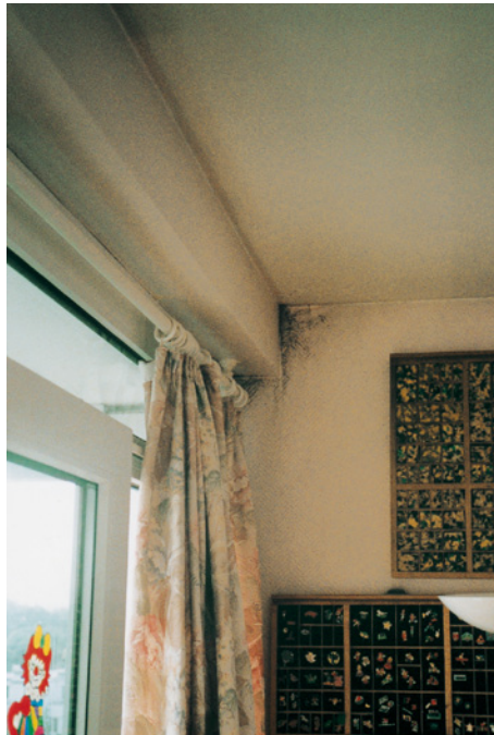
Abb. 2.12: Konstruktions- bedingte Wärme- brücke im Bereich eines Unterzuges
