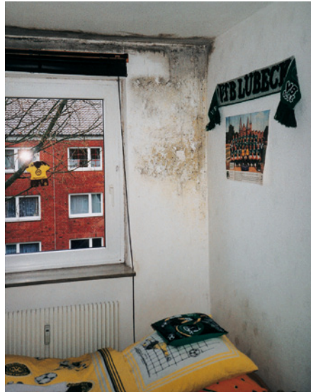
Abb. 2.3: Schimmelpilzbildungen, hervorgerufen durch ungenügende Lüftung
