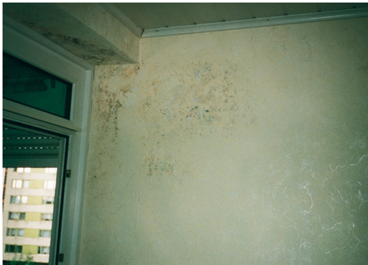
Abb. 2.6: Schimmelpilzbildung infolge von Kondensat- anfall im Bereich einer Außenwand
