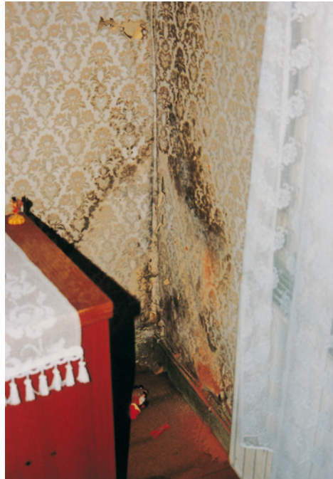
Abb. 2.10: Schimmelpilz- bildung hinter einer Kommode
