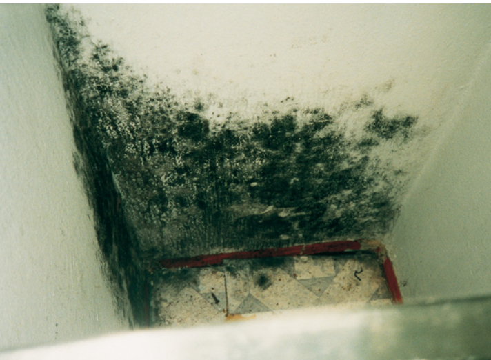
Abb. 2.4: Schimmelpilzbildungen aufgrund ungenügender Beheizung/Lüftung
