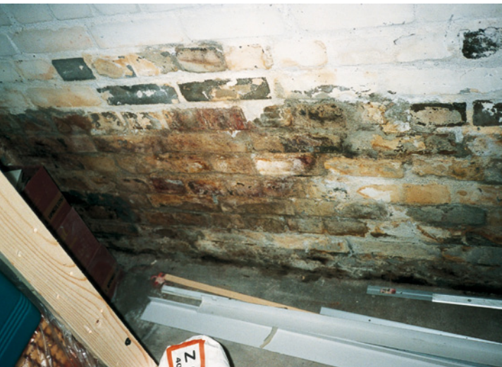
Abb. 2.14: Mauerwerksschädigungen durch von außen eindringendes Wasser
