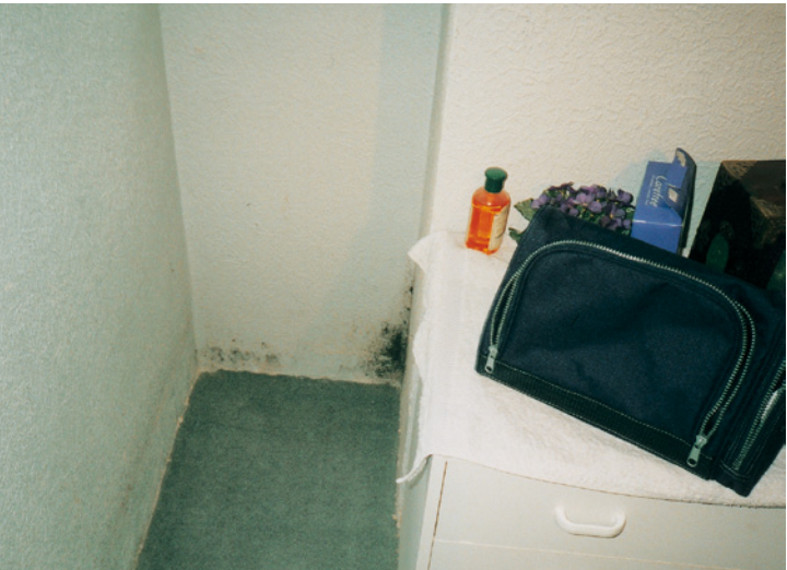
Abb. 2.5: Schimmelpilzbildungen im Badezimmerbereich aufgrund hoher Feuchtebelastung
