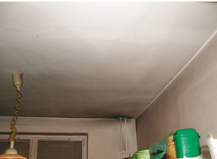
Abb. 7.1: Fogging-Effekt in einer Wohnung
