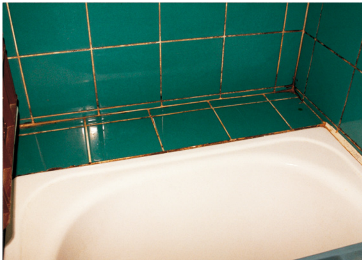
Abb. 6.2: Schimmelpilzbildung auf Fugendichtungen im Badezimmerbereich
