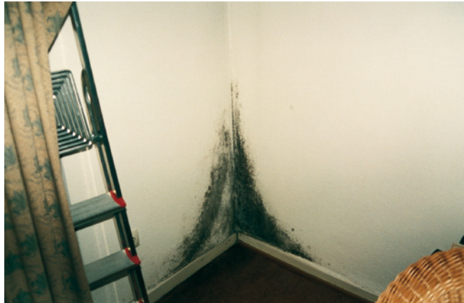
Abb. 2.13: Geometrisch bedingte Wärmebrücke in einer Außenwanddecke
