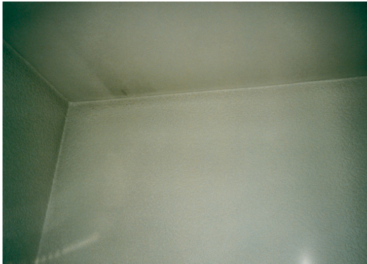
Abb. 2.11: Verfärbungen im Bereich einer Wärmebrücke
