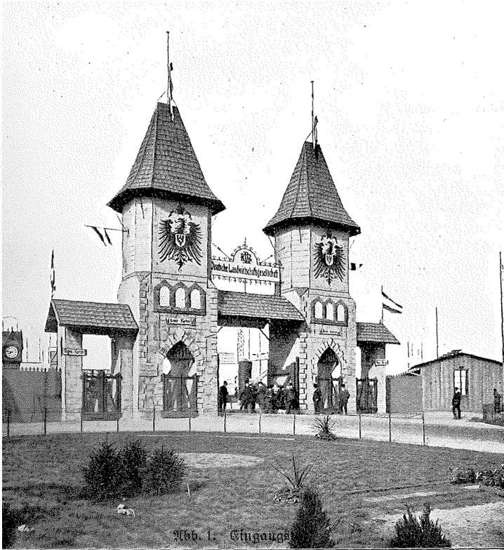
Aus: Giersberg: Die technische Durchführung, S. 25.
