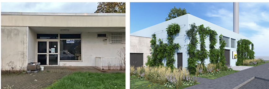
Abbildung 39 und 40: Bereits geschlossener Kiosk an der Dufourstraße (links); Visualisierung der Nahwärmezentrale (rechts)
