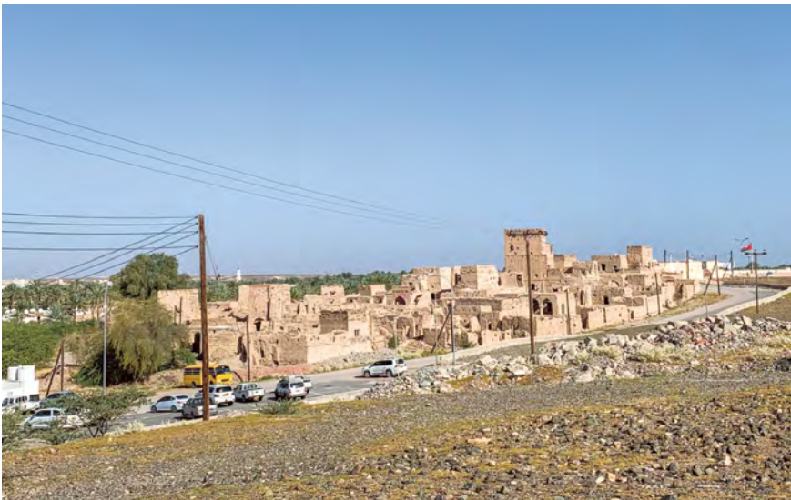
Abb. 2: Blick auf die alte Siedlung in Sinaw, Oman, Foto 2020.
