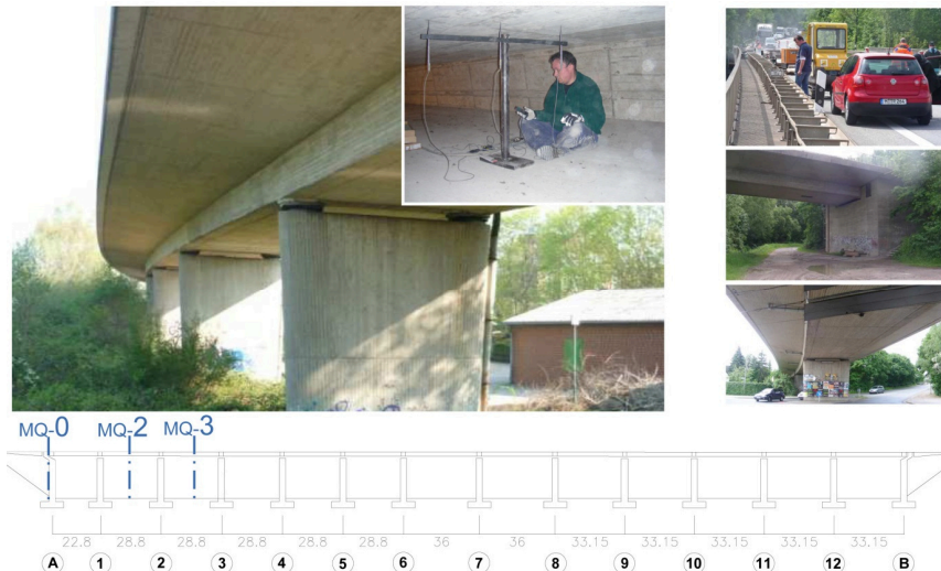
Bild 4-17: Untersuchte Landstraßenbrücke in Rethen mit Messquerschnitten
