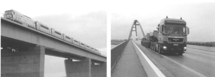
Bild 4-27: Belastungsfahrzeuge auf der Fehmarnsundbrücke aus [3.99], links: zehn Lokomotiven, rechts: 120 t Fahrzeug
