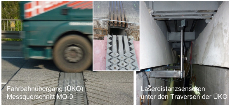
Bild 4-21: Fahrbahnübergangskonstruktion der Landstraßenbrücke in Rethen
