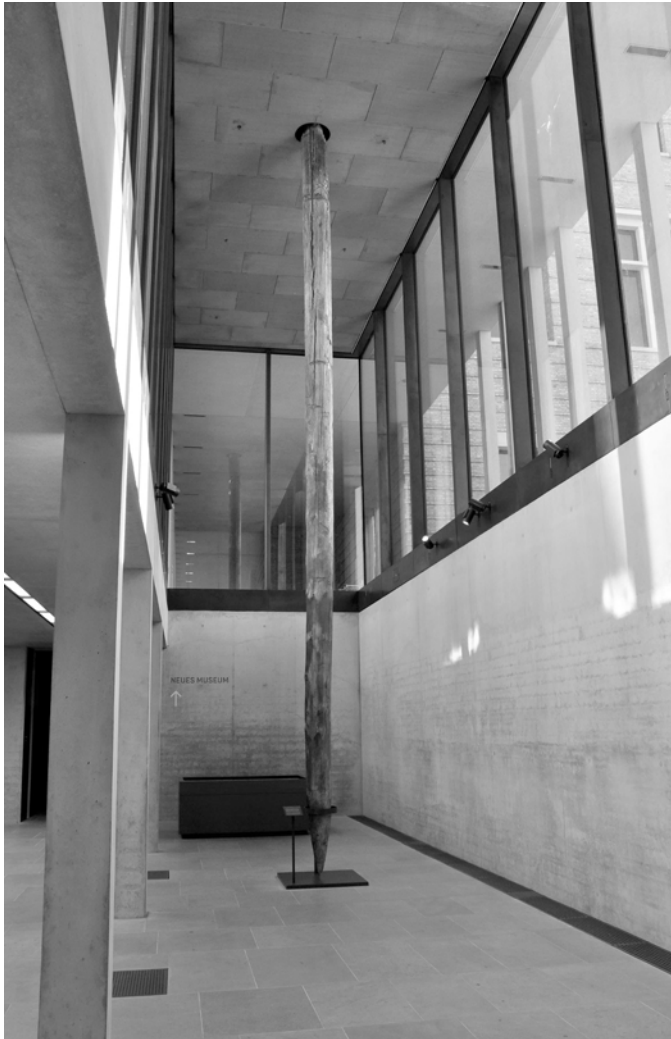
Abbildung 38: Gründungspfahl des ehemaligen Direktorenhauses der Packhofanlagen in der auf diesem Gelände entstandenen James Simon Galerie.
