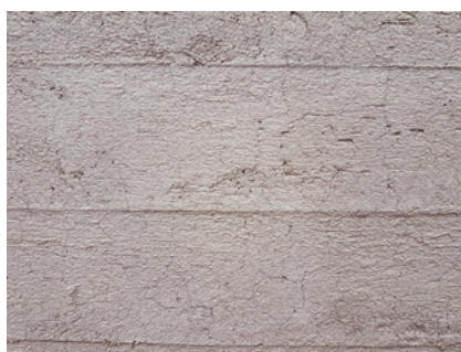
Abb. 15: Oberfläche der Textilbetonbeschichtung mit Risscraquelée nach einem Jahr Standzeit (Foto: Martin Struck, Erzbischöfliches Generalvikariat Köln, 2018)
