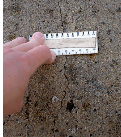
Abb. 8: Risse im Glockenturm einer Kirche und Erosion des Zementsteins durch sauren Regen an den Betonoberflächen
