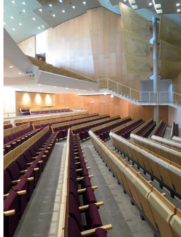
Abb. 8 (rechts): Zuschauerraum mit aufbereiteten Stühlen. Auch die Klimatechnik in ihrem Inneren wurde überholt. Luftverteilung und Geräuschkentwicklung konnten deutlich verbessert werden. (© Brenne Architekten)
