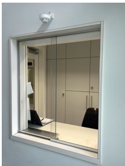
Abb. 16: Feuerschutzvorhang zur Abtrennung des Pfortnerbereichs
