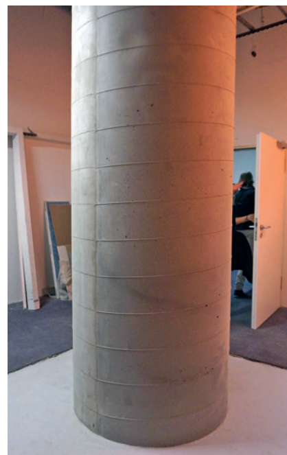
Abb. 10: Musterfläche mit der Instandsetzungsvariante Spritzbeton mit reprofilierten Schalungsabdrücken (© Bayer. Landesamt für Denkmalpflege)
