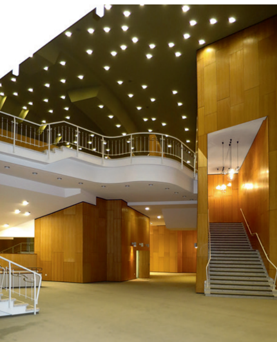
Abb. 6: Die Anordnung der Downlights im Zwischenfoyer konnte durch eine Ausnahmeregelung erhalten werden. Sie erhielten eigens entwickelte LED-Leuchtmittel. (© Brenne Architekten)
