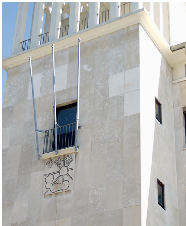
Abb. 3: Saarlouis, Rathaus (1951 bis 1954), Natursteinvorhangfassade nach der Sanierung 2003 (Foto: Rupert Schreiber, LDA Saarland, 2003)
