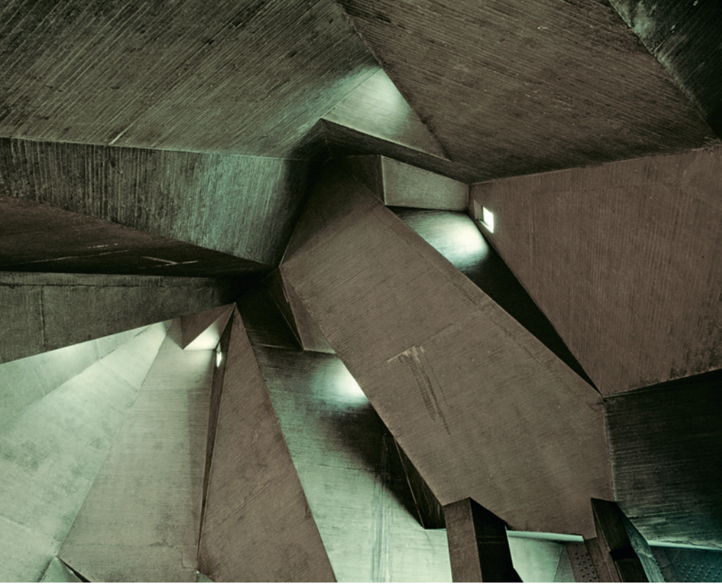
Abb. 5: Innenraum, Betonfaltdach (Foto: LVR-Amt für Denkmalpflege im Rheinland, Jürgen Gregori)
