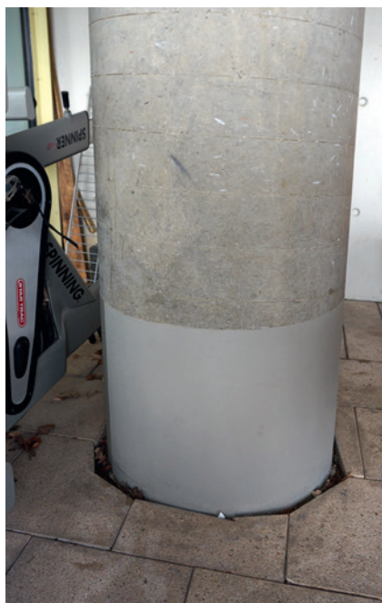
Abb. 8: Musterfläche Instandsetzungsvariante mit Beschichtungssystem im Außenbereich (© Bayer. Landesamt für Denkmalpflege)
