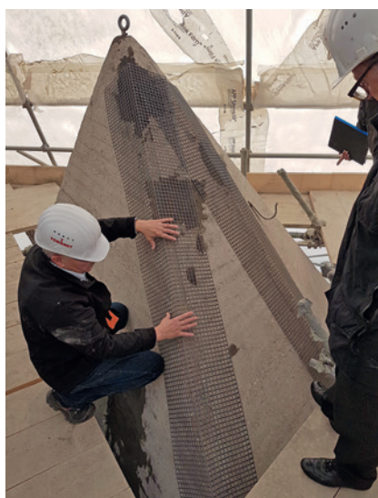
Abb. 12: Vorbereitung der Verlegung des Carbonfasergewebes über den Kanten der Dachpyramide (Foto: Martin Struck, Erzbischöfliches Generalvikariat Köln, 2016)
