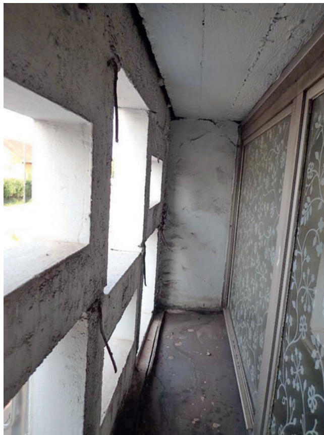
Abb. 1: Dillingen/Saar, Stadthalle (1959 bis 1962), Betonformsteine mit Drahtankern (Foto: Georg Lehman, IBS Sauder, Saarbrücken, 2017)
