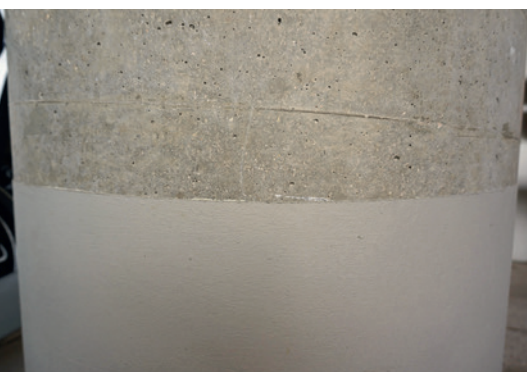
Abb. 9: Musterfläche mit der Instandsetzungsvariante mit Beschichtungssystem OS 5b (unten) im Vergleich zur bauzeitlichen Sichtbetonoberfläche (oben) (© Bayer. Landesamt für Denkmalpflege)
