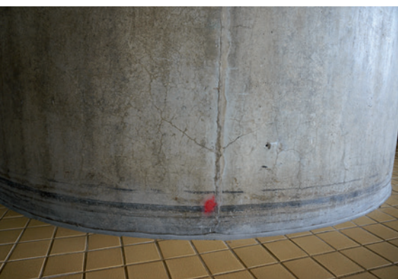
Abb. 6: Anprallspuren am Stützenfuß (© Bayer. Landesamt für Denkmalpflege)
