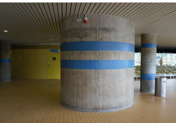
Abb. 4: Sichtbetonstützen im Beckengeschoss mit bauzeitlicher Farbgestaltung (© Bayer. Landesamt für Denkmalpflege)
