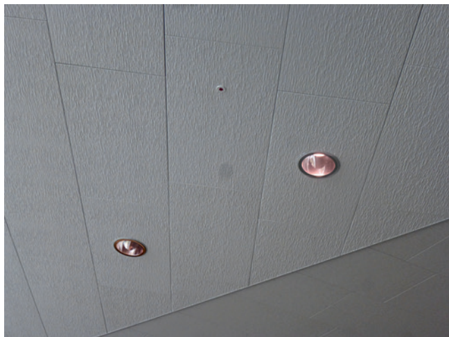
Abb. 9: Kaum wahrzunehmen: Rauch-Ansaug-System der BMA im Foyer
