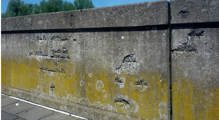
Abb. 7: Korrodierte Bewehrung an der Grafenwerther Brücke in Bad Honnef über den Altrhein, Arch. Ottomar Stein, 1911 bis 1912 errichtet
