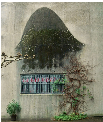
Abb. 9: Bewuchs (Moose) an einer häufig befeuchteten Bauteiloberfläche an der Wallfahrtskirche Maria, Königin des Friedens in Neviges (erbaut in den Jahren 1963 bis 1968 von G. Böhm)
