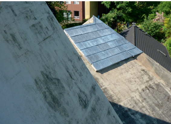
Abb. 6: Musterfläche für eine Dachbeschichtung mit Bleiblech (Foto: Martin Struck, Erzbischöfliches Generalvikariat Köln, 2015)
