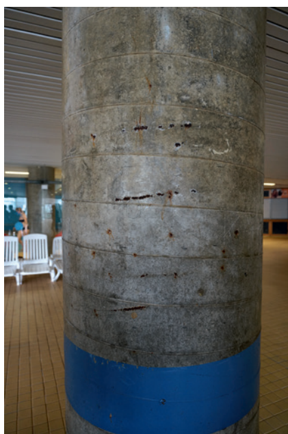
Abb. 5: Korrodierte Wendelbewehrung und ungenügende Betondeckung im Sockelbereich einer Stütze (© Bayer. Landesamt für Denkmalpflege)
