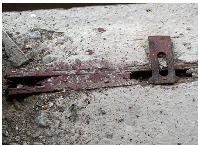
Abb. 2: Metallanker mit bleihaltiger Korrosionsschutzbeschichtung
