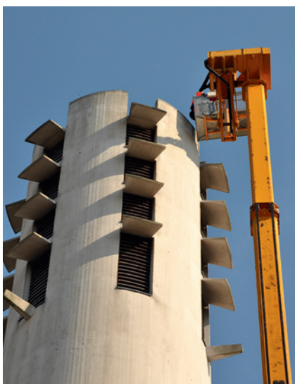
Abb. 10: Untersuchung des 1961/1962 erbauten und Anfang der 1990er-Jahre instand gesetzten kreisrunden, freistehenden ca. 40 m hohen Glockenturms aus Stahlbeton der Kath. Kirche Heilig Geist in Hanau
