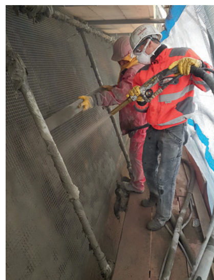
Abb. 13: Auftrag einer Schicht Spritzbeton über der Carbondtextilbewehrung (Foto: Martin Struck, Erzbischöfliches Generalvikariat Köln, 2016)
