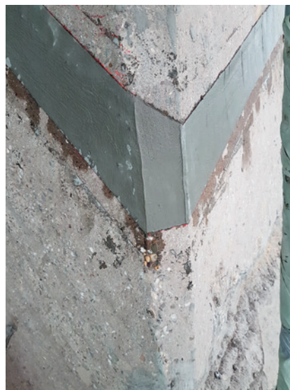
Abb. 11: Sakramentskapelle, Beispiel eines Enthäftungsstreifens (Foto: Martin Struck, Erzbischöfliches Generalvikariat Köln, 2016)
