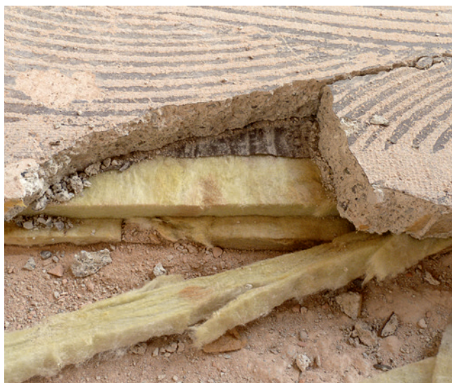
Abb. 4: Trittschalldämmung aus alter Mineralwolle mit lungengängigen Anteilen
