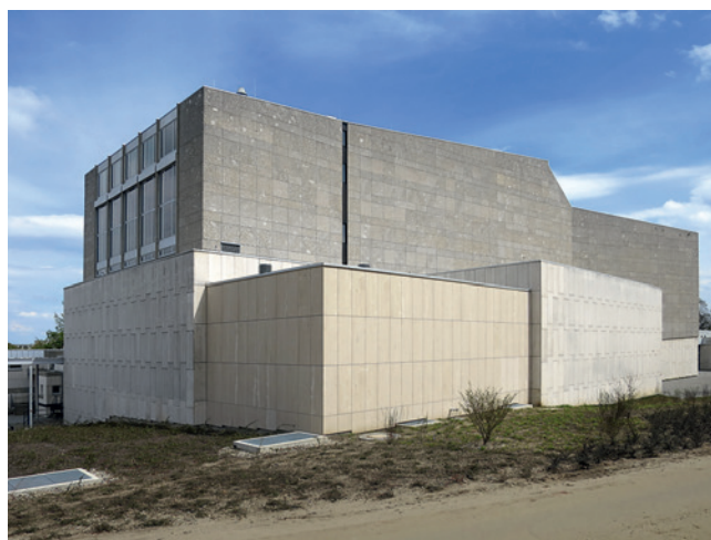
Abb. 16: Der neue Bühnenanbau ist deutlich vom Bestand abgesetzt. Das Format der Fassadenplatten aus Travertin wurde beibehalten. (© Brenne Architekten)
