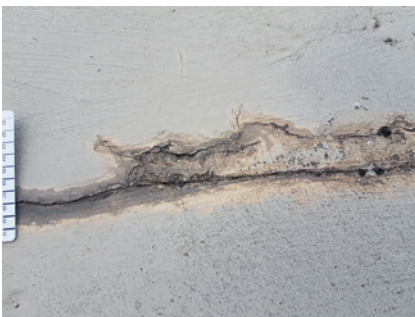
Abb. 10: Sakramentskapelle, Rissbild in der Betonoberfläche im Vorzustand (Foto: Martin Struck, Erzbischöfliches Generalvikariat Köln, 2016)
