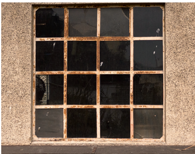
Abb. 3: Werkstattfenster mit Metallrahmen. Häufig sind die Kitten bei solchen Verglasungen asbesthaltig.
