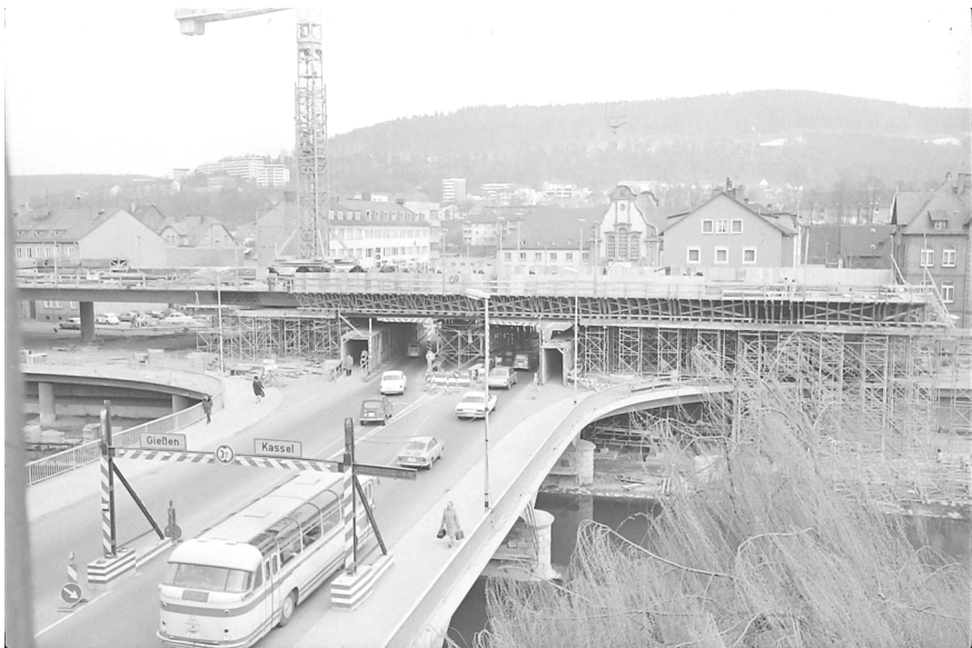
Abb. 2: Autobahnhochbrücke vor dem Bahnhof im Bau
