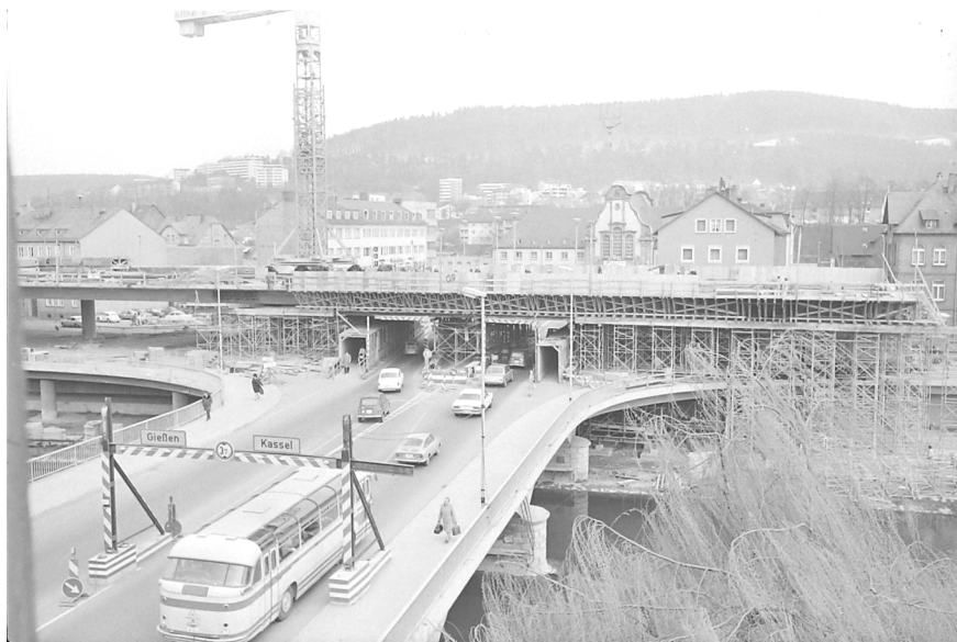
Abb. 2: Autobahnhochbrücke vor dem Bahnhof im Bau
