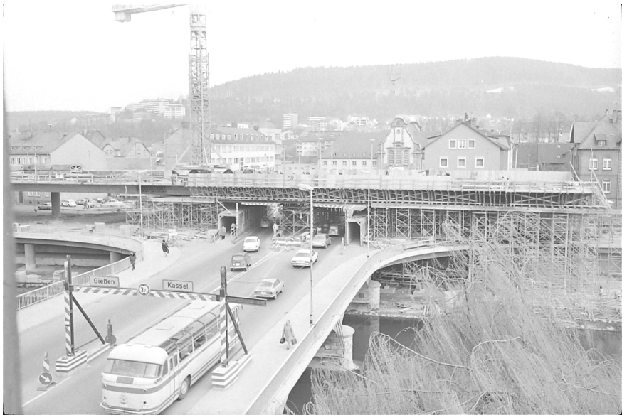
Abb. 2: Autobahnhochbrücke vor dem Bahnhof im Bau
