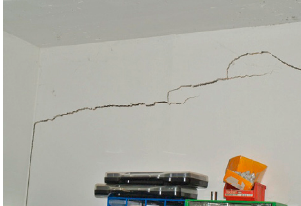
Riss in Raumecke und unterhalb der Kellerdecke
