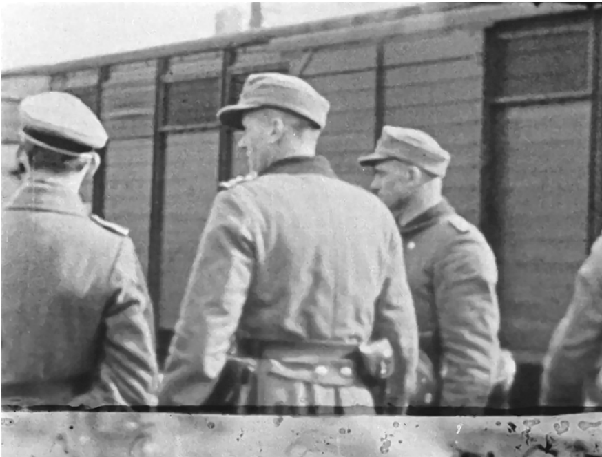
Abb. 36 Unsachgemäß ausgeführte Klebestelle im Westerborkfilm.
