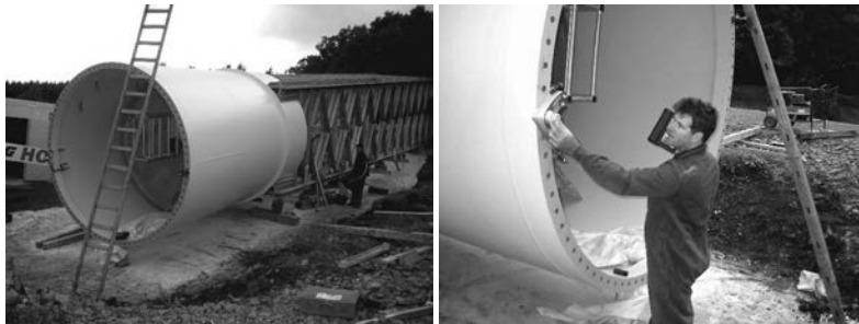
Bild 9: Prüfen der Ebenheit eines Turmflansches mit Levalign
