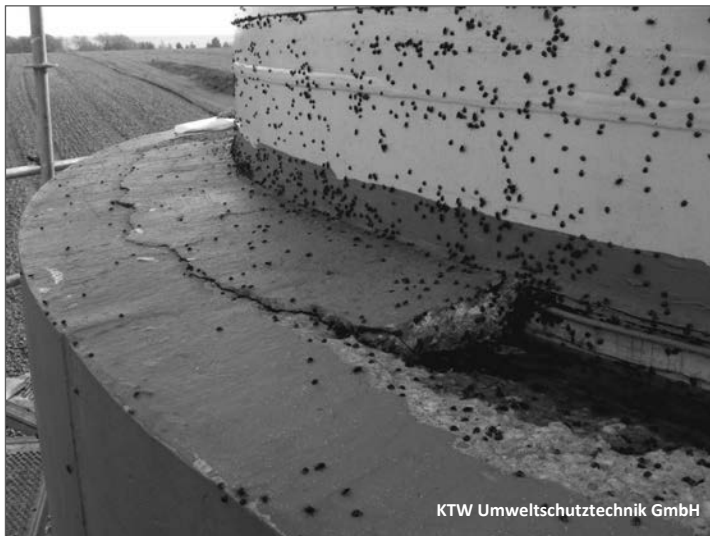
Bild 2: Abgeplatzter Beton umlaufend am Fundamenteinbauteil
