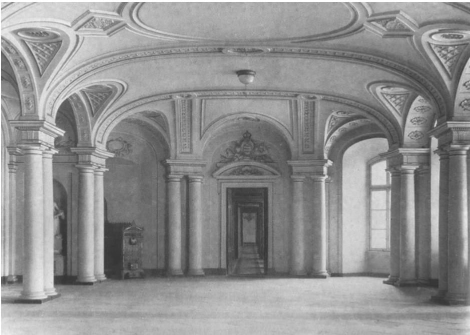
Abb. 32 Philippe de La Guépière: Neues Schloss Stuttgart, Vestibül, Zustand vor 1944.
