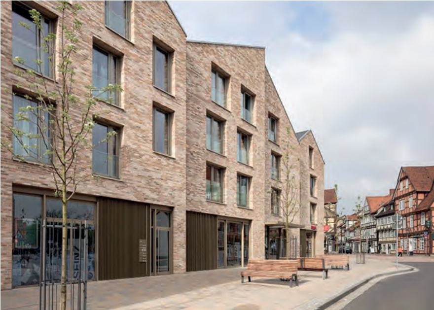
Abb. 2: Quartier Village – ehemaliges Feuerwehreal (Foto: picture_press_foto – Till Schuster)
