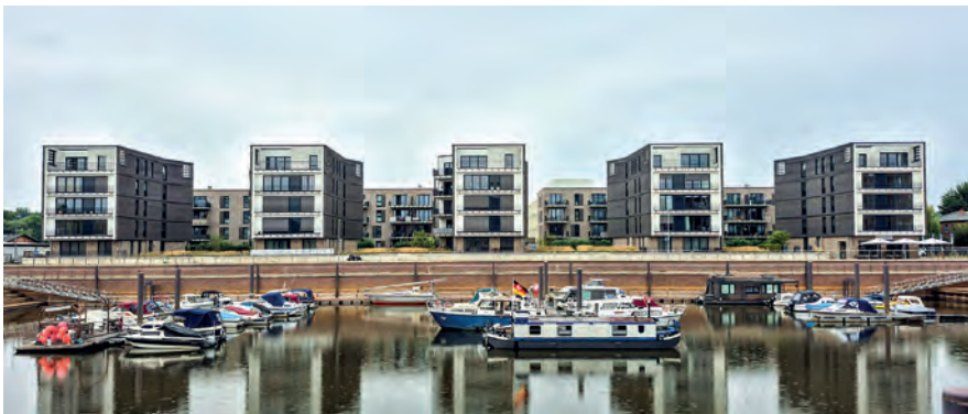
Abb. 5: Umsetzung Allerinsel 1. Bauabschnitt (Foto: U. Kinder)
