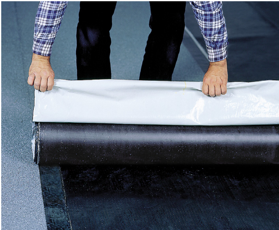
Bild 12: Verlegung im Kaltselbstklebverfahren (Bild: vdd e. V., Frankfurt)
