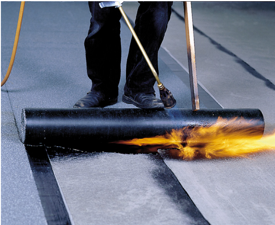
Bild 11: Verlegung im Schweißverfahren (Bild: vdd e.V., Frankfurt)
