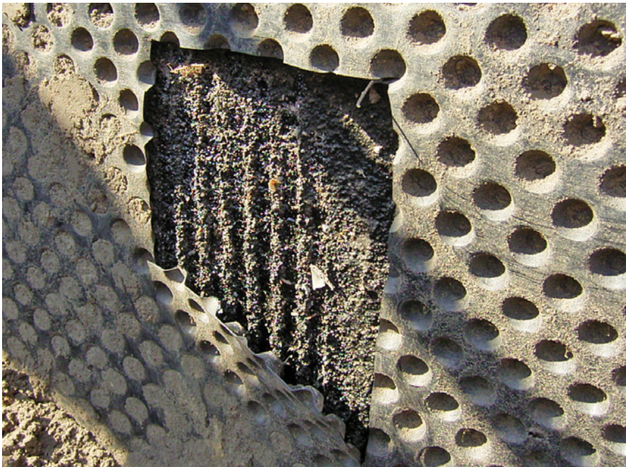
Bild 51: Furchenartiger Abrieb einer KMB durch Abrutschen einer ungeeigneten, unkaschierten Noppenfolie (Bild: Oster, IFDB, Berlin)
