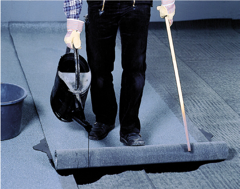
Bild 13: Verlegung im Gießverfahren (Bild: vdd e.V , Frankfurt)
