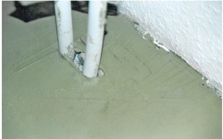
Abb. 28: Die Isolierummantelung wurde bündig mit Oberkante Estrich abgeschnitten. In der Folge ist die Spachtelmasse zwischen Isolierummantelung und Heizungsrohr gelaufen.
