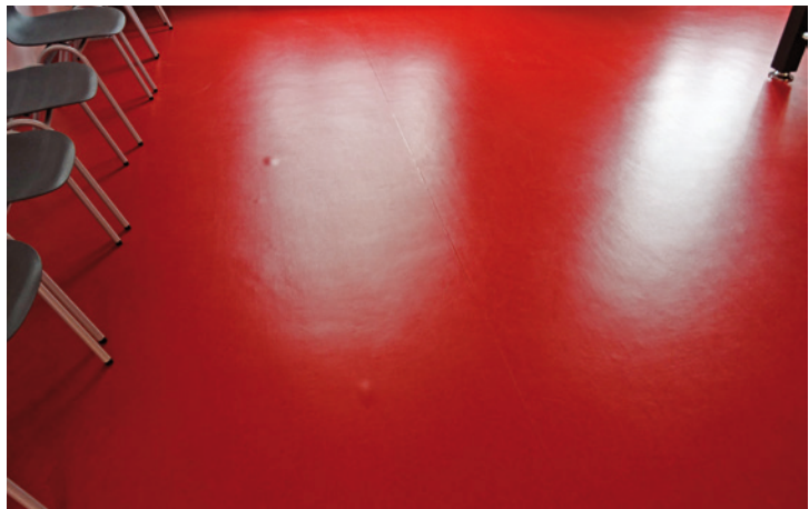
Abb. 54: Bei oberflächlich kleinen Blasen wurde der elastische Belag zu früh eingelegt
