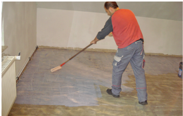
Abb. 35: Die Auswirkungen von Fehlern beim Grundieren sollte der Bodenleger nicht unterschätzen
