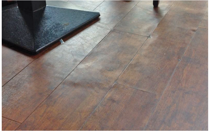
Abb. 55: Blasen und Beulen im elastischen Belag durch zu hohe Untergrundfeuchte
