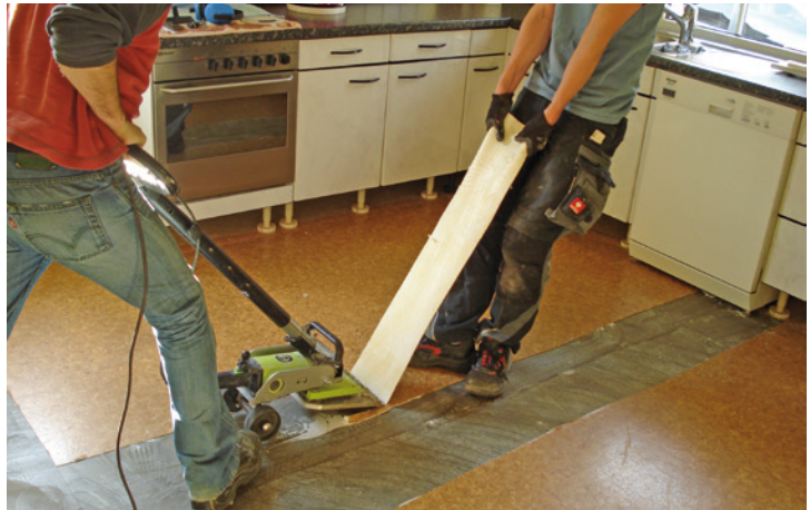
Abb. 57: Aufwändiges mechanisches Entfernen des Altbelages
