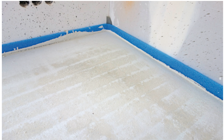
Abb. 8: Sinterschicht auf einem neu eingebauten beheizten Calciumsulfatfließestrich
