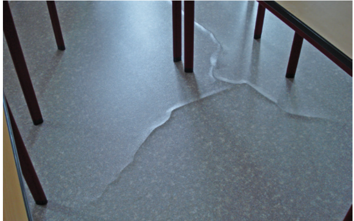
Abb. 11: Die Scheinfugen wurden zu früh verharzt. Das führte zur berühmten berüchtigten Würmchenbildung im elastischen Belag. Der Belag musste im gesamten Raum erneuert werden.
