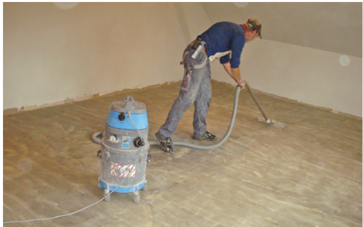
Abb. 37: Das Absaugen des Untergrundes ist zwingend erforderlich
