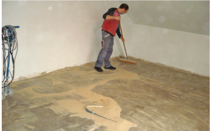
Abb. 36: Überschüssiger Quarzsand ist zu entfernen
