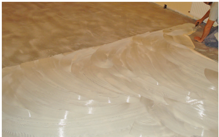
Abb. 60: Das Beachten der Ablüfzeiten und die richtige (nicht abgenutzte) Klebstoffzahnung sind Voraussetzung für eine fachgerechte Klebung der Bodenbeläge
