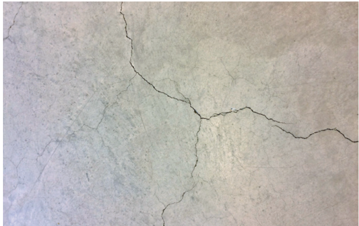
Abb. 18: Risse in einem neu eingebauten Zementestrich
