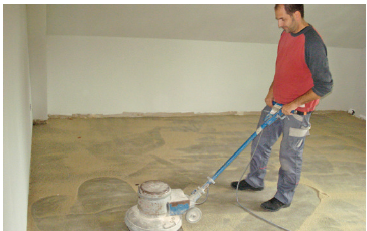
Abb. 31: Durch das Einstreuen von Quarzsand auf den Untergrund lassen sich alte Klebstoffreste besser entfernen
