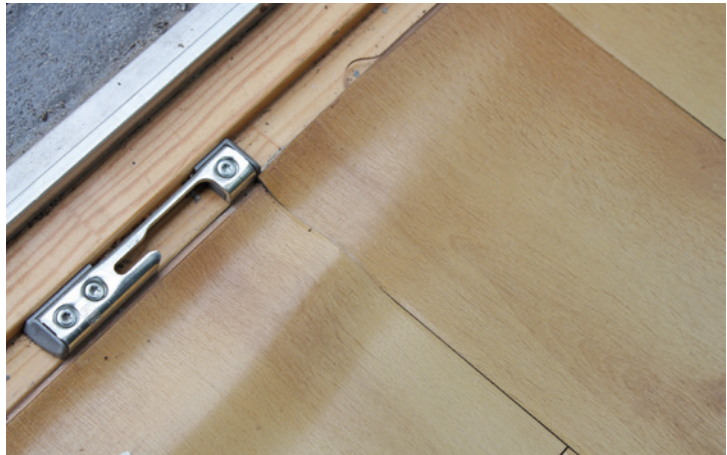
Abb. 5: Ablösung der PVC-Designbeläge durch zu hohe Untergrundfeuchte
