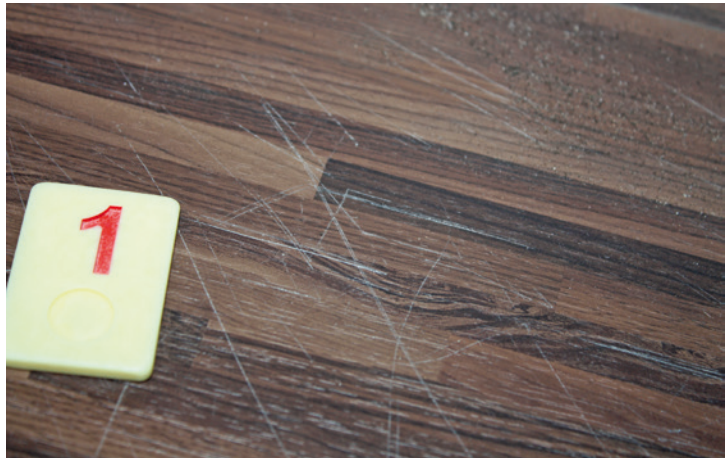
Abb. 53: Extrem zerkratzte Belagsoberflächen lassen sich nicht retuschieren und haben unterschiedliche Ursachen
