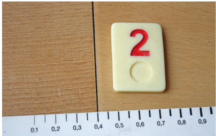
Abb. 50: Fugenbreiten bis 0,5 mm in PVC-Designbelägen gelten als Hinnehmbare Unregelmäßigkeiten
