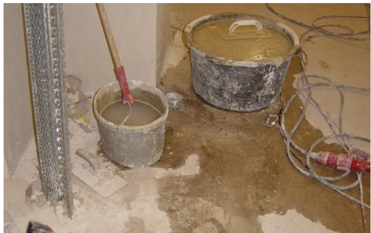
Abb. 4: Nachträglich eingedrungene Feuchtigkeit in den Untergrund durch andere Baugewerke
