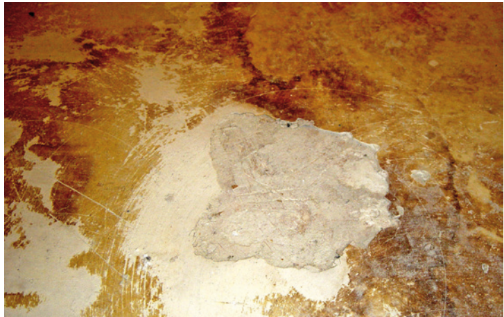
Abb. 29: Wenn Sulfitablaugekleber fest mit dem Untergrund verbunden sind, können sie mit Reaktionsharzgrundierungen überarbeitet werden
