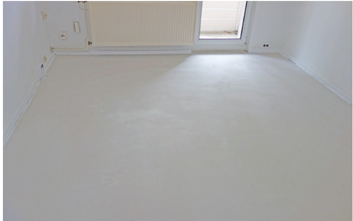
Abb. 1: Normaler Zementestrich oder Schnellzementestrich? Optisch gibt es keine Unterscheidungsmerkmale, hier muss der Bodenleger den Estrichleger oder Bauherrn fragen, welcher Estrich tatsächlich eingebaut wurde.
