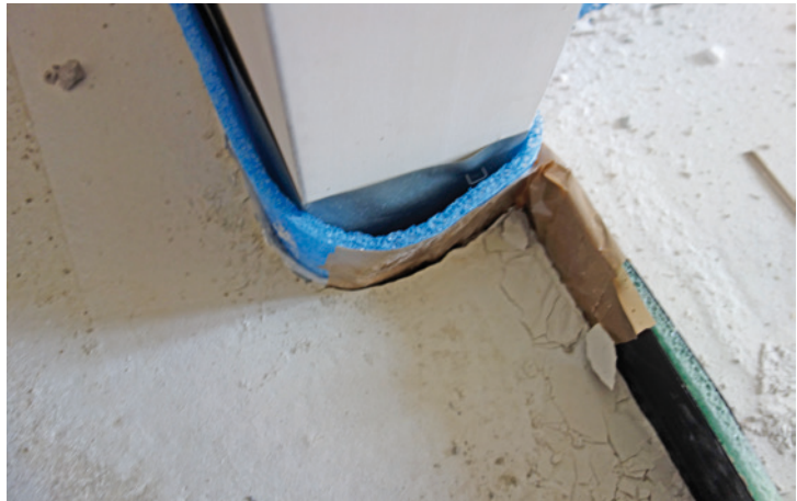
Abb. 16: Nicht fachgerecht ausgebildeter Randdämmstreifen
