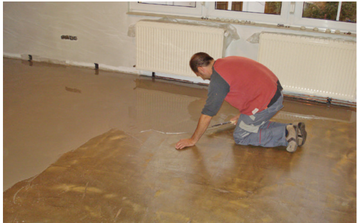
Abb. 42: Beim Überspachteln alter Klebstoffreste mit geeigneten mineralischen Spachtelmassen sollte die Schichtdicke fünf Millimeter nicht überschreiten und mindestens 2 Millimeter betragen
