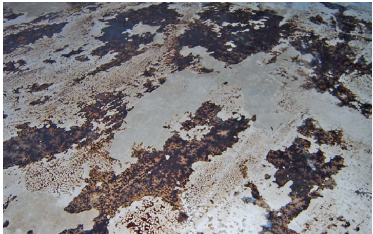
Abb. 30: PAK-haltige Kleber werden aufwändig entfernt
