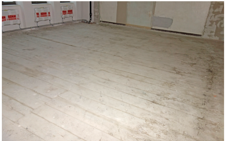
Abb. 33: Dielenböden müssen bei der Verlegung mit Oberbelag hinterlüftet werden
