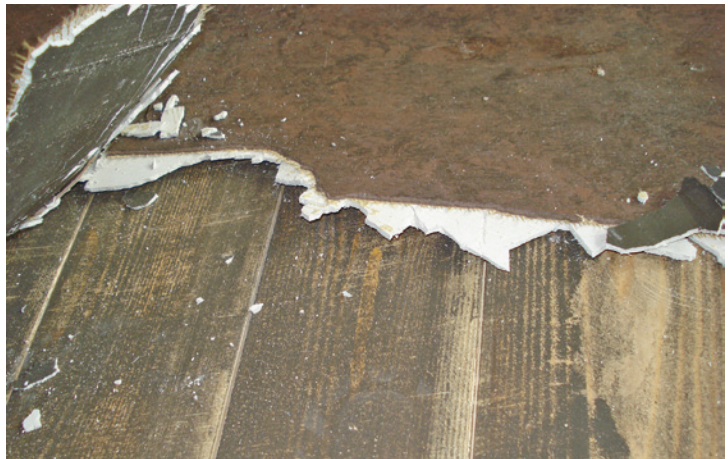
Abb. 3: Die Gipsspachtelmasse hat sich aufgrund der zu hohen Feuchte des neu eingebauten Dielenbodens vom Untergrund abgelöst.
