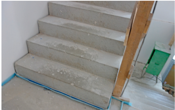
Abb. 15: Bewegungsfuge zwischen Stahlbeton-Treppenlauf und Stahlbeton-Treppenpodest
