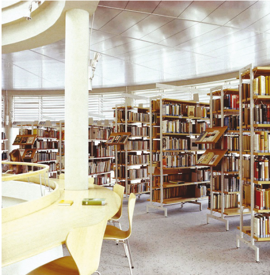
Abbildung 9: Beispiel einer Tagesbelichtung durch Umlenkklammern und Spiegeldecke (Bücherturm Neuburg a. d. D., Arch. N. Gänslar).
