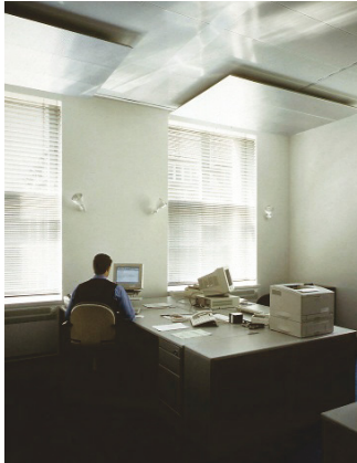
Abbildung 15:Doppelsystem mit Lichtlenkung und Ausblendung. (Deutsche Bank Frankfurt; ABB Architekten)
