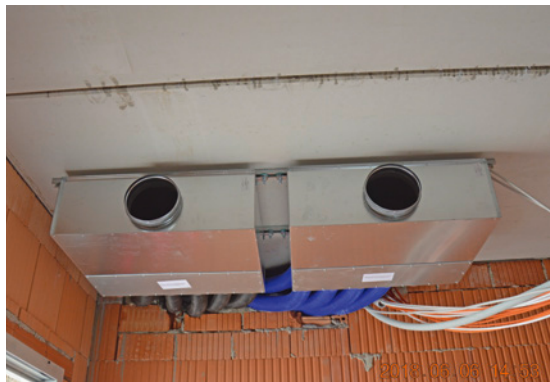
Bild 12 Nicht abgedeckte Öffnungen der Luftverteiler ermöglichen den baustellentypischen Schmutzeintrag und sind nebenbei auch beliebter Nistort für unsere gefiederten Freunde.
