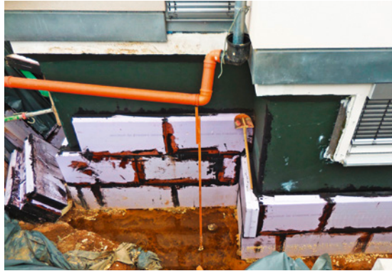
Bild 9 XPS-Perimeterdämmung, vollflächig verklebt und gespachtelte Fugen
