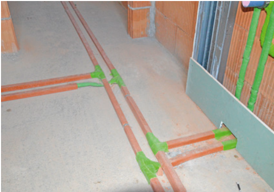
Bild 10 In die Betondecke eingespitzte Leitungen im Kreuzungsbereich
