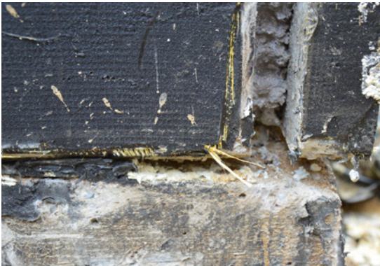
Bild 7 Aufstandsuge nach Auskratzen des PU-Ortschaums im Zuge der Kellersanierung
