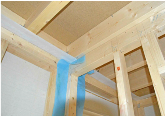
Bild 4 Leichte Bauart in Holzständerbauweise – hier Fertighaus als Ausbauhaus. Der Einbau der Wärmedämmung erfolgt durch den Bauherrn.
