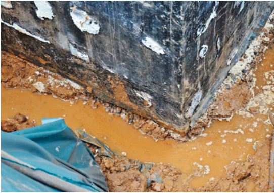
Bild 6 Undichter Betonkeller nach vollständiger Freilegung
