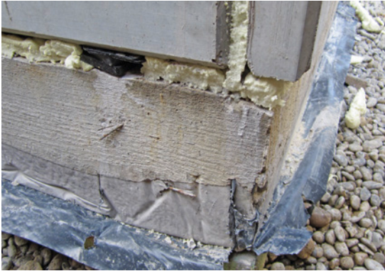
Bild 5 So sollten die Aufstandsugen der Wandelemente eines Fertiggkellers nicht aussehen: PU-Schaum hat dort nichts verloren.
