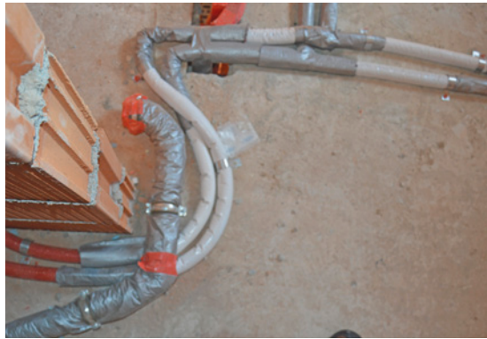
Bild 11 Oben und unten: Sich kreuzende, nicht in die Decke eingespitzte Lei- tungen
