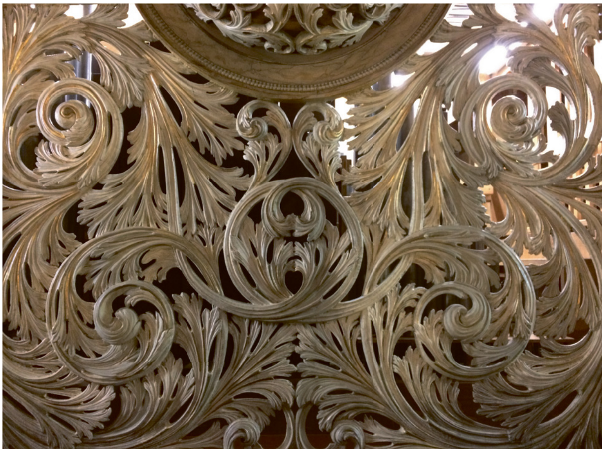
Abb. 81 Der historische Prospekt der Orgel in St. Cyriakus zu Geseke ist im Vergleich zu vielen anderen Gehäusen sehr luftdurchlässig
