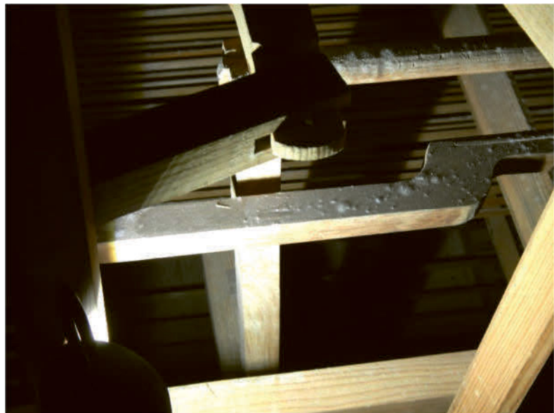
Abb. 12 Probestelle Messstelle 3, Umlenkholzer 50 cm hinter Spieltisch, fluffiges Mycel auf Oberseite
