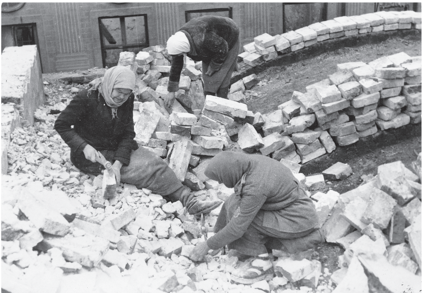
5 Fremdarbeiterinnen aus Osteuropa beim Wiederaufbau der Residenz. Tino Walz. 1945. Fotoarchiv Tino Walz
