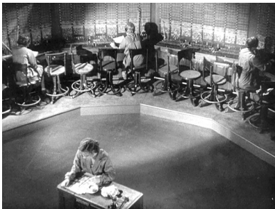
Grand Hotel (1932), Still Hotelhalle [0:14:04] bzw. Still Telefonzentrale [1:37:38].
