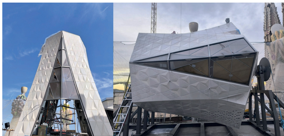
Bild 13. Pyramidenförmige Erhöhungen auf den Fliesen und Glasseiben am Fust (links) und am Arm (rechts).
