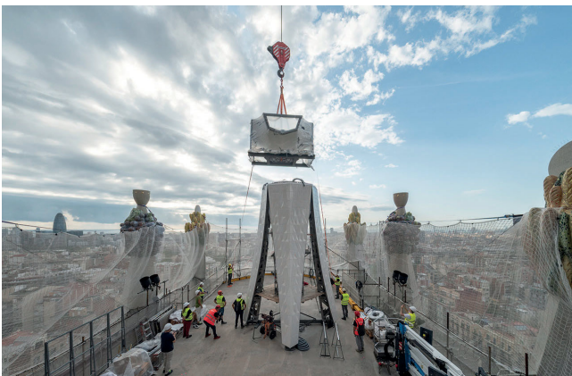
Bild 19. Montage des Nukleus-Unterteils an die Fußkonstruktion Foto: Fundació Junta Constructora del Temple Expiatori de la Sagrada Família Fig. 19. Installation of the Lower Nucleus Element to the Fust Source: Fundació Junta Constructora del Temple Expiatori de la Sagrada Família
