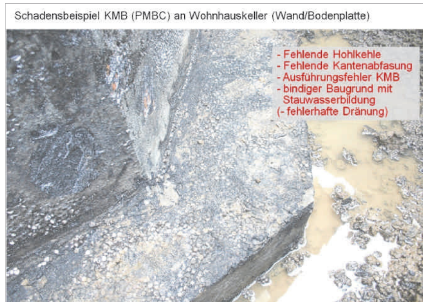
Abb. 1: Fehler an KMB-Abdichtungen
