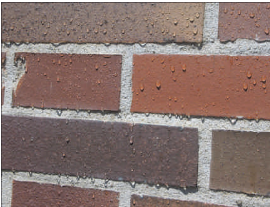
Abb. 5: Verifizierung der Schlagregenschutzprüfung, zum Beispiel mittels Benetzungstest
