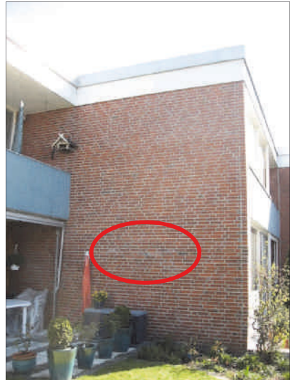
Abb. 7: Feuchtigkeitsschaden mit Schimmelpilzbefall hinter einem Bild auf einer raumseitig mit Kondensat tolerierender Dämmplatte energetisch ertüchtigten Wandoberfläche durch fehlenden Schlagregenschutz der einschaligen Außenwand, erkennbar unter anderem auch an weißen (rot markierten) Kalkausblühungen im Fugenbereich (Bildquelle: Frank Eßmann, Mölln)
