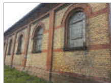
Anlege- und Hinterfüllmörtel Bestandsziegelmauerwerk
