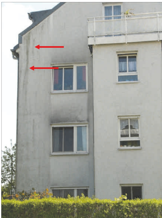
Abb. 1: Mikroorganismenbeläge durch fehlerhaft montierte Ortsgangverblechung begünstigt
