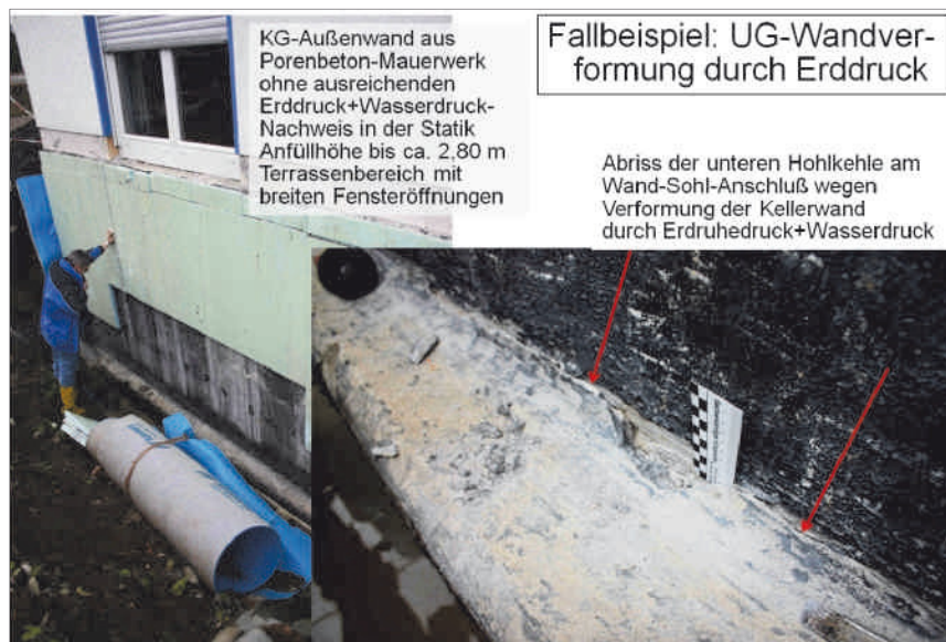
Abb. 3: Erddruck verformt Kellerwand und lässt KMB-Abdichtung einreißen
