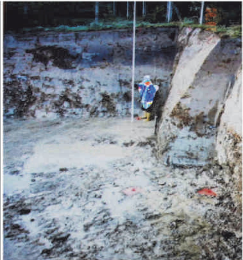
Abb. 4: Fehlerhaftes Baugrundgutachten verursacht sehr teure Kosten der Dränwasserableitung
