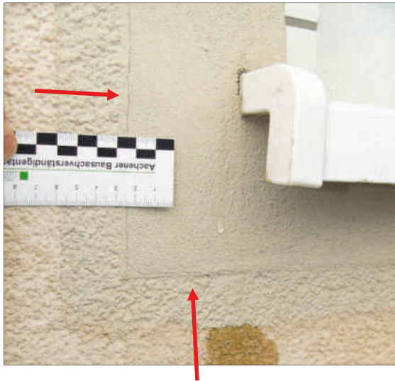
Abb. 7: Linienförmig gerade Haarrisse neben den Fensterfaschen
