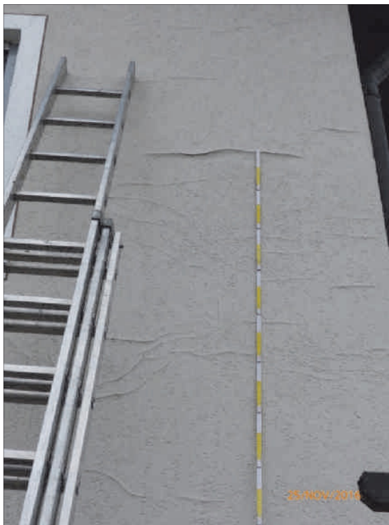
Abb. 6: Ablösung des Kunstharzputzes mit dem Anstrich entlang der Haarrisse
