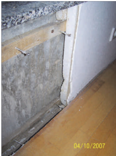
Abb. 8: Feuchteintrag durch Hinterströmung der diffusionshemmenden (Kondensat begrenzenden) Dämmschicht infolge einer Luftundichtigkeit, verursacht durch Steckdosen im Dämmstoff, und Kondensation der durch Konvektion einströmenden Raumlufte im Luftspalt (Bildquelle: Achim Bauer, Mannheim)
