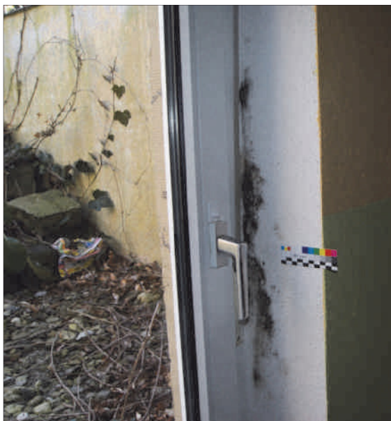
Abb. 15: Tauwasserschaden auf einer ungedämmten Fensterleibung infolge Verstärkung der Wärmebrücke bei einer von innen gedämmten Kellerwand aus Beton (Bildquelle: Andreas Kramme, Bielefeld)
