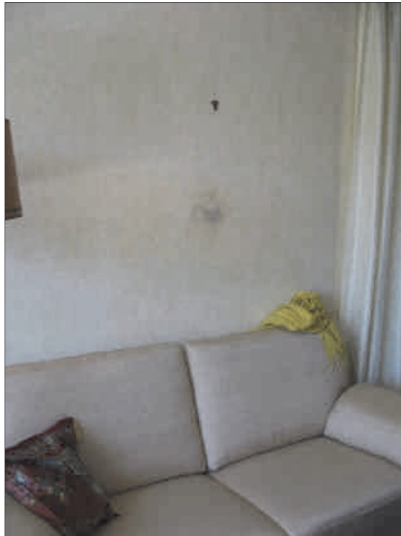
Abb. 7: Feuchtigkeitsschaden mit Schimmelpilzbefall hinter einem Bild auf einer raumseitig mit Kondensat tolerierender Dämmplatte energetisch ertüchtigten Wandoberfläche durch fehlenden Schlagregenschutz der einschaligen Außenwand, erkennbar unter anderem auch an weißen (rot markierten) Kalkausblühungen im Fugenbereich (Bildquelle: Frank Eßmann, Mölln)
