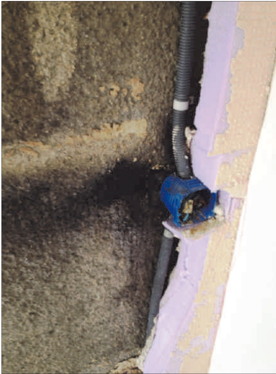
Abb. 9: Feuchteintrag infolge Durchströmung von Öffnungen in der diffusionshemmenden Dämmschicht, verursacht durch Steckdosen, führen in diesen Bereich zu Kondensation und (zunächst unentdecktem) Schimmelpilzbefall (Bildquelle: Geri Bürkli, Neuenkirch/Schweiz)
