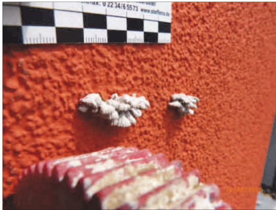
Abb. 5: Fruchtkörper eines holzerstörenden Pilzes – gewachsen durch einen kaum erkennbaren Haarriss in der Putzschicht eines Holzfaserverbunds
