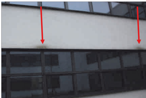
Abb. 9: Mikroorganismenbesiedlung im Fenster-Sturzbereich
