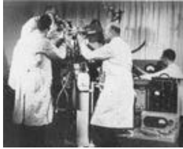
Abbildung 12: Anordnung zur Zeitdehneraufnahme mit 3.000–4.000 B/s, 1963
