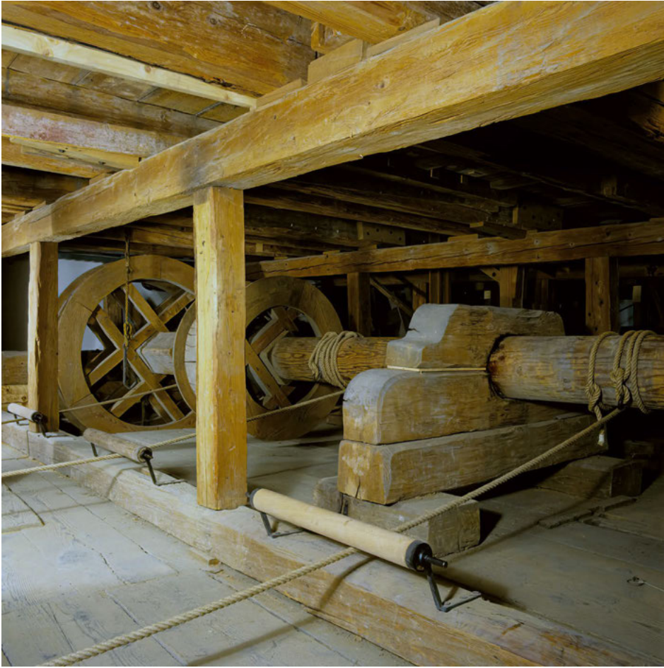
Abb. 2 Unterbühne, zentraler Wellbaum. Ludwigsburg, Schlosstheater.
