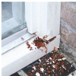
Typische Holzschäden im unteren Bereich von Holzfenstern
