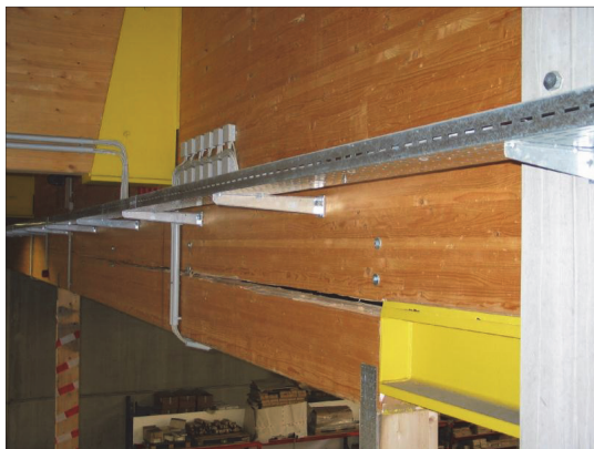
Abb. 3: Ansicht eines durchgerissenen Trägers aufgrund Querkzugversagens am ausgeklinkten Auflager
