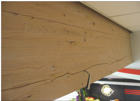
Abb. 4: Ansicht eines Klebfugenrisses (oben) und eines Holzrisses (unten) in einem BSH-Querschnitt
