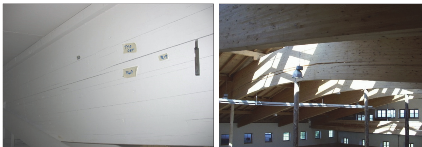
Abb. 1a, b: Ansichten von BSH-Trägern mit Schäden durch Rissbildungen a) ausgeprägtes Rissvorkommen mit überwiegend geringen Risstiefen einer beheizten Halle b) Durchriss eines gekrümmten Trägers einer Reithalle
