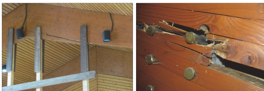
Abb. 2: Ansicht eines Trägersversagens im Anschlussbereich des Firstknotens a) Trägerdurchriss parallel zu den unteren Lamellen im Anschlussbereich b) Detailansicht des Rissverlaufs im Bereich der stabförmigen Verbindungsmittel
