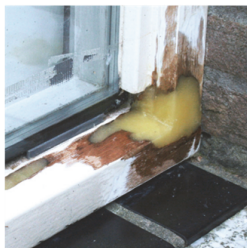
Ausbesserung mit Repair Care: erhalten statt austauschen
