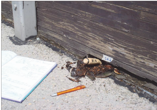
Abb. 10: Detailansicht eines exemplarischen LESS-Belag-Trägerübergangs-Schaden (Schadenstyp 1c)
