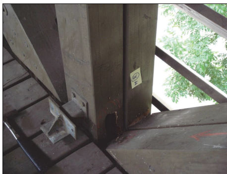
Abb. 14 a, b: Schadenstyp 4a Hirnholz-Kapillarsorptions-Schaden
