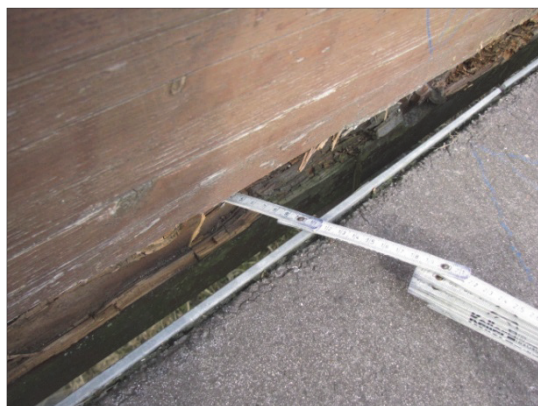
Abb. 12: Detailansicht eines exemplarischen LESS-Träger-Belag-Abstands-Schaden (Schadenstyp 1e)
