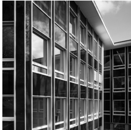
Abb. 5: Fassadennachbau, Amtshaus Parkring in Zürich. Quelle: Ernst Schweizer AG, Metallbau.
