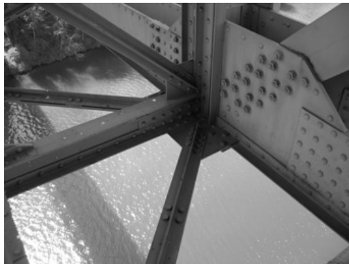
Abb. 1: Eisenbahnbrücke über den Rhein bei Eglisau, Ersatz von Nieten durch Schrauben. Foto: Werner Köhler.
