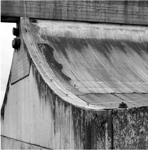
Abb. 4: Dach des großen Hörsaalgebäudes, Campus Lahnberge der Universität Marburg. Quelle: Bussenius & Reinicke / StandOut.de.
