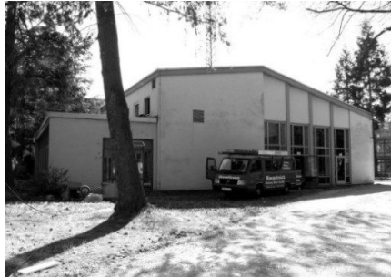
Abb. 41: Casino-Gebäude, Josef-Kammhuber-Kaserne, vor dem Umbau
