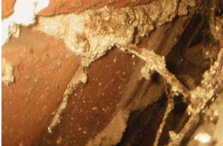
Endoskopieaufnahme eines Hohlraumes mit Mauerwerksanker
