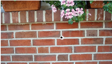
Beim Kleinlochverfahren werden die Bohr- löcher in der Schnittstelle von Lager- und Stoßfuge eingebracht.
