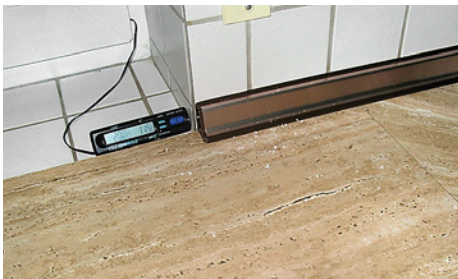
Undichtigkeiten im Bereich des Rolladenkastens
