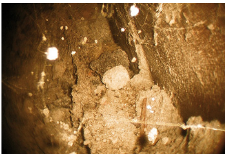
Mörtelreste/Bauschutt im Hohlraum
