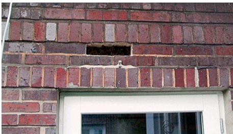
Für das Großlochverfahren werden ganze Steine aus der Fassade entnommen.
