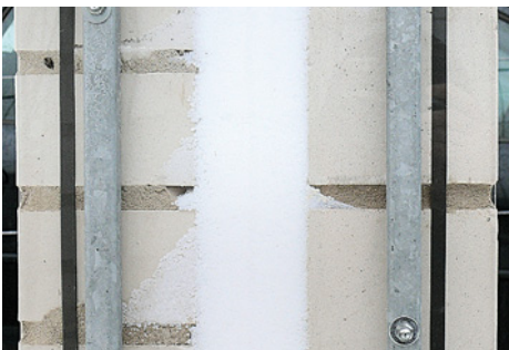
Aerogel in der Hohlschicht
