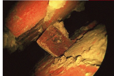
Endoskopieaufnahme → im Bereich der vermuteten Fehlstelle ist tatsächlich keine Dämmung vorhanden!
