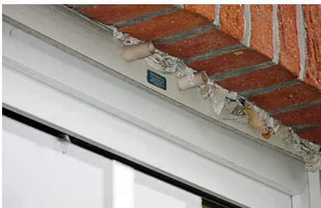
Undichtigkeit im oberen Anschlussbereich des Fensters
