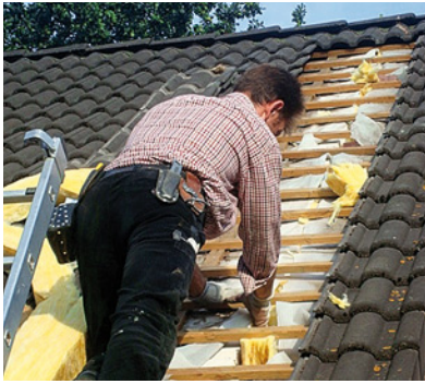
Abdichten der Hohlschicht am Giebel
