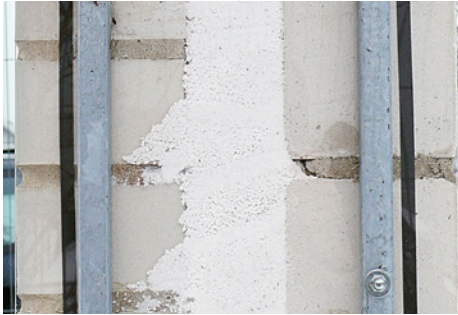
Bläherlite in der Hohlschicht
