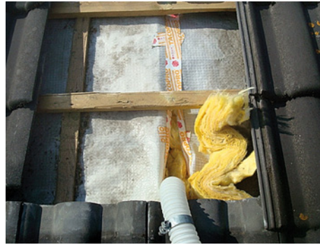
Einfüllen des Dämmmaterials über das Dach
