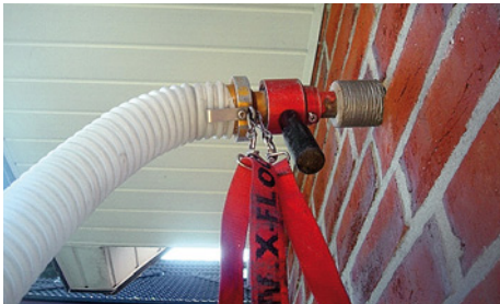
Einfüllen des Dämmmaterials mit dem Klein- lochverfahren
