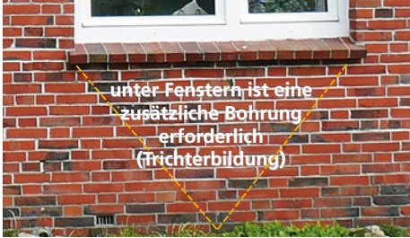
Unterhalb von Fenstern kann eine Trichterbildung des Dämmmaterials entstehen. Daher ist hier mindestens ein zusätzliches Bohrloch anzuordnen.
