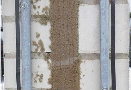
Mineralwolle (MW) in der Hohlschicht
