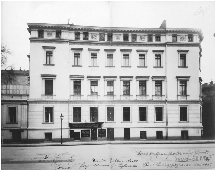
Abb. 1: Ansicht des Hauses In den Zelten 11 (Foto aus der Bauakte von 1935, Landesarchiv Berlin)
