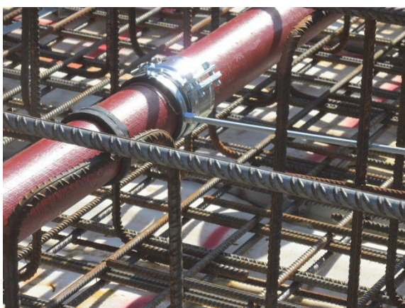
Bild 16 Horizontale Rohrbefestigung am Bewehrungskorb und Dichtmanschette aus Quellband um den Rohrquerschnitt
