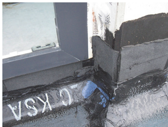
Bild 3 Bituminöser Abdichtungsanschluss an Terrassentürzarge
