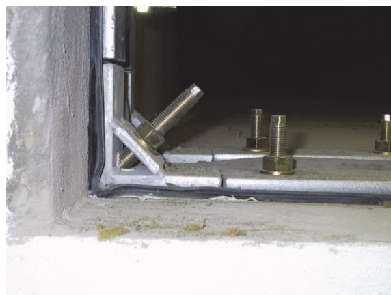
Bild 35 Beispiel für eine beidschenklige Klemmkonstruktion
