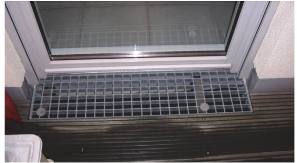
Bild 9 Roste gewährleisten eine zügige Entwässerung erst mit hohem Lochanteil
