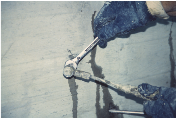
Bild 6 Nachspannen eines Injektionspackers während des Injektionsvorgangs
