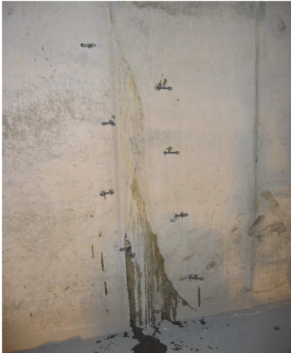
Bild 4 Riss, der über die Injektionspacker verpresst wurde
