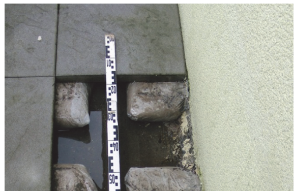
Bild 6 Platten auf Stelzlagern benötigen kein Gefälle, wohl aber die darunter verlegte Abdichtung
