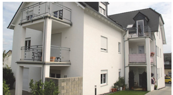
Bild 10 Durch Überdachung vor Wasserbeanspruchung geschützt liegende Anschlusssituation im Erdgeschoss und im 1. Obergeschoss
