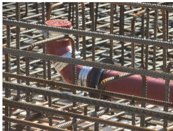
Bild 17 Dichtkragen um Rohrdurchmesser im Rohranschlussbereich
