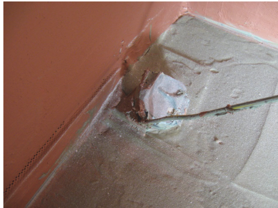
Bild 7 Detail aus Bild 6: Unzureichend eingedichtete Rohrdurchdringung unmittelbar an aufgehender Wand
