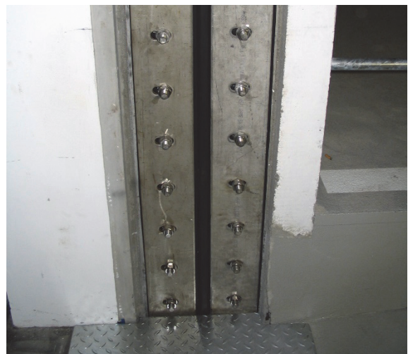
Bild 33 Beispiel für eine beidschenklige Klemmkon- struktion
