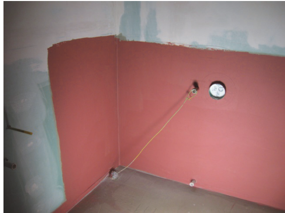
Bild 6 Verbundabdichtung im Bad mit Rohrdurchdringungen
