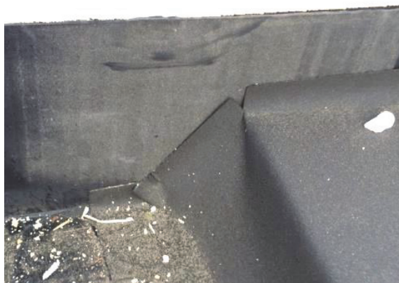
Bild 3 Abschlottungen grenzen Felder bei der Leckagesuche ein, wenn ein Schaden eingetreten ist.
