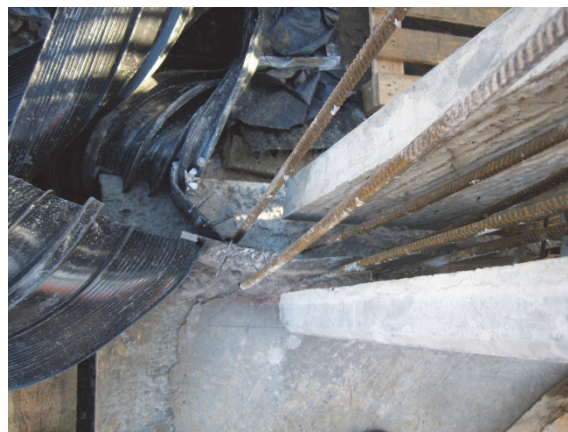
Bild 10 Unkoordinierter »Treffpunkt« von Dehnungsfugenbändern in einer WU-Betonkonstruktion
