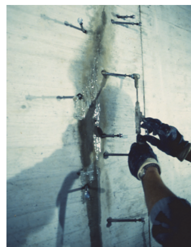
Bild 9 Rissverpressung über Injektionspacker (Beispiel)
