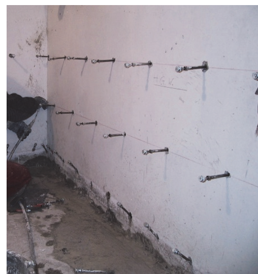
Bild 13 Flächeninjektion in ein Bauteil (Beispiel)
