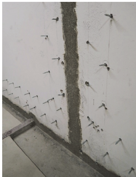
Bild 20 Verpressung der Stoßfuge einer Elementwand (Beispiel)
