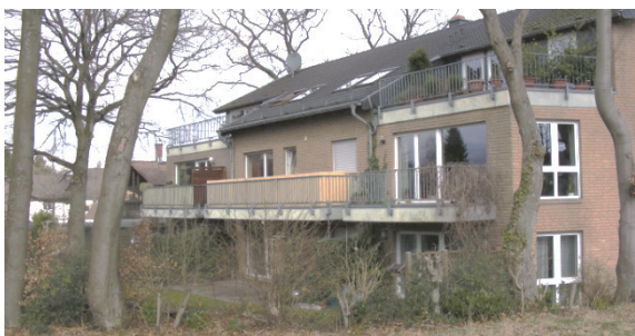
Bild 1 Unterschied zwischen Dachterrasse (oberhalb genutzter Räume) und Balkon (unterseitig luftumspült)
