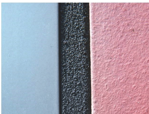
Bild 2 Dehnungsfuge mit vorkomprimiertem Fugenband abgedichtet
