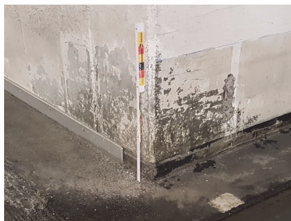
Bild 1 Schäden durch Tausalzeinwirkung infolge Spritzwasser in einer Tiefgarage [Quelle: G. Göker]
