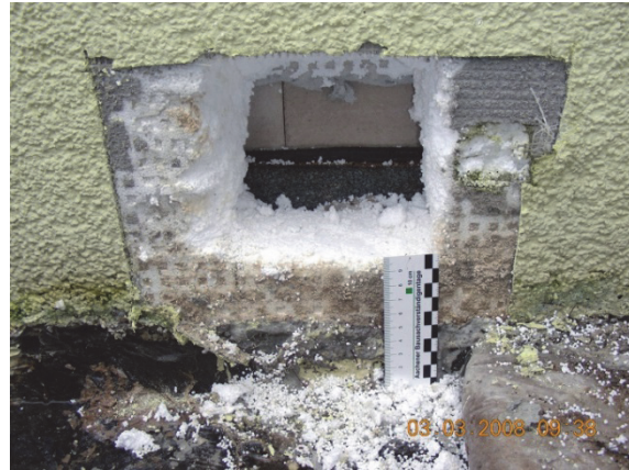
Bild 7 Vor Wassereinwirkung geschützt liegender oberer Anschluss der aufgekanteten Bitumenbahnabdichtung
