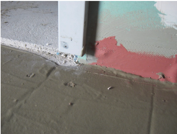
Bild 5 Badezimmertürzarge: Fehlender Abdichtungsanschluss an das Zargenprofil und die Bodenschwelle
