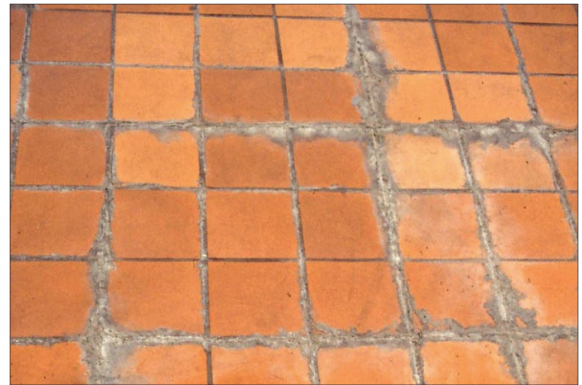
Bild 5 Deutliche Sinterspuren bei einem im Mörtelbett verlegten Plattenbelag ohne Gefälle [Bildquelle: Oswald]
