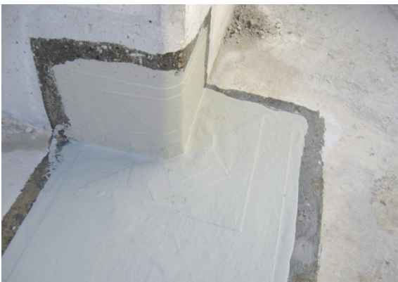
Bild 12 Flüssigkunststoffbeschichtung auf potenziell rissgefährdeten Bereichen von Leerrohrverläufen innerhalb einer WU-Betondecke
