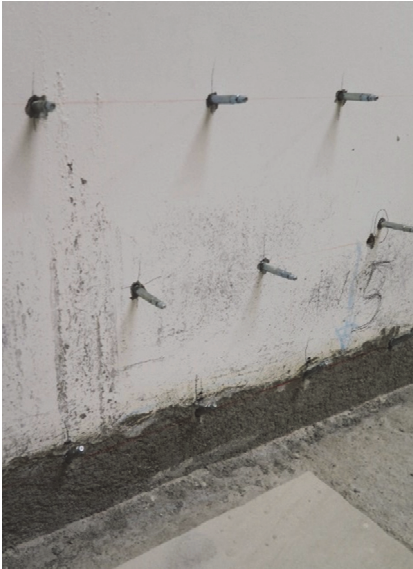
Bild 18 Verpressung der Arbeitsfuge zwischen Bodenplatte und Wand bei einer Elementwand (Beispiel)
