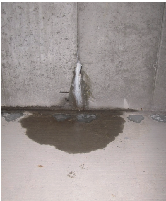
Bild 5 Undichtigkeit bei einer vertikalen Arbeitsfuge
