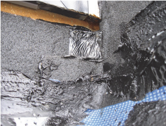
Bild 4 Detail aus Bild 3: Türzargenixel ohne ausreichende Abdichtung des Zargenprofils
