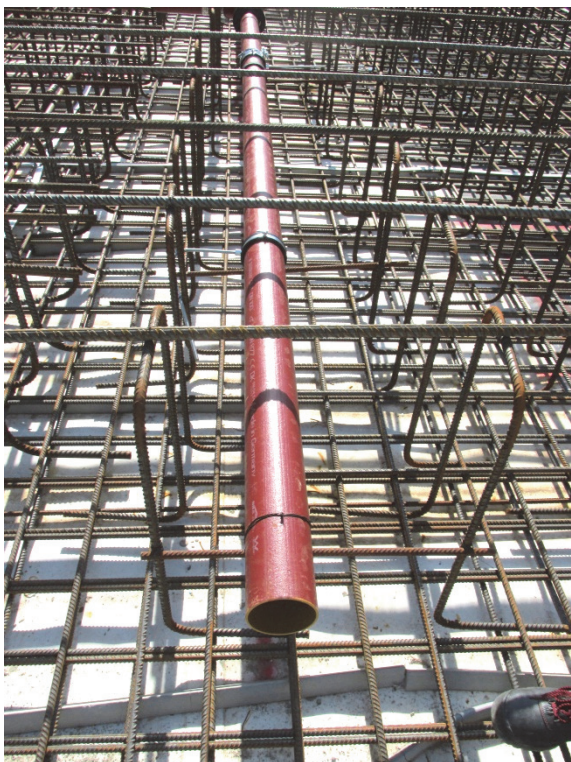
Bild 15 Bewehrungskorb und Rohrverlegung oberhalb der Frischbetonfolie
