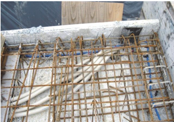
Bild 11 Bündelung von Leerrohren in einer Halbfertigteil-WU-Betondecke
