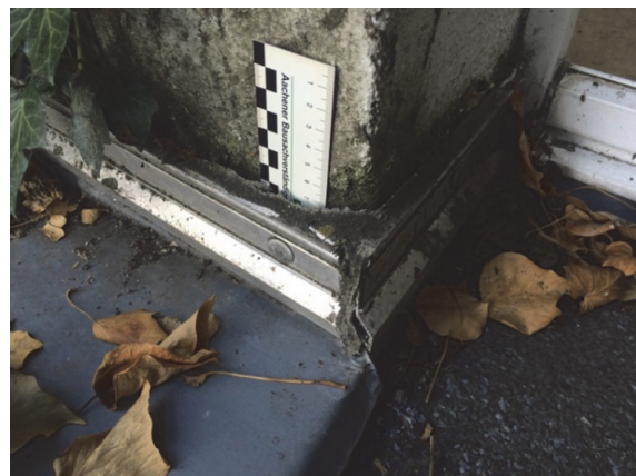
Bild 8 Dichtstofffugen sind wartungsintensiv
