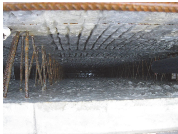
Bild 1 WU-Beton-Elementwand vor dem Ausbetonieren: obere FT-Oberfläche aufgekämmt gemäß [2], untere FT-Oberfläche unbehandelt mit Betonschlempe
