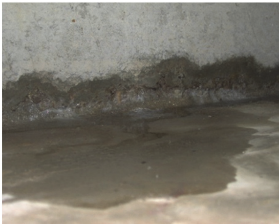
Bild 1 Undichtigkeit bei einer Arbeitsfuge (links) bzw. einer Dehnfuge (rechts)
