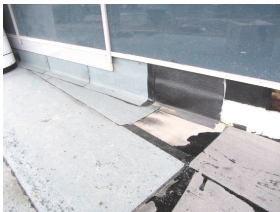
Bild 4 Wasserunterläufigkeiten werden durch vollflächige Verklebung verhindert und ein Schaden somit vermieden.
