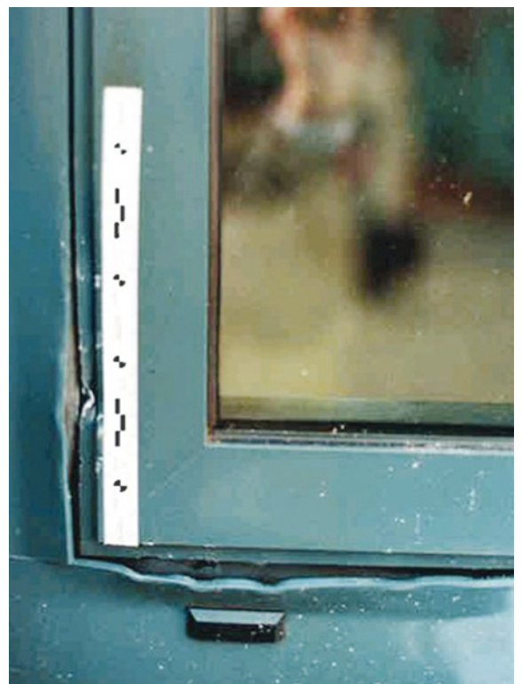
Abb. 14.25b Typische Schäden an Türelementen nach realen Einbruchversuchen [Quelle: PfB Rosenheim]
