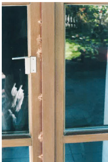
Abb. 14.7a Fenstertüre mit Blockschloss nach Angriff eines Täters
