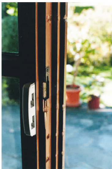
Abb. 14.7b Beschädigungen am Stand- und Gangflügel
