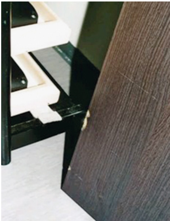
Abb. 21.1b Kantenausbruch durch Overhead-Wagen (1) sowie Tischkantenanstoß (2) an Funktionstüren in einem Hotelkonferenzraum (keine Türblätter mit Kantenschutz)
