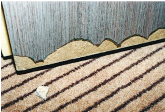
Abb. 21.1c HPL-Plattenausbrüche durch unzureichende Abfasung der unteren Türblattkante in Hotelzimmer
