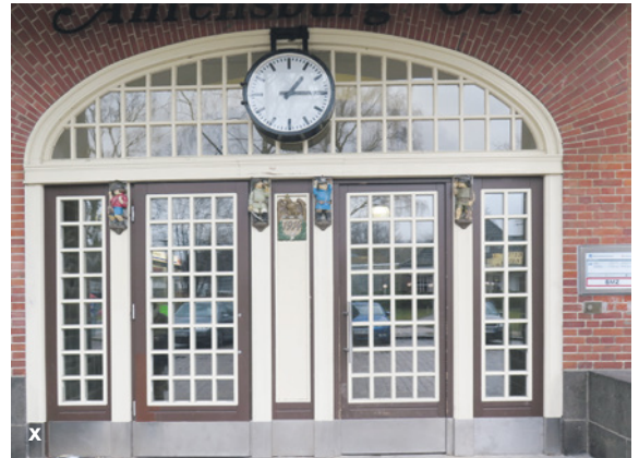
Abb. 6.1w Schlupftüre in Rundbogeneinfahrtstor mit Brief-einwurfsöffnung (nachgerüstet mit Gegensprechanlage und E-Öffner)
