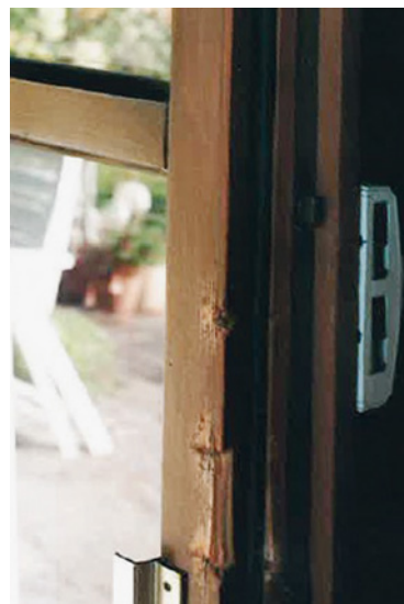
Abb. 14.7b Beschädigungen am Stand- und Gangflügel
