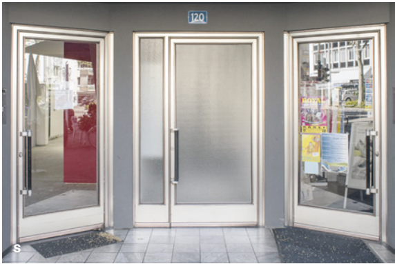
Abb. 6.1s Kombinierte Eingänge in Wohnbereiche und Geschäftsräume; Metallrahmenbauweise mit Verglasung
