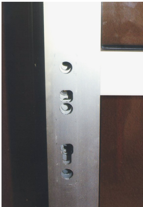
Abb. 21.1a Beispiele für Schäden an Türen: Zu große Lochbohrung für die Befestigung des Türbeschlages (⇒ lockerer Sitz), Verschiebung max. 5 mm zulässig [Quelle: PfB Rosenheim]
