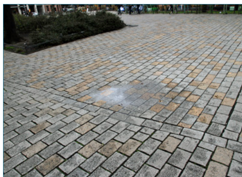
Bild 26: Mangelhafte Wasserdurchlässigkeit der Unterlage
