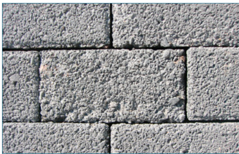
Bild 52: Beschädigte WD-Pflastersteine – Detailaufnahme aus Bild 51
