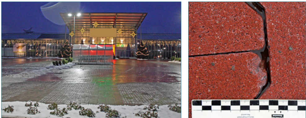
Bild 18: Kantenabplatzungen an Betonpflastersteinen eines Parkplatzes
