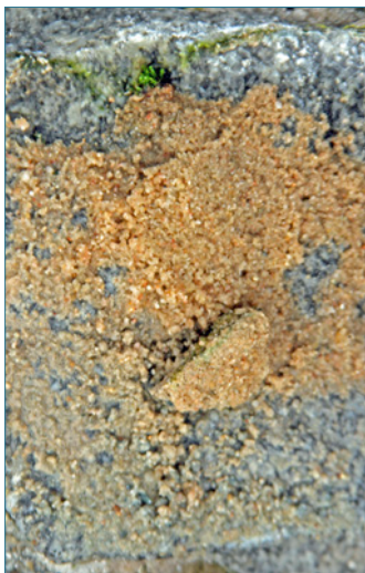
Bild 86: Verwitterung des Fugenmörtels
