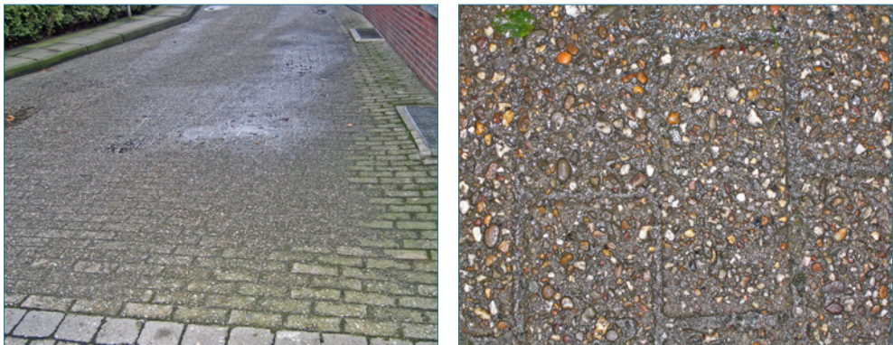
Bild 32: Altersgemäße Menge an Betonabwitterungen an einer alten Pflasterdecke
