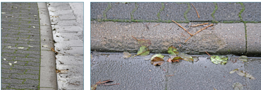
Bild 2: Durch Frost-Tausalz-Einwirkung verursachte Zementsteinabwitterungen an Bordsteinen
