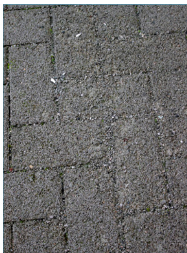
Bild 59: Abwitterungen an den WD-Steinen
