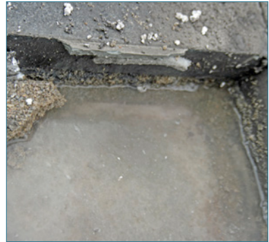
Bild 96: Mangelhafte Entwässerungsfähigkeit der Konstruktion
