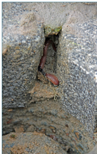
Bild 87: Ausspülung des Fugenmörtels
