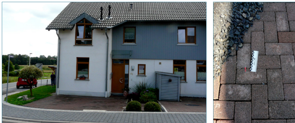
Bild 55: Abwitterungen an den WD-Steinen der Pflasterdecke auf dem Stellplatz eines privaten Wohnhauses
