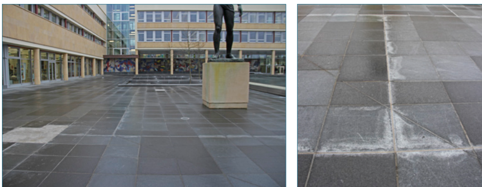
Bild 93: Pflasterdecke mit Verfärbungen an Natursteinplatten
