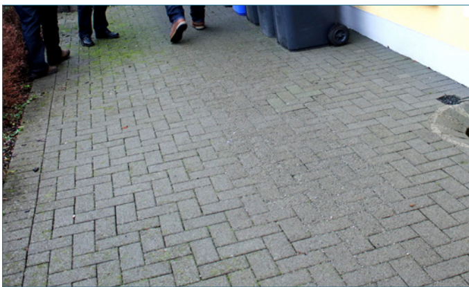
Bild 54: Frost-Tausalz-Schäden an einer nicht befahrenen Pflasterdecke, die unter Verwendung von WD-Steinen hergestellt wurde
