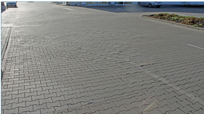
Bild 106: Vertikale Verformungen der Pflasterdecke
