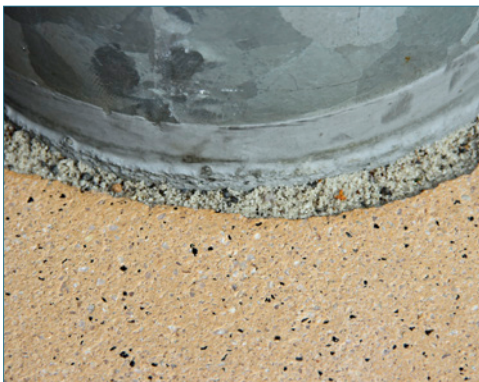
Bild 91: Fehlende Bewegungsfuge im Bereich eines aufgehenden Bauteils
