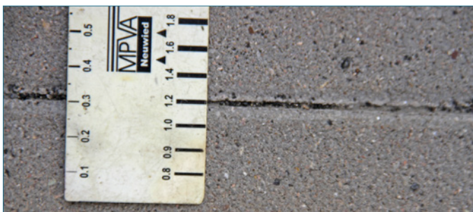
Bild 83: Fugen mit sehr geringer Fugenbreite
