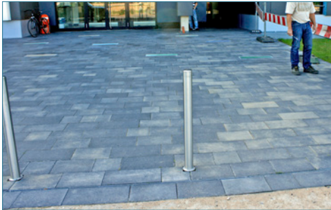
Bild 160: Verschmutztes Pflaster aus vergüteten Betonplatten
