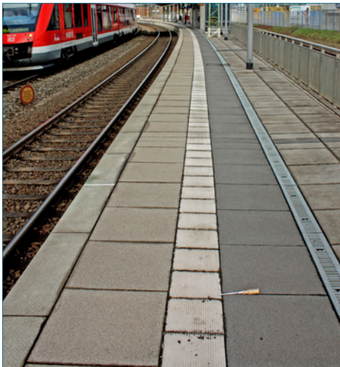
Bild 25: Witterungsbedingte Schäden am Kernbeton von Pflasterplatten
