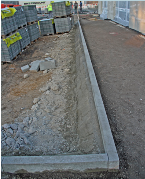
Bild 100: Übliche Verdichtung von Rückenstützenbetonen
