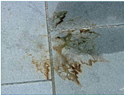
Bild 117: Verfärbung einer Betonplatte durch über lange Zeit einwirkendes Blattwerk
