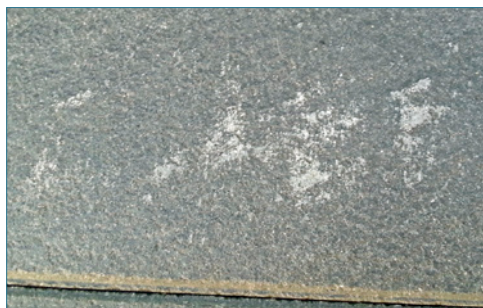
Bild 151: Verfärbung von Betonplatten durch den gebundenen Bettungsmörtel
