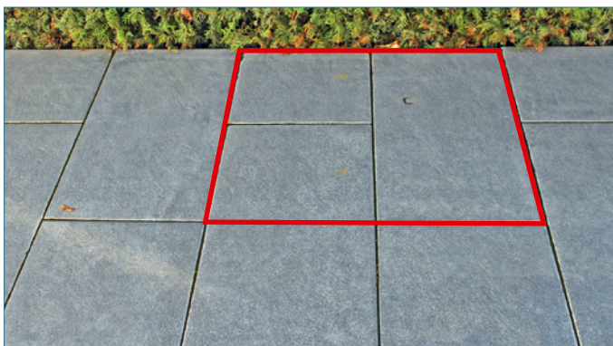
Bild 154: Mit einem Zementschleierentferner gereinigte Teilfläche
