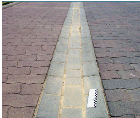
Bild 97: Rinnenanlage mit in regelmäßigen Abständen auftretenden Rissen
