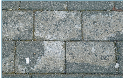
Bild 5: Schädigung der gesamten Produktoberfläche an einzelnen Pflastersteinen einer Pflasterdecke
