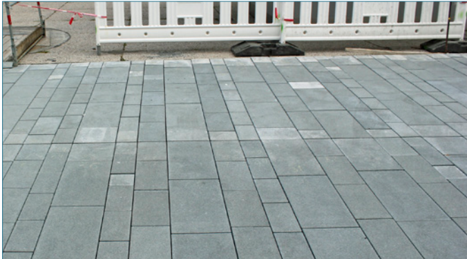
Bild 178: Durch Verschmutzungen verursachte Farbunterschiede an den Betonplatten
