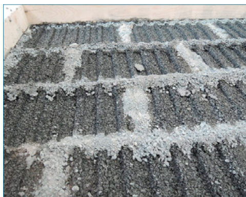
Bild 110: Verbundpflastersteine mit einer Profilierung an der Steinunterseite
