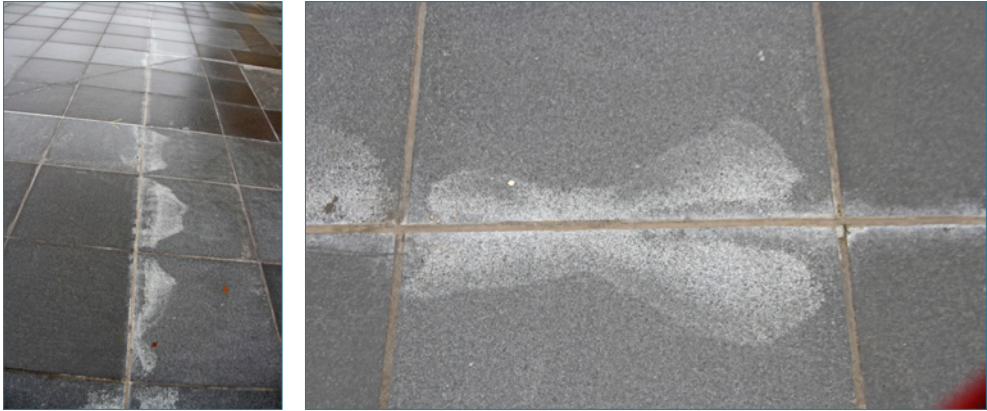
Bild 94: Ausgeprägte optische Beeinträchtigung der Natursteinplatten
