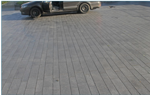
Bild 148: Aufhellung einzelner, vergüteter Betonplatten
