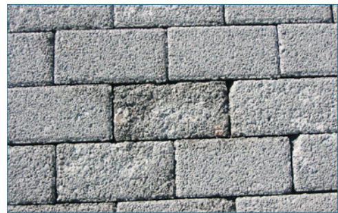
Bild 52: Beschädigte WD-Pflastersteine – Detailaufnahme aus Bild 51
