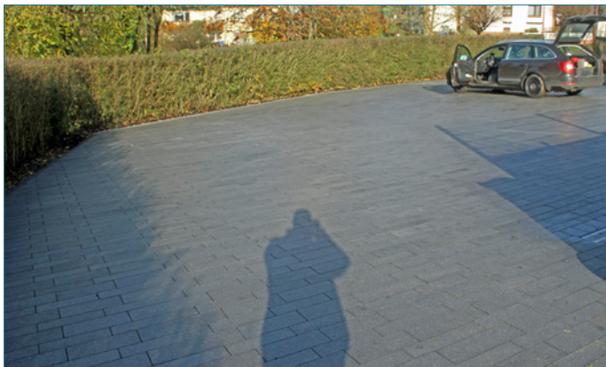
Bild 172: Bild 61: Pflasterdecke mit einzelnen verkratzten Betonplatten
