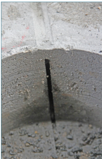
Bild 84: Fugenfüllung zwischen den Betonplatten und den Natursteinen bzw. zwischen den Betonplatten
