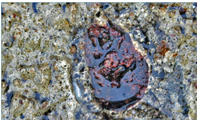
Bild 6: Zersetzliches Gesteinskorn im Zentrum einer Betonabwitterung
