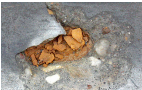
Bild 43: Zementsteinabwitterungen oberhalb einzelner verwitterungsunbeständiger Gesteinskörner
