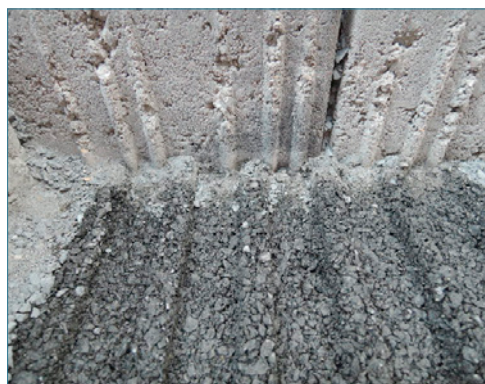
Bild 110: Verbundpflastersteine mit einer Profilierung an der Steinunterseite
