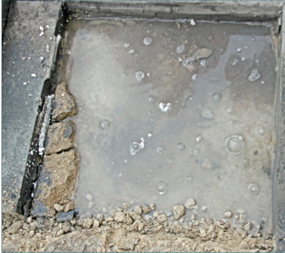
Bild 96: Mangelhafte Entwässerungsfähigkeit der Konstruktion
