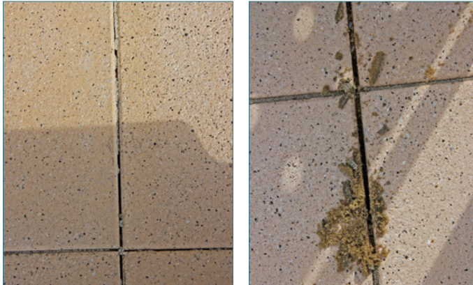
Bild 92: Zerstörung des Fugenmörtels
