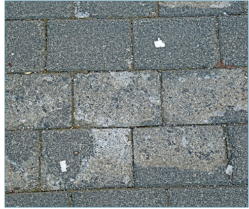
Bild 47: Flächige Zementsteinabwitterungen an Betonpflastersteinen
