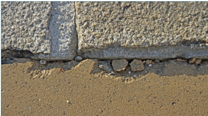
Bild 77: Kantenschäden an Betonplatten im Anschluss an eine gebundene Pflasterdecke
