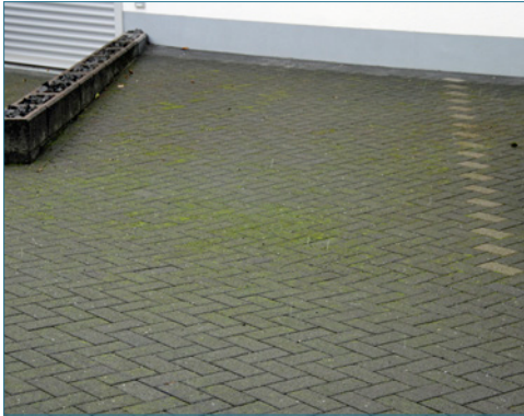
Bild 29: Steigerung des Frost- bzw. Frost-Tausalz-Angriffes durch eine nicht ausreichende Reinigung der Fugen
