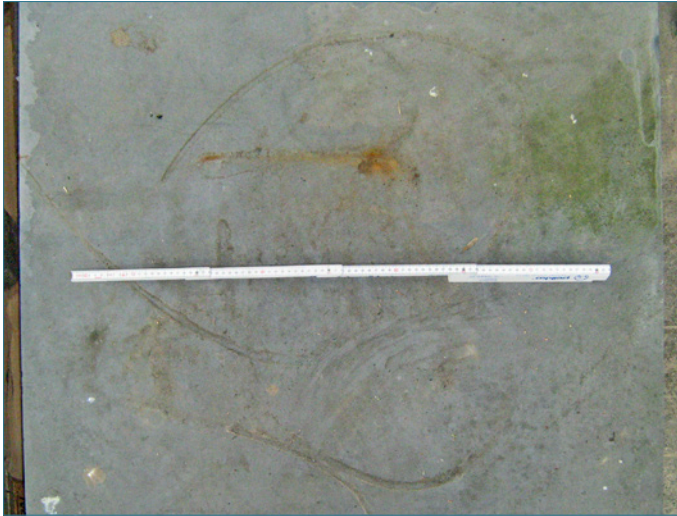
Bild 179: Abmehlen der Oberfläche vergüteter Betonplatten
