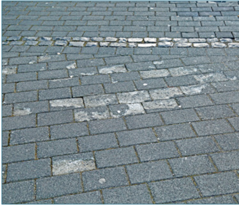
Bild 47: Flächige Zementsteinabwitterungen an Betonpflastersteinen
