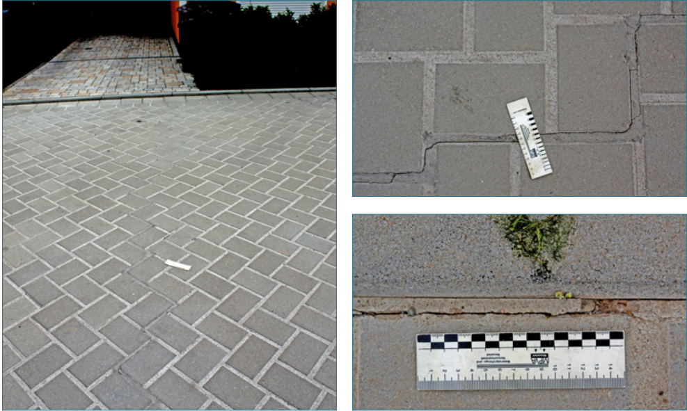
Bild 72: Rissbildung in der vollgebundener Bauweise
