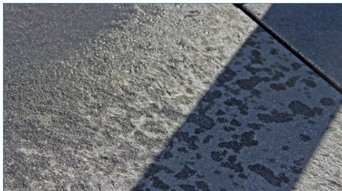
Bild 155: Die hydrophoben Eigenschaften der Oberfläche der Betonplatte sind nach deren Reinigung reduziert
