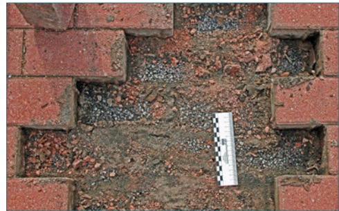
Bild 24: Witterungsbedingte Schäden am Kernbeton von Betonpflastersteinen
