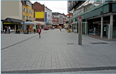
Bild 177: Durch Unterschiede im Strahlbild verursachte Farbunterschiede an Betonplatten
