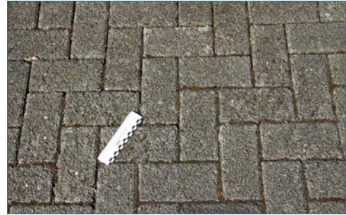
Bild 53: Frost-Tausalz-Schäden an einer befahrenen Pflasterdecke, die unter Verwendung von WD-Steinen hergestellt wurde
