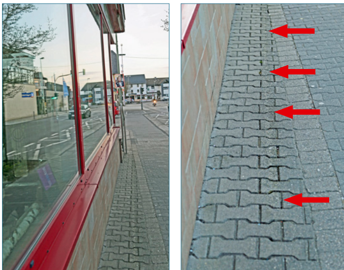
Bild 11: Verstärkte Frostschäden in besonders wassergesättigten Teilflächen
