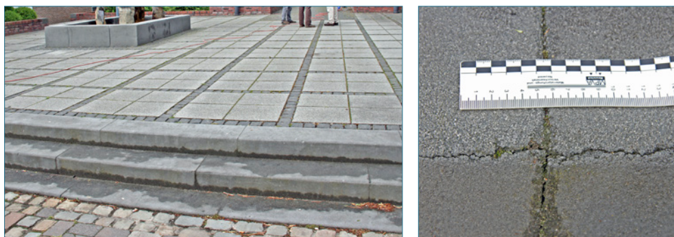
Bild 49: Sanierte Blockstufen mit neuerlichen Schäden
