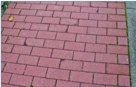
Bild 24: Witterungsbedingte Schäden am Kernbeton von Betonpflastersteinen
