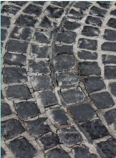
Bild 79: Gerissene Fugen im Bereich der Dehnfugenbänder
