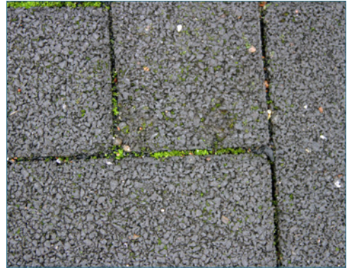
Bild 29: Steigerung des Frost- bzw. Frost-Tausalz-Angriffes durch eine nicht ausreichende Reinigung der Fugen
