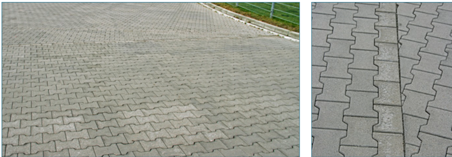
Bild 1: Durch Frost-Tausalz-Einwirkung verursachte Zementsteinabwitterungen an Betonpflastersteinen
