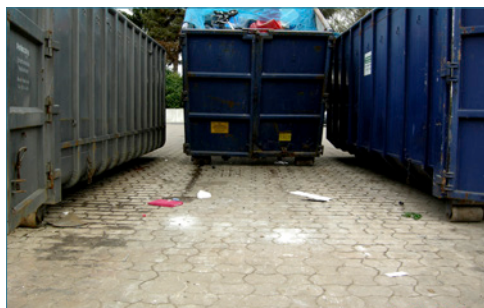
Bild 103: Pflasterdecke als Stellplatz für Container mit Stahlrollen
