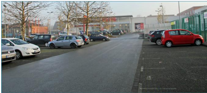
Bild 56: Unter Verwendung von WD-Steinen hergestellte Stellplätze des Parkplatzes eines Lebensmittelmarktes
