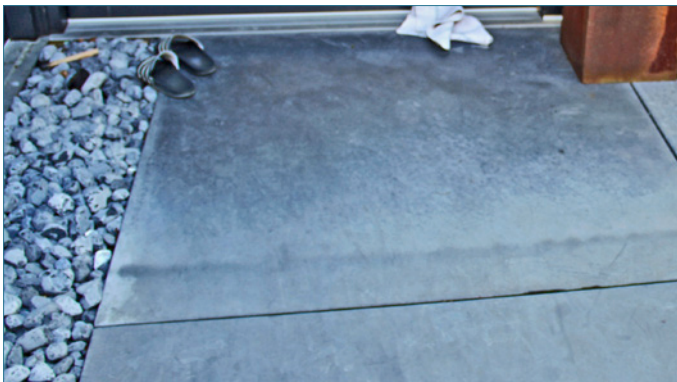
Bild 187: Dunklere Betonplatte in einem vor Witterung geschützten Bereich
