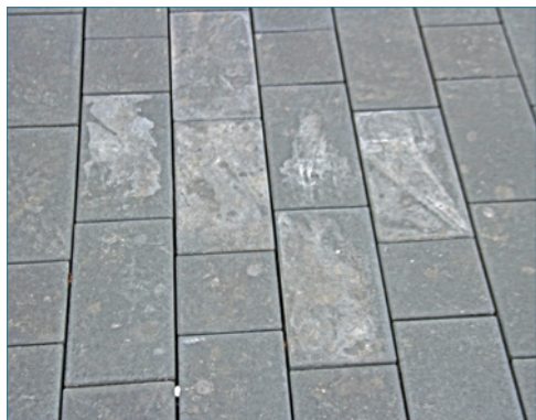
Bild 159: Bild 48: Verschmutzungen durch die Einwirkung von Schneidschlämmen
