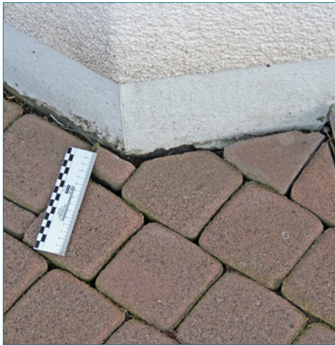
Bild 30: Materialabtrag an Betonpflastersteinen einer Pflasterdecke durch die Reinigung mit einem Hochdruckreiniger
