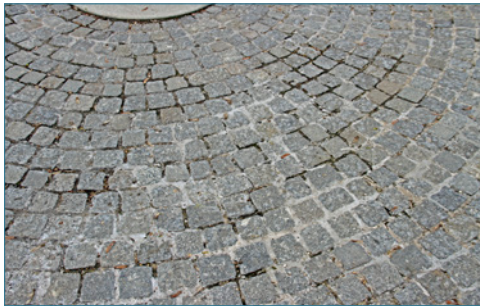
Bild 86: Verwitterung des Fugenmörtels
