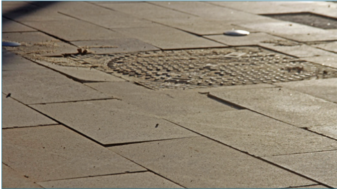
Bild 105: Horizontale und vertikale Verformungen von Pflasterdecken
