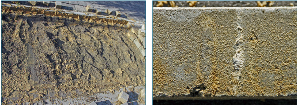
Bild 27: Langanhaltende Feuchteeinwirkung auf die Betonpflastersteine aufgrund der Verwendung eines feinstkörnigen Fugensandes
