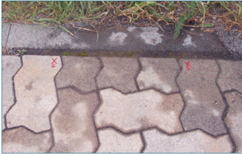
Bild 42: Unterschiedliches Abtrocknungsverhalten der Pflastersteine einer Pflasterdecke
