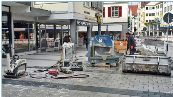
Bild 158: Schneidarbeiten auf Pflasterdecken
