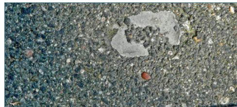
Bild 19: Zementsteinabwitterungen an Betonpflastersteinen aufgrund von Kerndurchschlägen
