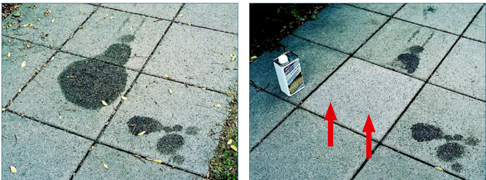
Bild 116: Reinigung von Ölflecken auf einer Pflasterdecke
