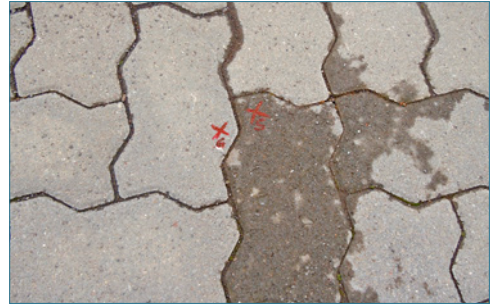
Bild 42: Unterschiedliches Abtrocknungsverhalten der Pflastersteine einer Pflasterdecke
