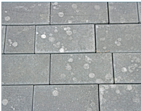
Bild 159: Bild 48: Verschmutzungen durch die Einwirkung von Schneidschlämmen
