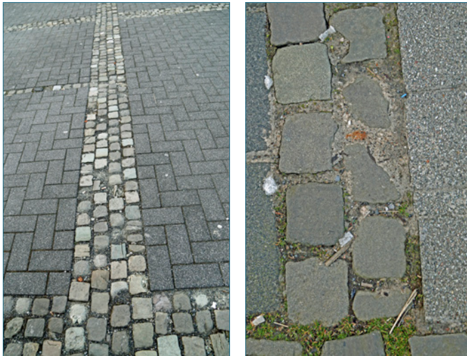
Bild 33: Verwitterungsschäden an Natursteinen
