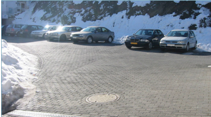
Bild 51: Frost-Tausalz-Schäden an einer Pflasterdecke, die unter Verwendung von WD-Steinen hergestellt wurde
