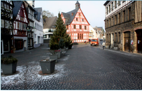
Bild 78: Pflasterdecke in gebundener Bauweise
