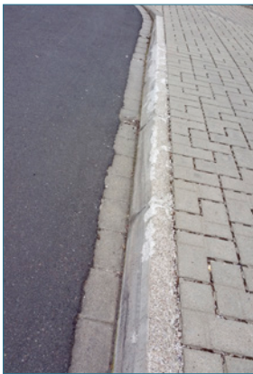
Bild 48: Flächige Zementsteinabwitterungen an Bordsteinen
