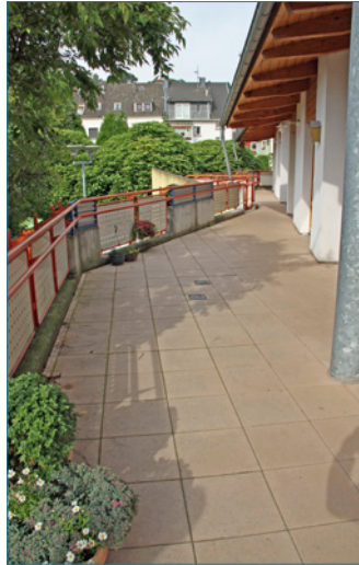
Bild 90: Gebundene Pflasterdecke ohne die erforderlichen Bewegungsfugen
