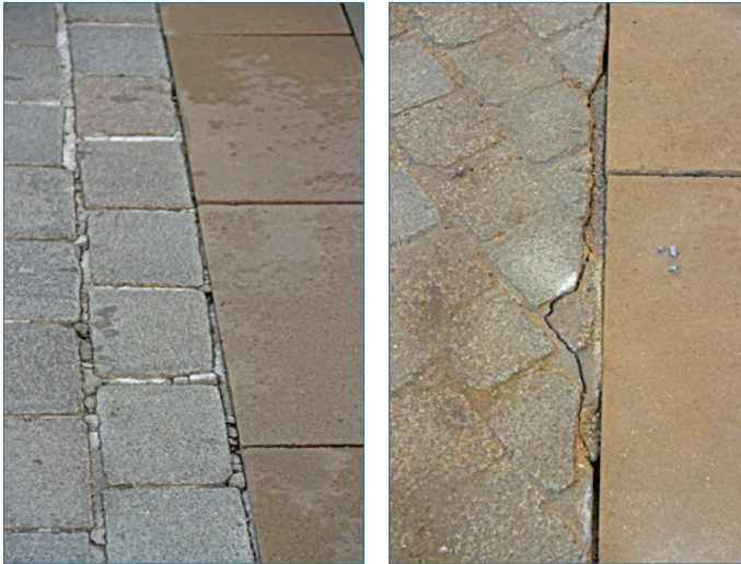
Bild 76: Ausbrüche an den Randsteinen der gebundenen Pflasterdecke
