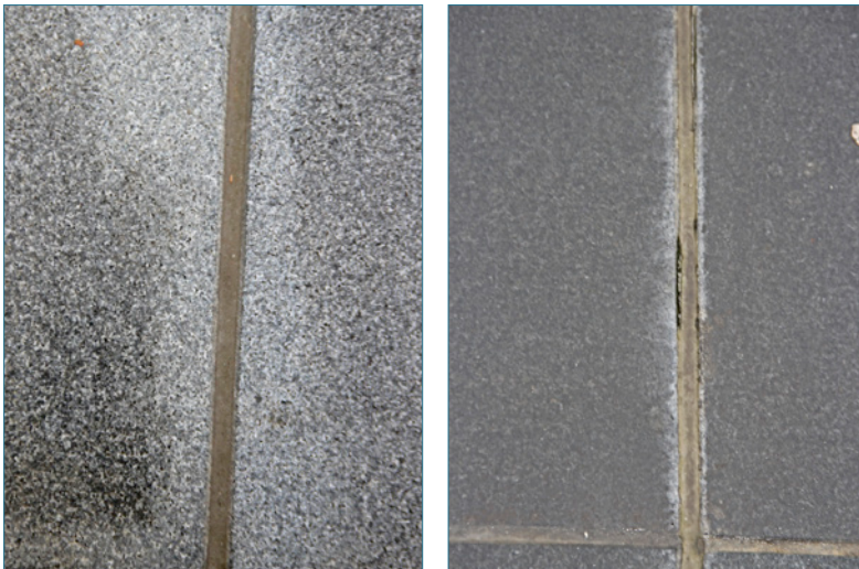
Bild 95: Pflasterdecke mit Verfärbungen der Natursteinplatten in der Nachbarschaft zu den Bewegungsfugen
