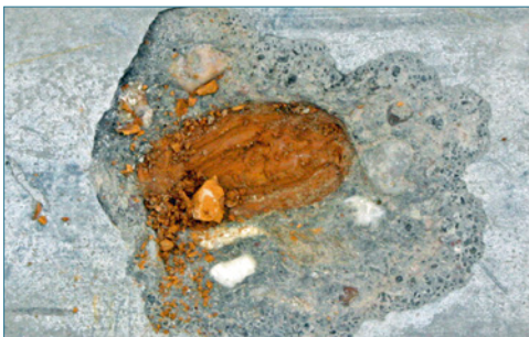
Bild 46: Zementsteinabwitterungen oberhalb witterungsunbeständiger Gesteinskörner
