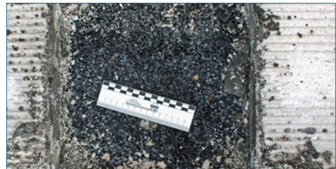
Bild 24: Witterungsbedingte Schäden am Kernbeton von Betonpflastersteinen
