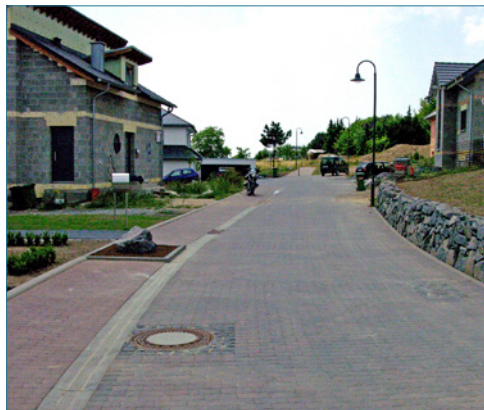
Bild 97: Rinnenanlage mit in regelmäßigen Abständen auftretenden Rissen
