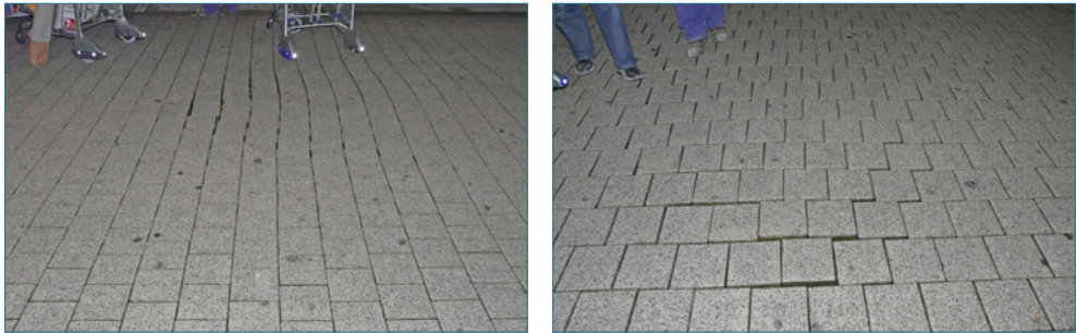
Bild 107: Horizontale Verformung einer Pflasterdecke
