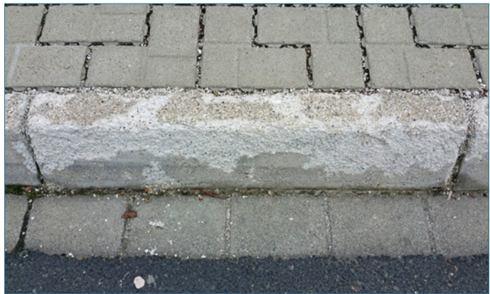
Bild 48: Flächige Zementsteinabwitterungen an Bordsteinen
