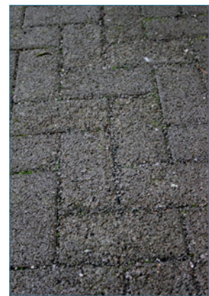
Bild 54: Frost-Tausalz-Schäden an einer nicht befahrenen Pflasterdecke, die unter Verwendung von WD-Steinen hergestellt wurde
