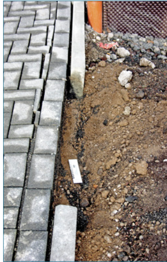
Bild 101: Verschiebungen aufgrund eines nicht lage-stabilen Rückenstützen-betons
