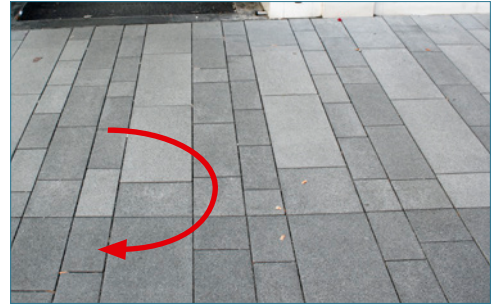
Bild 177: Durch Unterschiede im Strahlbild verursachte Farbunterschiede an Betonplatten
