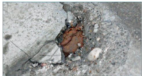
Bild 45: Zementsteinabwitterungen oberhalb witterungsunbeständiger Gesteinskörner
