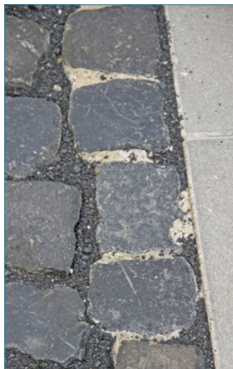
Bild 80: Pflasterdecke mit einer mittig ausgeführten gebundenen Entwässerungsrinne aus Betonplatten und einem Natursteinläufer
