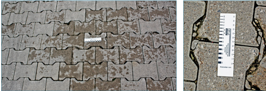
Bild 10: Frostschäden an »Wassersäufern«
