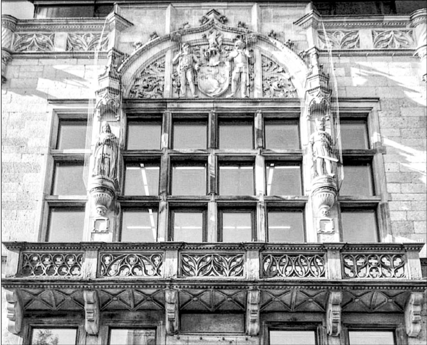
Abb. 7: Hauptfassade des Altbaus, bauplastischer Schmuck im Ersten OG, Widukind von Enger (links), Hermann der Cherusker. Foto: Gerd Dethlefs.
