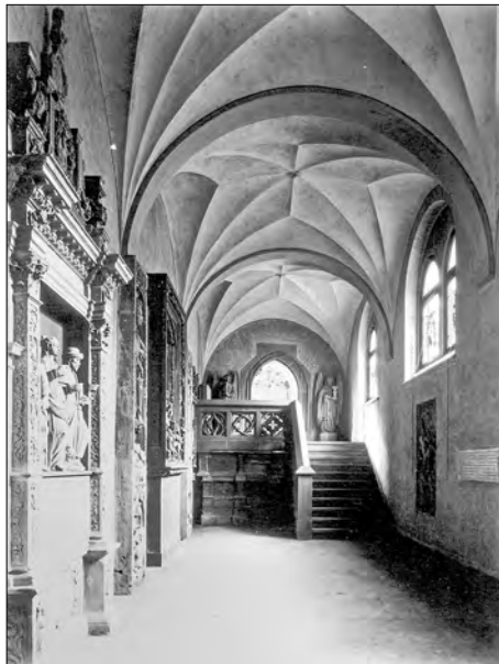
Abb. 18: Altbau des Landesmuseums, Raum VII, »Kreuzgang«, 1908. Foto: LWL-Denkmalpflege, Landschafts- und Baukultur in Westfalen.
