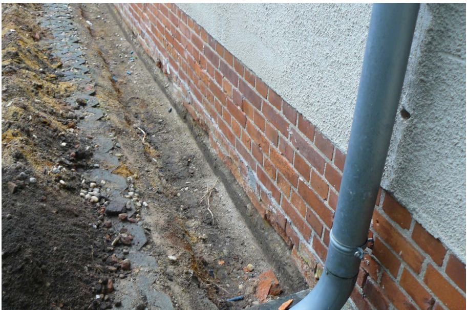
Bild 1: Sockelschaden an Ziegelmauerwerk
