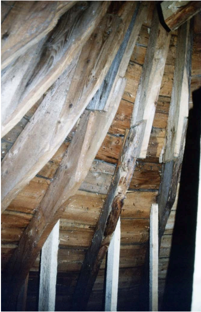
Bild 7 und Bild 8: Schadensuntersuchung in der obersten Zwiebelkuppel mit 6,50 m Durchmesser und provisorischen Reparaturmaßnahmen
