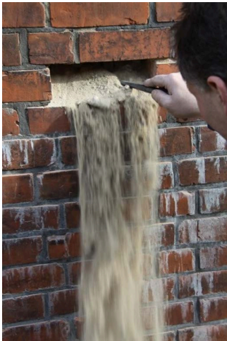
Bild 2: Probeöffnung: Kaskadenhaft abgängiger Mauermörtel der Verblendschale, Quelle: Giffey + Saxler Architekten
