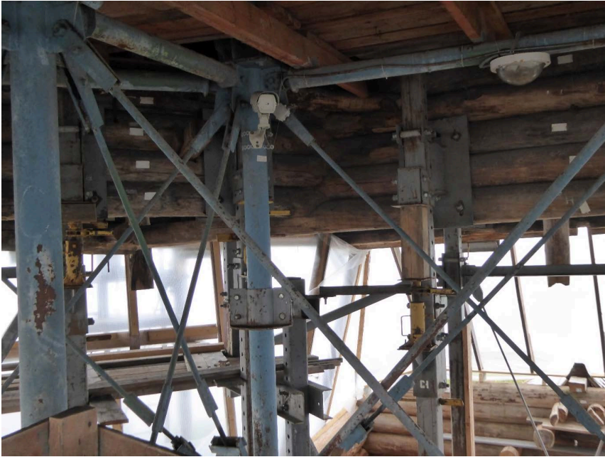
Bild 11: Blick in das Stahlgerüst, das die Kirche seit 1981 trägt.
