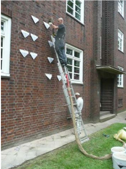
Bild 3: Einbringen des multifunktionalen Dämmstoff-Verbundsystems, Quelle: Giffey Saxler Architekten
