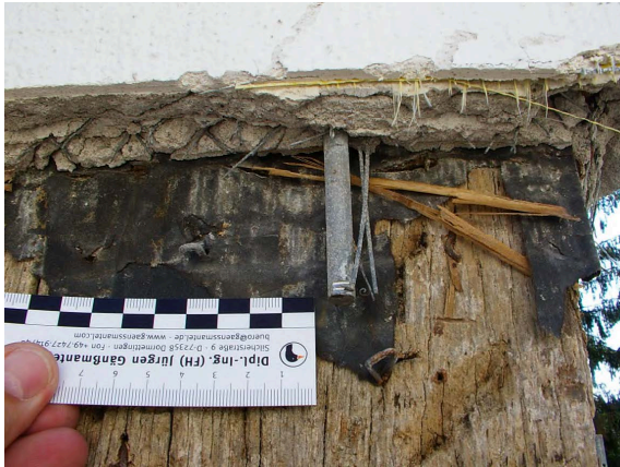
Bild 3: Bestands- und Schadensaufnahme bei einem verputzten Fachwerkgebäude: Ölpapier auf Holzfachwerk behindert Austrocknung von Feuchtigkeit, Putzdicke auf Putzträger ca. 30-35 mm bewirkt Flächenlast von rund 50 kg/m 2 .
