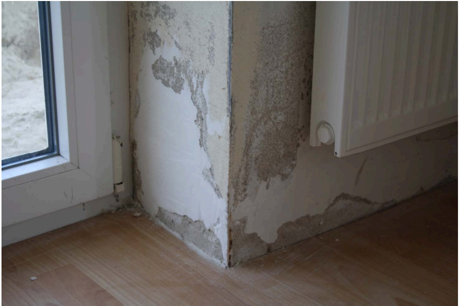
Bild 3: Putzschäden der Innenwand aufgrund einer fehlenden Sockelabdichtung
