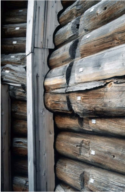
Bild 5 und Bild 6: Untersuchung der Ausbeulungen und provisorischen Sicherungen
