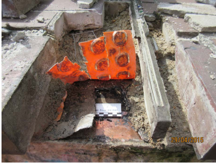
Abb. 3: Erneuerung Sockelabdichtung
