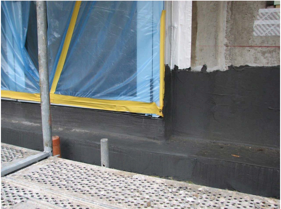
Bild 4: Sockelabdichtung mit Fensterdetailanschluss aus MDS
