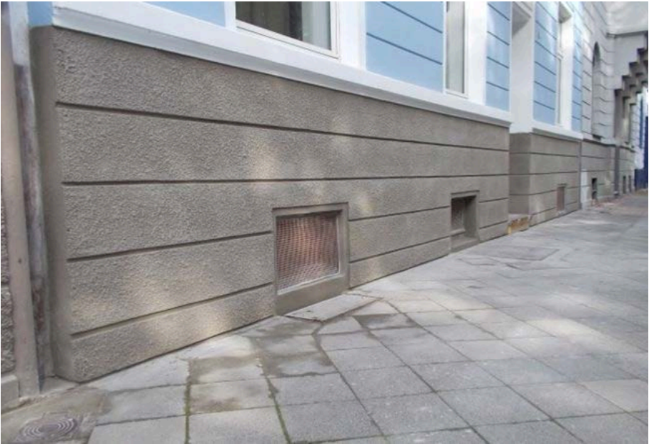
Bild 8: Sanierputzsockel mit Putzabdichtung
