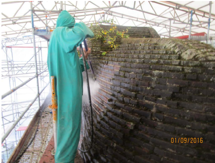
Abb. 8: Hochdruckreinigung
