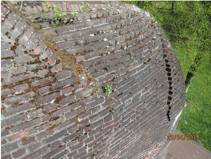
Abb. 2: „Abgetreppter“ Rücken des „Elefanten mit starkem Moosbewuchs auf den bauzeitlichen Fugen. Zustand 2015 (Foto: Deutschun)
