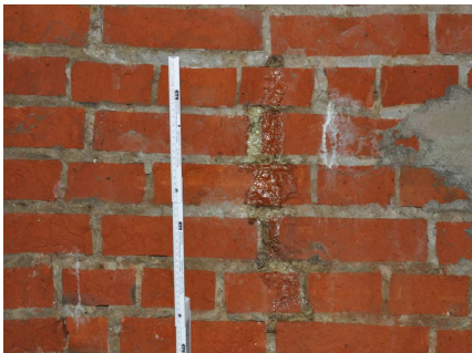
Abb. 10: Reste von Epoxi im Hohlkörper
