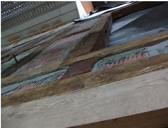
Bild 11: „Ewiges“ Praxisproblem bei Balkenköpfen und Fachwerk: Fehlender Schlagregenschutz
