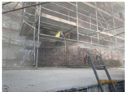
Abb. 13: Reinigung im Strahlverfahren mit Glas
