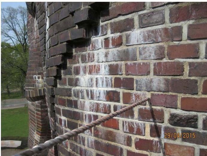
Abb. 3: Entnahmestelle einer Bohrmehlprobe zur Bestimmung des Feuchtegehaltes im Tiefenprofil. Kalksinterfahnen auf Bockhorner Klinker. Zustand 2015. (Foto: Deutschun)
