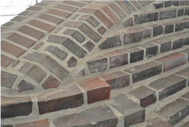
Abb. 9: Rücken des „Elefanten“ nach Abschluss der Mauerwerks- und Fugenkonsolidierung. Es sind grobkörnige alte (überschlammte) Fugen und neue Fugen erkennbar.
