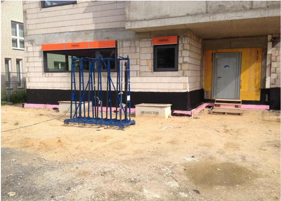
Bild 6: Sockelabdichtung mit PMBC hinter WDV S
