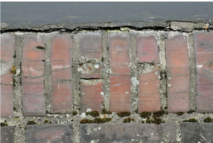
Abb. 5: Randlich abgelöste Abdichtungsbahn am Kopf des „Elefanten“. Frosts Schäden an den Formsteinen unterhalb der Abdichtung. (Foto: Deutschun)
