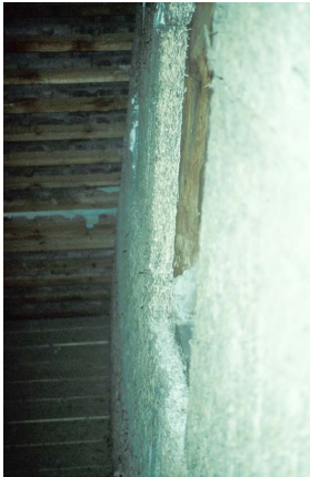
Bild 10: Praxisbeispiel Holzwolle-Bauplatte: Fachwerk als nicht planebener Untergründe erschwert die fachgerechte und hohlraumfreie Applikation der Platten.
