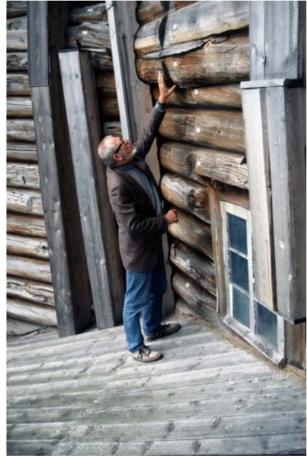
Bild 5 und Bild 6: Untersuchung der Ausbeulungen und provisorischen Sicherungen
