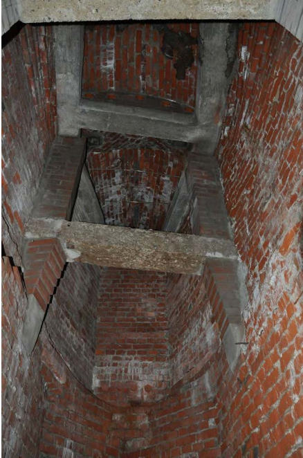
Abb. 4: Blick ins Innere des „Elefanten“. Betonskelett und Ziegelmauerwerk. Zahlreiche Kalksinterfahnen durch eingedrungene Feuchtigkeit. Zustand vor dem Auftrag des Opferputzes, 2015. (Foto: Deutschun)
