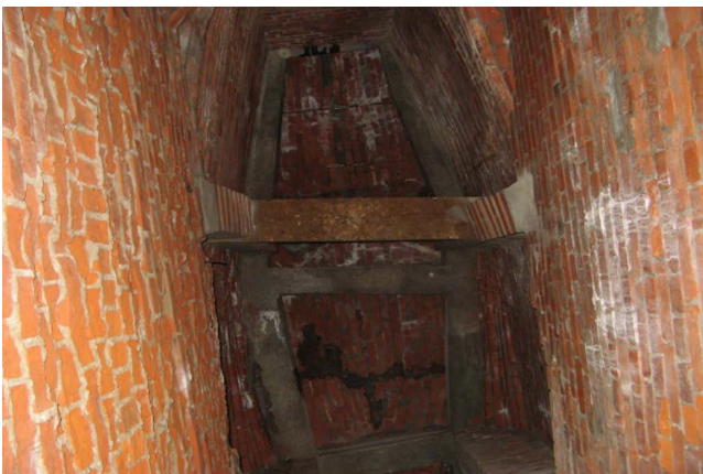
Abb. 5: Innenansicht des Elefanten 2016, vor der Instandsetzung mit Kompressenputz
