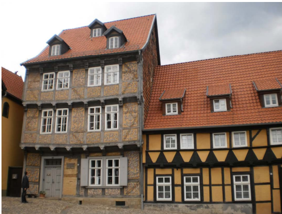
Bild 2: Sichtfassaden mit Fugen und Schlagregenbelastung stellen hohe Anforderungen an den kombinierten Wärme- und Feuchteschutz bei der Anwendung der EnEV, insbesondere bei Innendämmungen: Beispiel Quedlinburg.
