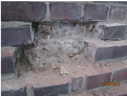
Abb. 12: Reste von Epoxi im Wandquerschnitt
