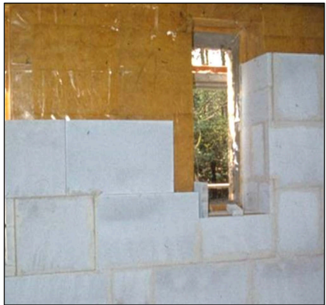
Bild 7: Anschluss des Innendämmsystems an die Fenster des Gutshofes
