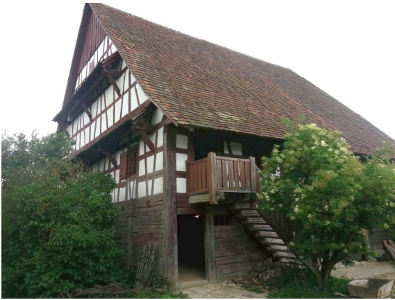
Bild 4: An diesem Fachwerkbauwerk sind alle Möglichkeiten des konstruktiven Schlagregenschutzes ausgenutzt: hoher Dachüberstand sowie Vordächer und Teilverschalung an der Wetterseite (Neuhausen ob Eck, Baden-Württemberg).
