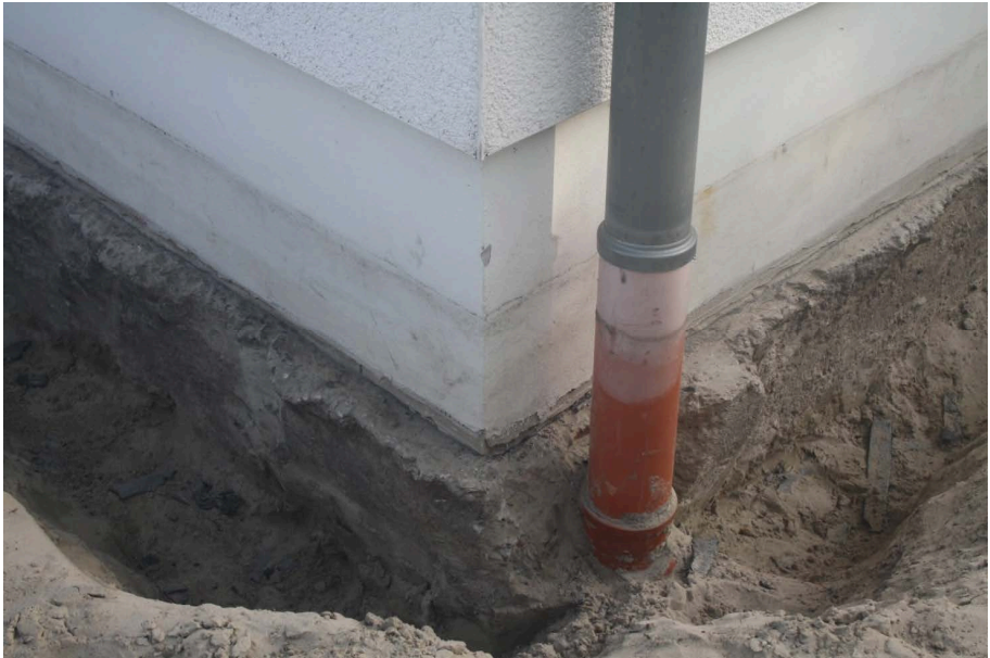
Bild 2: Fehlende Vertikalabdichtung am Gebäudesockel
