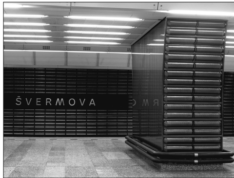
Abb. 6: Wandpaneele aus gepressten und mit ^{60}\text{CO} bestrahlten Simaxglasteilen nach einem Entwurf von František Vízner von 1981, Metrostation Jinonice (früher Švermova) Prag, 1988, © František Vízner Archiv
