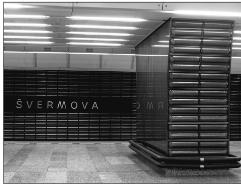
Abb. 6: Wandpaneele aus gepressten und mit ^{60}\text{CO} bestrahlten Simaxglaselementen nach einem Entwurf von František Vízner von 1981, Metrostation Jinonice (früher Švermova) Prag, 1988, © František Vízner Archiv
