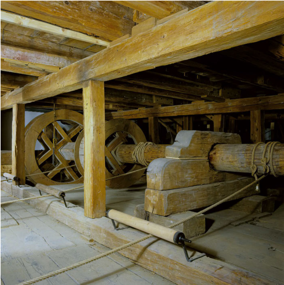
Abb. 2 Unterbühne, zentraler Wellbaum. Ludwigsburg, Schlosstheater.
