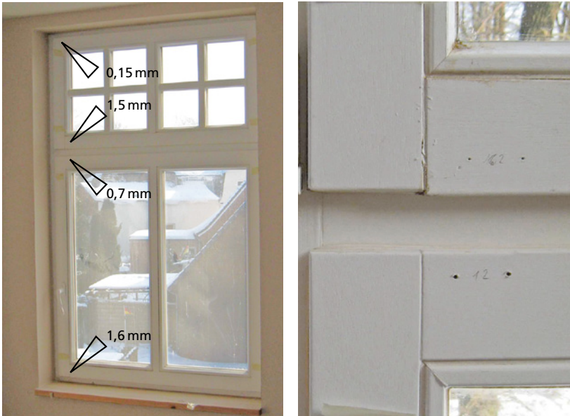
Bild 5.50 Die Eckverbindungen von Fensterflügeln wurden während der Winterbauphase durch von den Scheiben herablaufendem Wasser durchfeuchtet. Das Detailbild (rechts) zeigt die durch Quellung entstandenen Versätze an den Eckverbindungen und die Messpunkte der Holzfeuchtemessungen. In der Übersicht (links) sind die Mittelwerte der Versätze von zahlreichen Fenstern des Objekts dargestellt. Eine Auswertung der Einzelwerte zeigt Bild 5.51.
