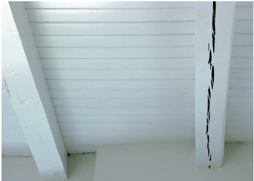
Bild 3.16 Risse in weiß lackierten Hölzern fallen besonders stark auf. Es handelt sich um ein rein optisches Problem. Die Tragfähigkeit ist nicht beeinträchtigt.
