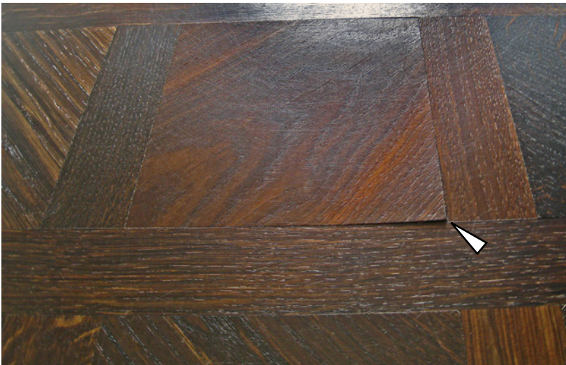
Bild 4.42 Dreischichtiges Parkett mit Deckschicht aus geräucherter Eiche auf Heizestrich; Oberflächen geölt. Der Faserverlauf ist diagonal. Die Richtung des stärksten Quellens und Schwindens endet daher genau in der Ecke des Elements.
