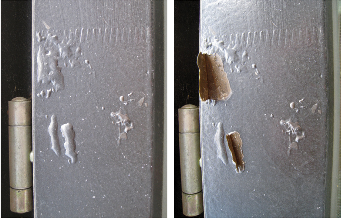
Bild 3.24 Größere Mengen an Baumharz haben die Haftung des Lacks lokal so weit verringert, dass Blasen entstanden sind. Auch ohne Öffnung der Blasen kann bereits ein lokaler Einfluss des Holzes angenommen werden, da das an die Keilzinkung angrenzende Holz schadensfrei ist.
