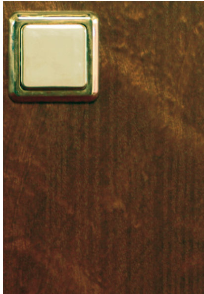
Bild 4.25 Helle senkrechte Linien, die besonders durch ihren unnatürlich geraden Verlauf auf einer Wandverkleidung störend auffallen. Die Linien wurden erst nach mehrjähriger Nutzung auffällig (was für derartige Befunde typisch ist). Sie sind durch Silberporen über durchgeschlagenem Klebstoff verursacht und spiegeln den Verlauf der Klebstoffraupen wieder.
