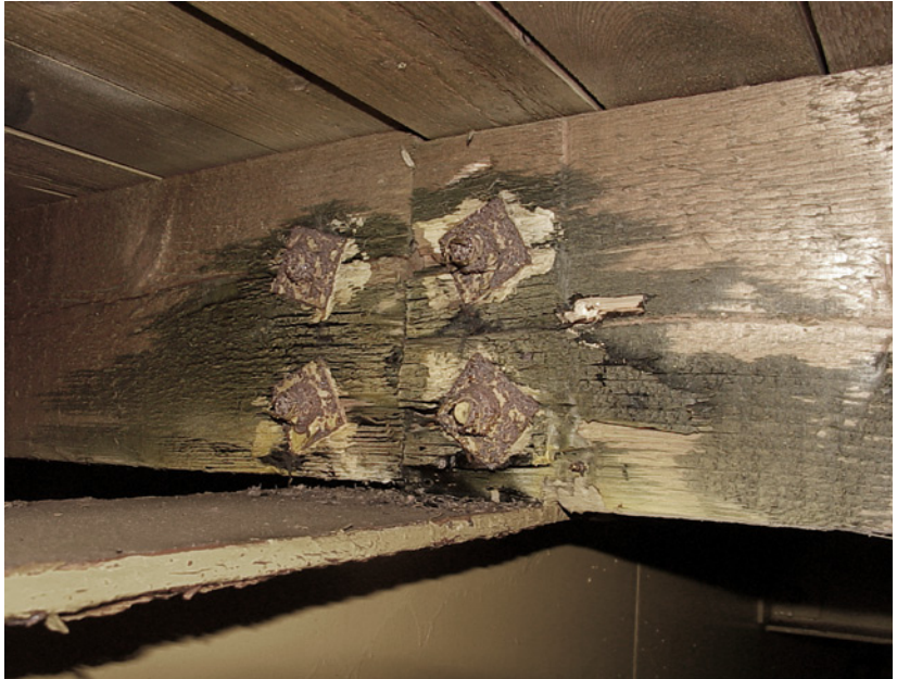
Bild 4.38 Eisenchloride, die sich in einer Feuerverzinkerei aufgrund von Salzsäuredämpfen gebildet haben, führen zu intensiven Zerstörungen des umgebenden Holzes. Im Endzustand ist das Holz von teerartiger Farbe und Konsistenz.
