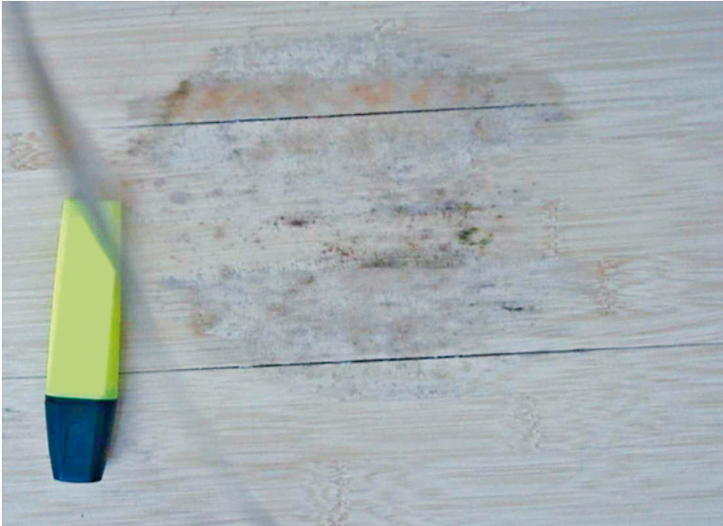
Bild 5.46 Dort, wo ein Blumenkübel das Bambusparkett über längere Zeit aufgefuechtet hatte, zeigen sich nach dem Abtrocknen deutliche Fugen. Beim Quellen wurde das Holz gequetscht. Nach dem Trocknen sind die Parkettstäbe daher schmaler.
