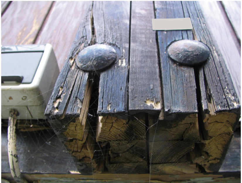
Bild 4.39 Die Volumenvergrößerung von rostenden Bolzen hat zur Aufspaltung an diesem Träger geführt.
