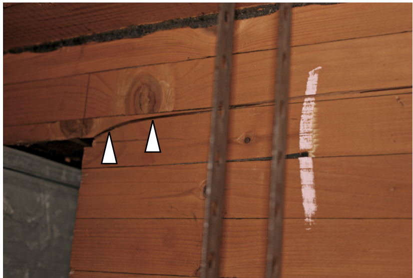
Bild 4.45 Der Ausschnitt für einen Lüftungskanal in einem Träger aus Brettschichtholz wurde an den Ecken nicht abgerundet. Genau von der Ecke ausgehend verläuft ein Riss. An einem benachbarten Balken führte die fehlende Abrundung der Ecke des Ausschnitts zum Bruch eines Trägers.
