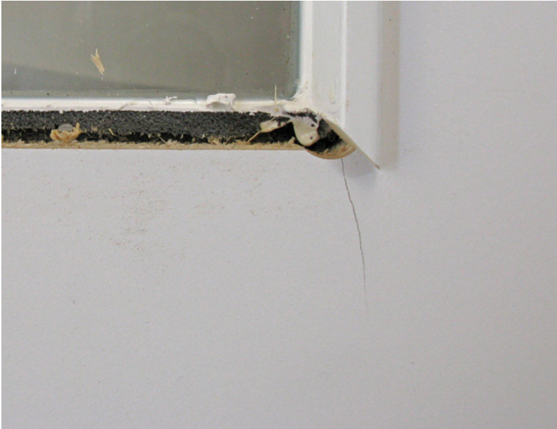
Bild 5.42 Riss in einem mit CPL beschichteten Türblatt, der von der abgerundeten Ecke des Glasausschnitts ausgeht.
