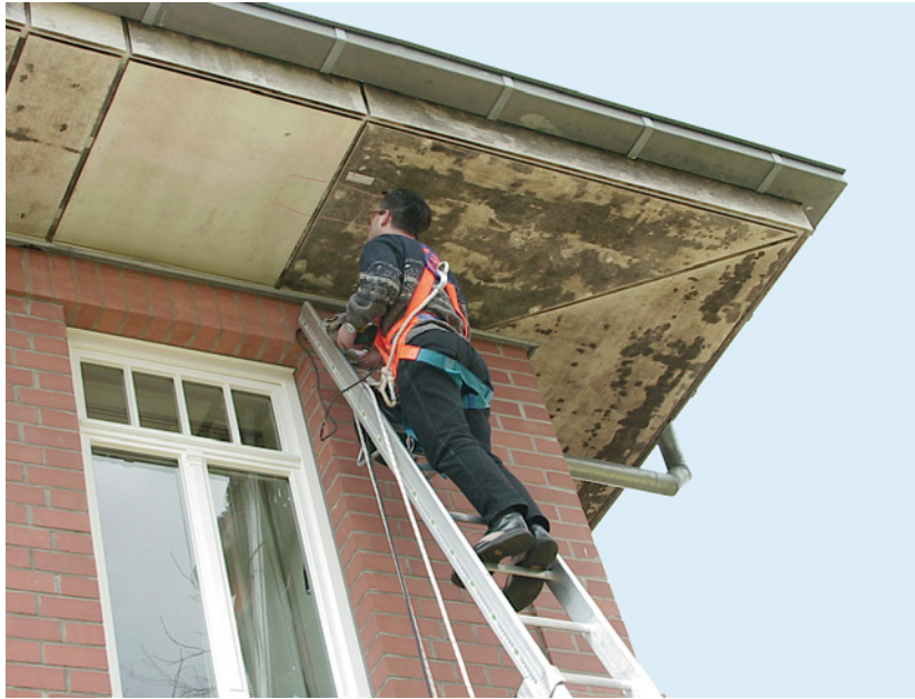
Bild 4.10 Die Intensität des Befalls durch Schimmelpilze an Dachuntersichten aus Sperrholz ist häufig sehr unregelmäßig (hier Birkensperrholz). Dies ist wahrscheinlich auf unterschiedlichen Nährstoffgehalt einzelner Furniere und Dickenunterschiede der Beschichtung zurückzuführen.
