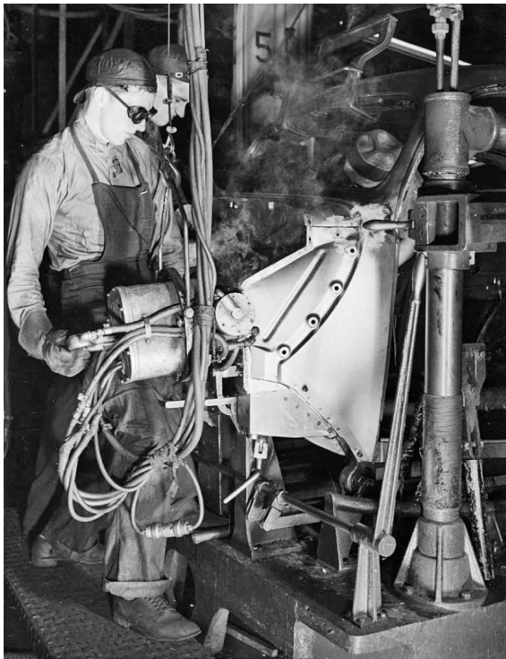
Abbildung 30: Nahtschweißer im Karosseriebau des Werks River Rouge (1936)
