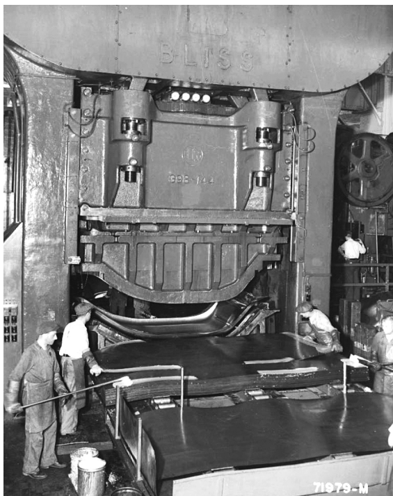
Abbildung 27: Pressen des Dachteils (1939)
