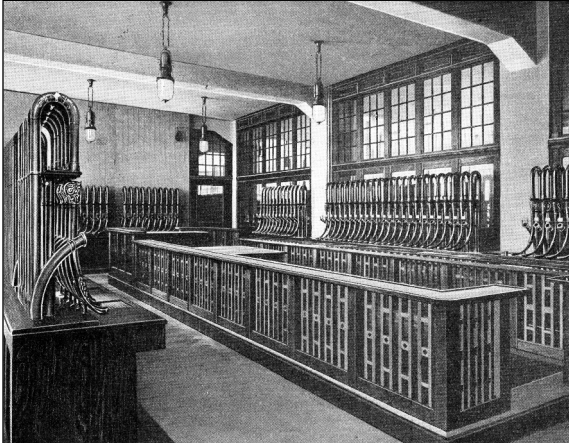
Abb. 8: Hausrohrpostzentrale des Kaufhauses des Westens, Berlin
