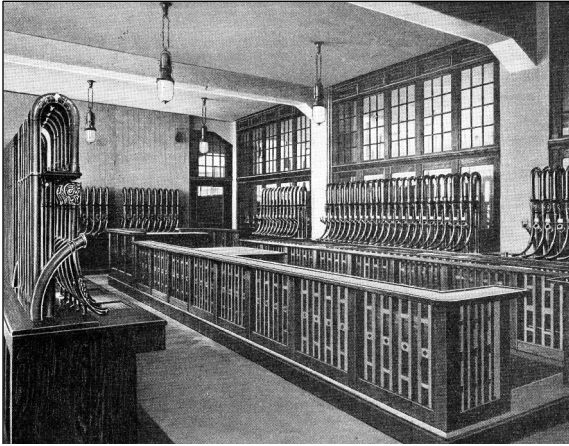
Abb. 8: Hausrohrpostzentrale des Kaufhauses des Westens, Berlin
