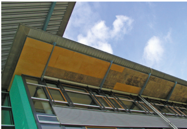
Bild 179 ■ Abwechselnd dunkel und hell verfärbte Plattenoberfläche
