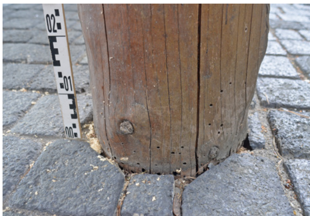
Bild 109 ■ Stützenfuß mit runden Ausflugh- löchern von Holzinsekten
