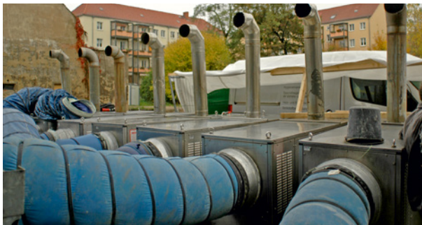
Bild 153 ■ Mehrere Heizgeräte mit angeschlossenen Schläuchen zur großflächigen Heißluftbehandlung eines gesamten Gebäudes
