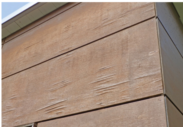
Bild 99 ■ Ablösung des Deckfurniers an Sperrholzplatten infolge von unzureichendem Feuchteschutz
