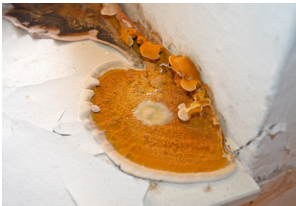
Bild 32 ■ Fruchtkörper des Echten Hausschwamms mit der braunen Fruchtschicht und dem weißen Zuwachsrand. Innerhalb der Fruchtschicht entwickeln sich die Sporen.
