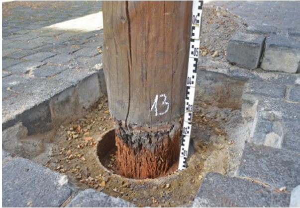
Bild 110 ■ Sichtbar gewordene Zerstörung der Holzsubstanz durch Braunfäule im erdbe-rührten Bereich nach Freilegung/Aufnehmen des Pflasters
