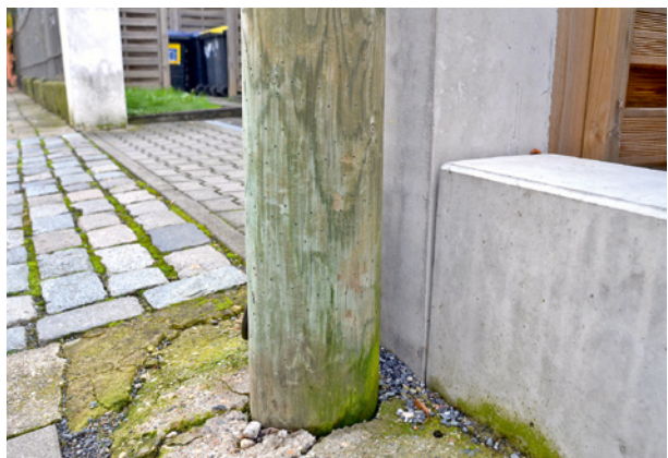
Bild 114 ■ Sichtbare Perforierung in der Erd-Luft-Zone eines chemisch geschützten Strommastes
