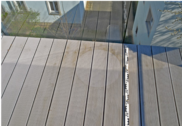
Bild 121 ■ WPC-Dielen im bewitterten Bereich der Terrasse mit grüner Verfärbung um einen Pflanztopfstandort
