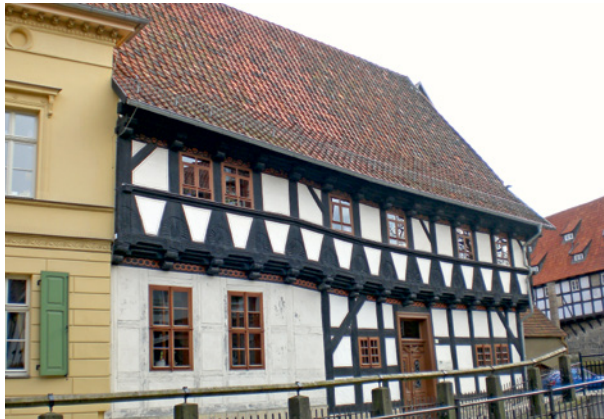
Bild 155 ■ Beachtens- werte Verformungen langzeitbelasteter Fach- werkhölzer, ohne dass Bruch auftritt
