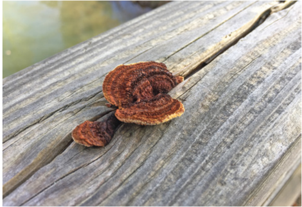
Bild 52 ■ Fruchtkörper des Tannenblättlings, der aus einem Holzriss an einem Handlauf herauswächst
