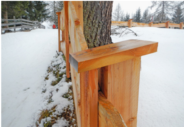
Bild 94 ■ Abdeckung einer Hirnholzfläche durch ein Opferbrett
