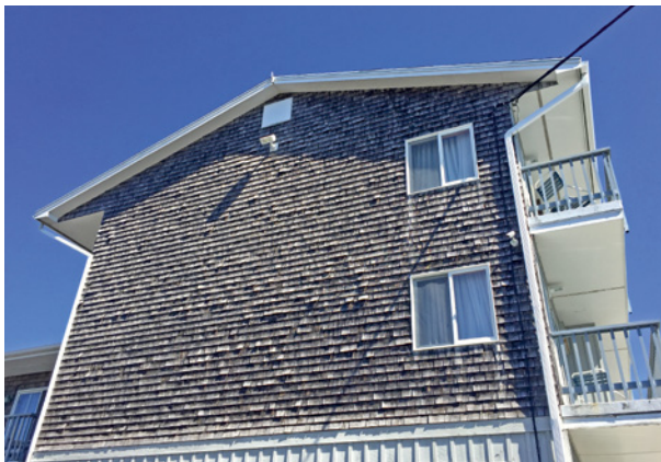
Bild 174 ■ Einheitliche Vergrauung an einer besonnten Fassade aus Holzschindeln
