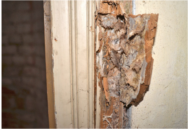
Bild 28 ■ Türbekleidung: Der Echte Hausschwamm ist versteckt hinter der Zarge gewachsen, die »rundrückige« Ver- formung des Holzes gibt einen Hinweis auf den Befall.
