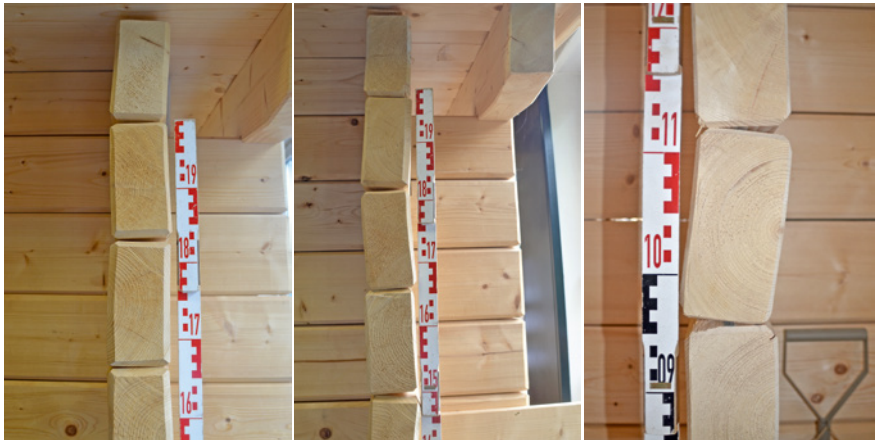
Bild 202 ■ Verformte Blockbohlen im Bereich des Eckverbandes und Fugenbildung
