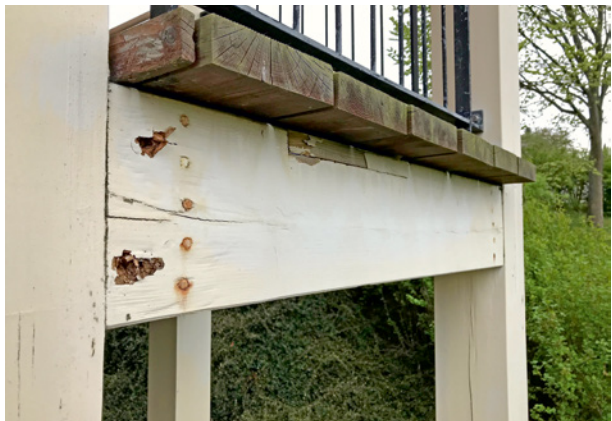
Bild 144 ■ Fehlende Abdeckung am Träger mit Braunfäule im Anschluss an die Stütze
