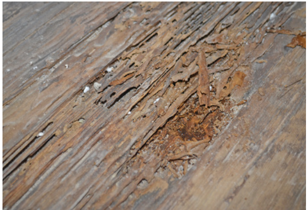
Bild 89 ■ Pilzgeschädigtes Holz in einem Fertigteilhaus. Wegen des Auftretens von Ameisen im Gebäude wurde nach einem verdeckten Feuchteschaden in der Konstruktion gesucht.
