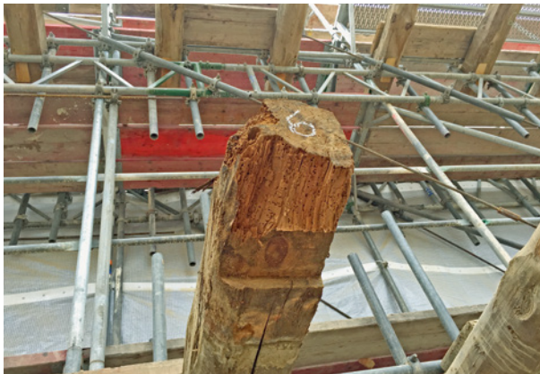
Bild 148 ■ Pilz- und Insekten­schäden am freigelegten Balkenkopf
