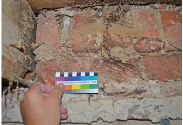
Bild 38 ■ Dunkles Oberflächenmyzel des Braunen Kellerschwamms
