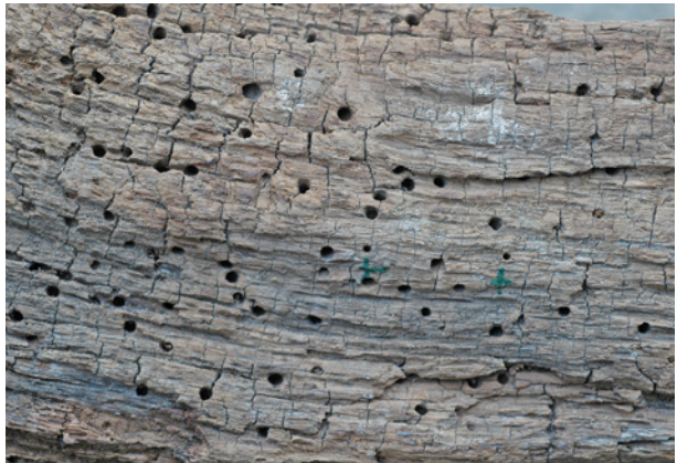
Bild 80 ■ Runde Ausflugslöcher des Gescheckten Nagekäfers an der Holzoberfläche mit einem Durchmesser von 3 bis 4 mm
