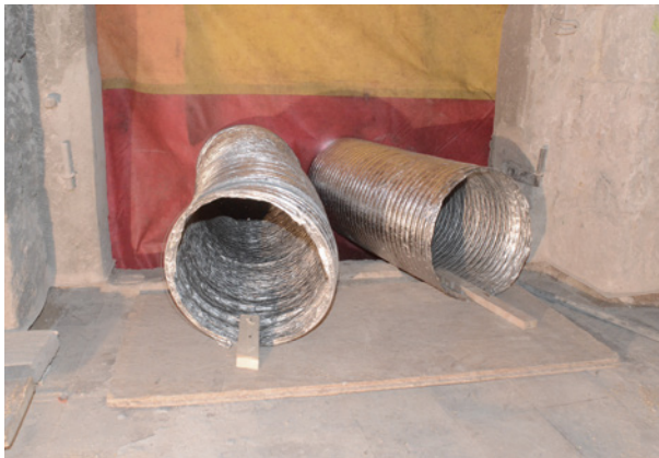
Bild 196 ■ Einhausung mit Einblasrohren für die Heißluftbehandlung
