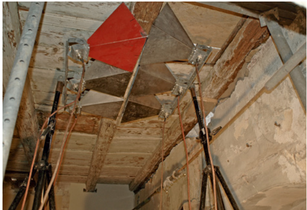
Bild 198 ■ Mikro- welle zur thermischen Behandlung, hier an Deckenbalken aus der Renaissance
