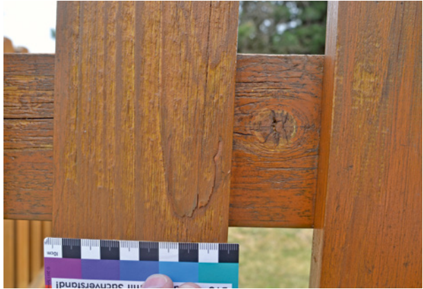
Bild 171 ■ Ablösung vom Jahrring (Abschilferung)
