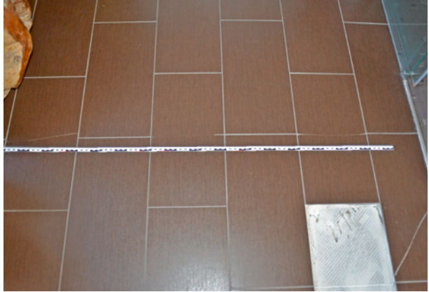
Bild 209 ■ Rissbildung im verlegten Fliesenbelag auf der Holzbalkendecke
