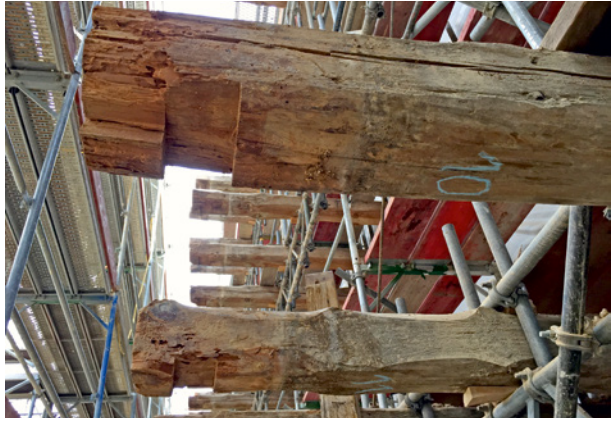
Bild 149 ■ Schädigung vom Hirnholz ausgehend bis ungefähr zur Aussparung für die Balkenschwelle
