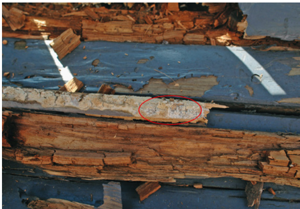
Bild 129 ■ Braunfäule mit Würfelbruch und Pilzfruchtkörper von einer Porenschwammart
