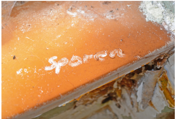
Bild 34 ■ Aus dem Fruchtkörper ausgefallene braune Sporen des Echten Hausschwamms. Sie werden durch Windzug, durch die Raumnutzer an den Schuhen etc. verbreitet.
