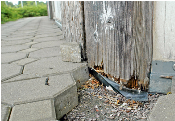
Bild 103 ■ Zustand des Stützenfußes nach Aufnehmen des Betonpflasters im Arkadenbereich
