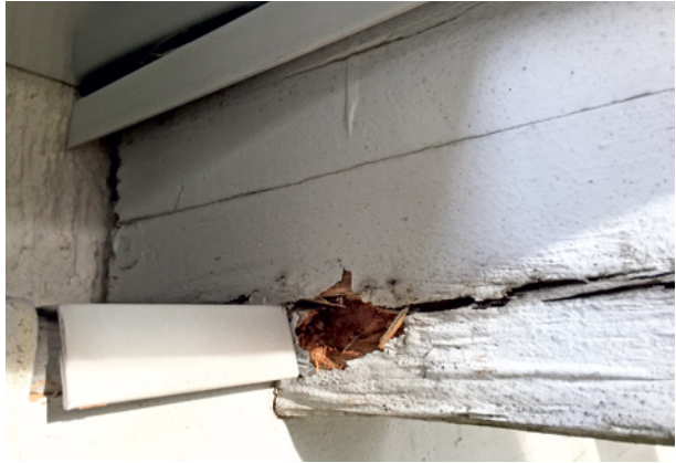
Bild 136 ■ Braunfäuleschaden am Holz vom Blechanschluss ausgehend
