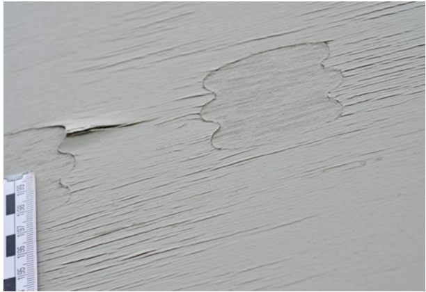
Bild 161 ■ Beginnende Ablösung des Deckfurniers vom Einlegestück ausgehend
