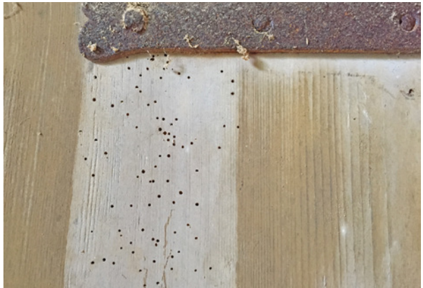
Bild 73 ■ Runde Ausflugs- löcher des Gewöhnlichen Nagekäfers an einem historischen Türblatt. Zusätzlich ist feines Bohrmehl am Türband erkennbar.
