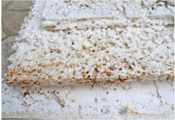
Bild 88 ■ Dämmstoff wird von der Ameise als Wohnraum und zum Anlegen von Nestern im Gebäude genutzt.
