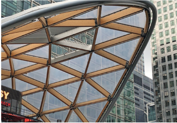
Bild 1 ■ Tonnendach aus Holz in Gitterstruktur der Londoner U-Bahn-Station Canary Wharf
