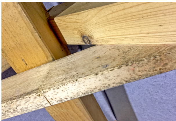
Bild 191 ■ Fehlende Lüftungsöffnung im First
