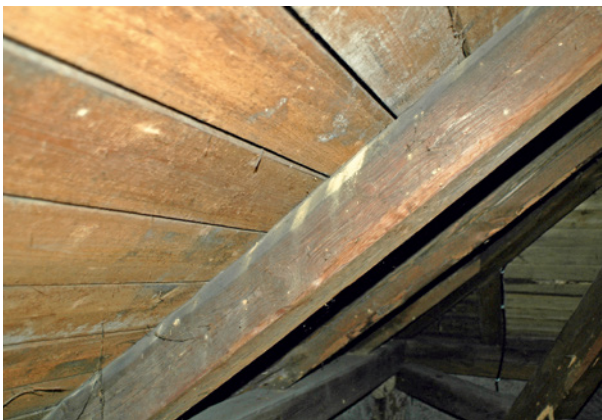
Bild 201 ■ Riesel- spuren als Indiz für einen Lebendbefall, sofern diese nicht auf Erschütterungen zurückzuführen sind
