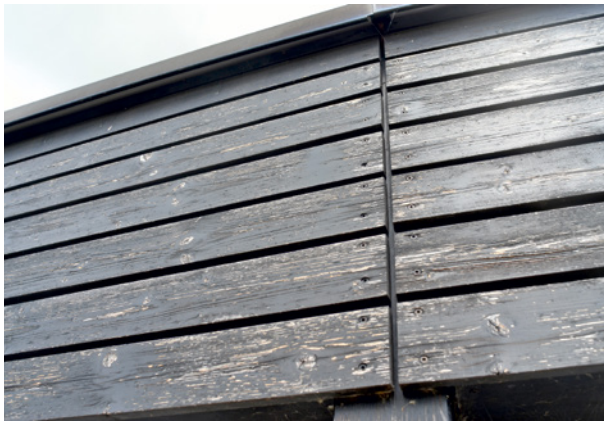
Bild 166 ■ Beschichtungsschäden an der Schalung aus Fichtenholz
