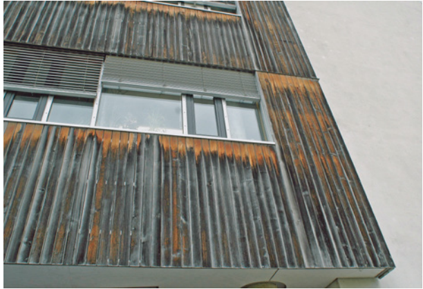
Bild 176 ■ Unterschiedliche Vergrauung an einer Lärchenfassade: Die hellen Partien verbleiben lange Zeit an den witterungsgeschützten Stellen.
