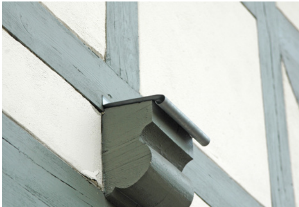
Bild 95 ■ Verblechter Balkenkopf an einer Fachwerkfassade
