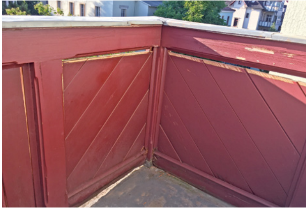
Bild 146 ■ Balkonbrüstung mit gelockelter und nach unten abgerutschter Füllung
