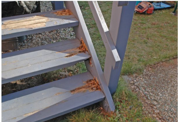
Bild 131 ■ Marode Holztreppe: Über die Haarfuge zwischen Wange und Stufe ist unzuträglich Wasser eingedrungen.
