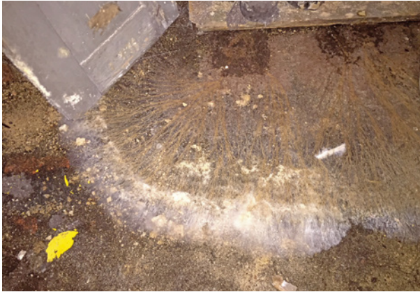
Bild 41 ■ Junges Myzel des Marmorierten Kellerschwamms am Kellerfußboden
