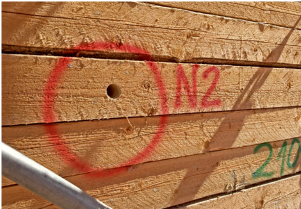
Bild 118 ■ Probenentnahmestelle am Kantholz der Ausfachung
