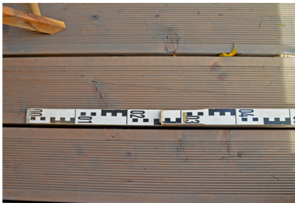
Bild 127 ■ Äste im Holz und Risse um den Ast, die dem Faserverlauf folgen
