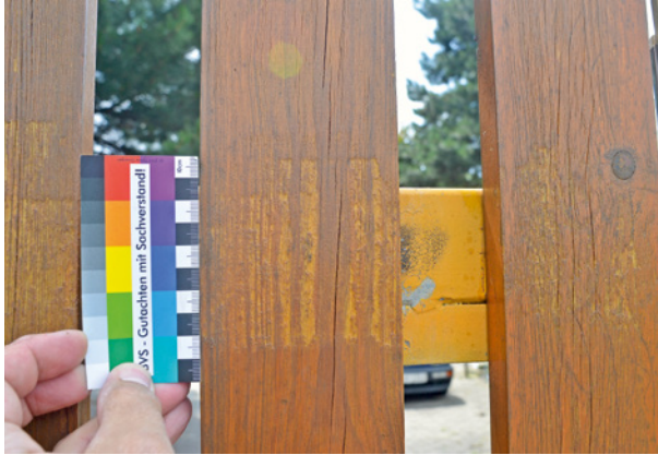
Bild 169 ■ Durch Heißwasserstrahlen beschädigte Holzoberfläche
