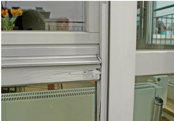
Bild 157 ■ Zerstörte Holzsubstanz unterhalb der Endkappe der Wetterschutzschiene
