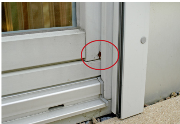
Bild 158 ■ Von der V-Fuge ausgehende Holzerstörung
