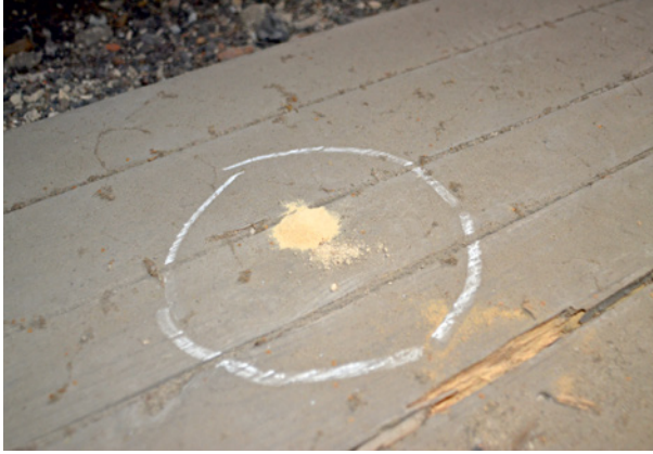
Bild 199 ■ Ausgeworfenes Bohrmehl auf der Dielung infolge von Larvenaktivität
