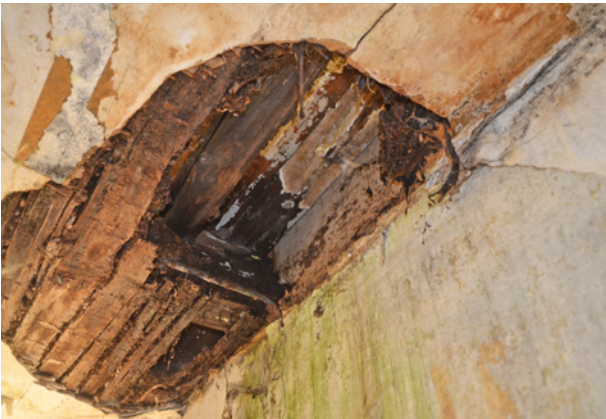
Bild 36 ■ Befall durch den Braunen Kellerschwamm an einer stark durchfeuchteten Holzbalkendecke mit Fruchtkörperbildung
