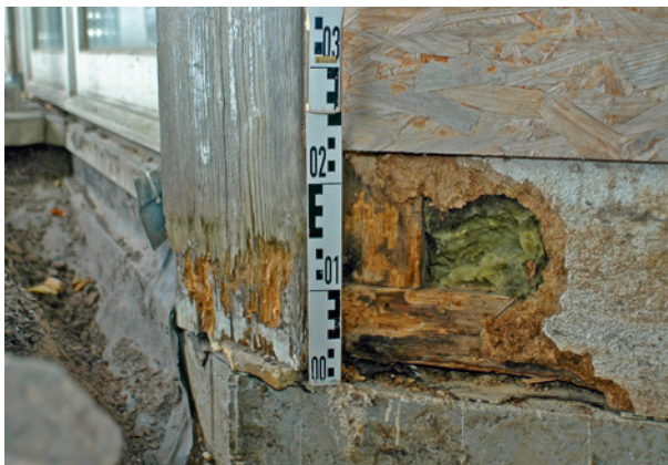
Bild 104 ■ Nach Freilegung sichtbar gewordener Pilzschaden am Holz
