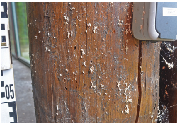
Bild 150 ■ Ausgeworfenes helles Bohrmehl an der Holzoberfläche einer Säule
