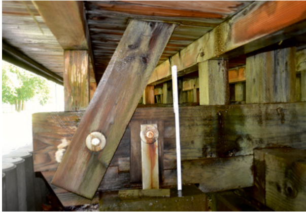
Bild 140 ■ Sole tropft an den Durchdringungsstellen im Ablaufboden ab.
