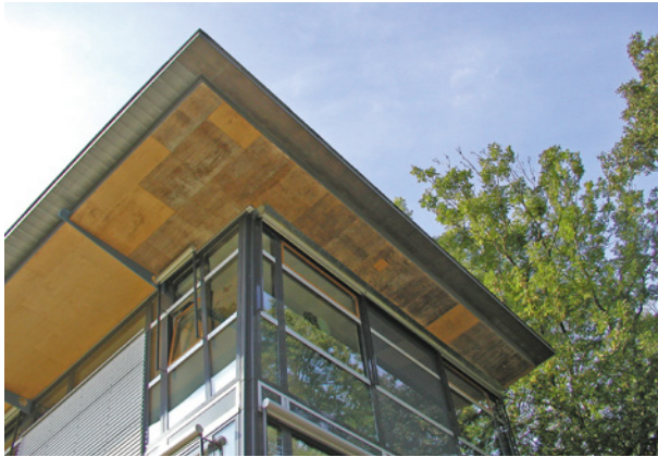
Bild 178 ■ Dachuntersicht mit hellen und dunkel verfärbten Holzwerkstoffplatten
