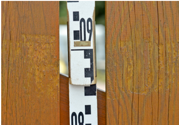
Bild 170 ■ Sichtbar abgetragene Holzsubstanz
