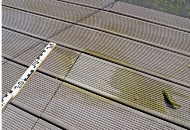
Bild 123 ■ Grauer Farbton der Dielen nach Entfernung der grünen Verfleckung aufgrund von Biomasse
