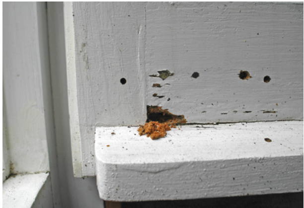
Bild 86 ■ Das kreisrunde Ausflugloch des Rothalsbocks zeigt den Befall im feuchten und pilzvorgeschädigten Holz an.
