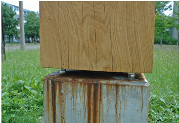
Bild 12 ■ Ausgewaschene Eichenlohe hat den Beton verfärbt.
