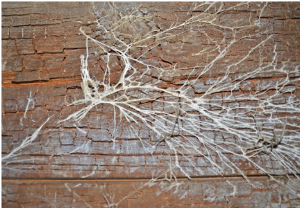
Bild 44 ■ Bindfadendicke Myzelstränge des Weißen Porenschwamms: Die Stränge bleiben auch im trockenen Zustand biegsam und weiß.
