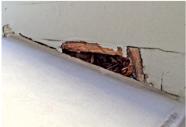
Bild 137 ■ Holzerstörung am Anschluss der Blechabdeckung
