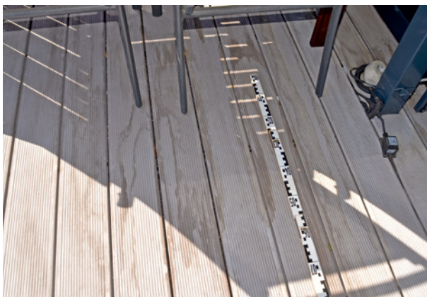
Bild 122 ■ WPC-Dielen im witterungsgeschützten Bereich der Terrasse mit braungelber Verfärbung
