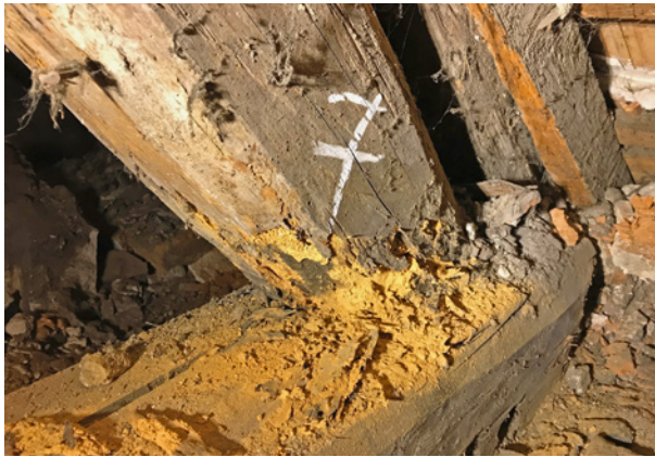
Bild 65 ■ Durch den Gewöhnlichen Nagekäfer zerstörte Holzsubstanz an Sparrenfuß und Deckenbalkenkopf
