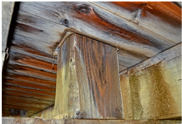
Bild 139 ■ Ablaufboden von der Unterseite mit Durchdringung einer Stütze. Die Dichtmasse in der Fuge zwischen Ablaufboden und Stütze ist sichtbar.
