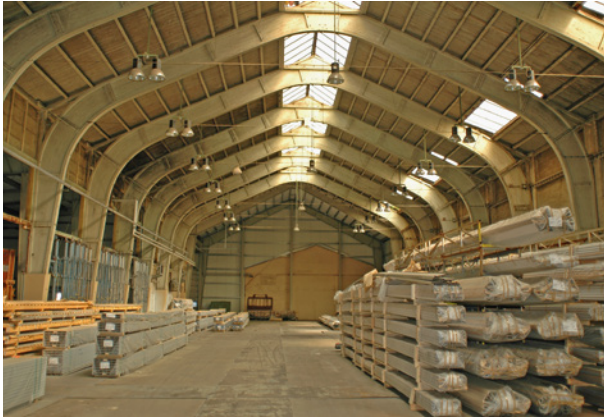
Bild 98 ■ Historische Brettschichtholzkonstruktion in einer Industriehalle von 1914. Schäden durch holzerstörende Insekten sind nicht vorhanden.
