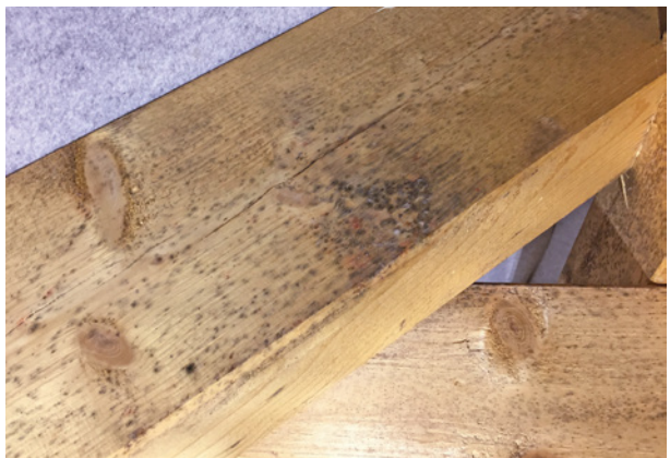
Bild 64 ■ Schimmelpilz der Gattung Cladosporium spp. am Dachstuhl aus Konstruktionsvollholz
