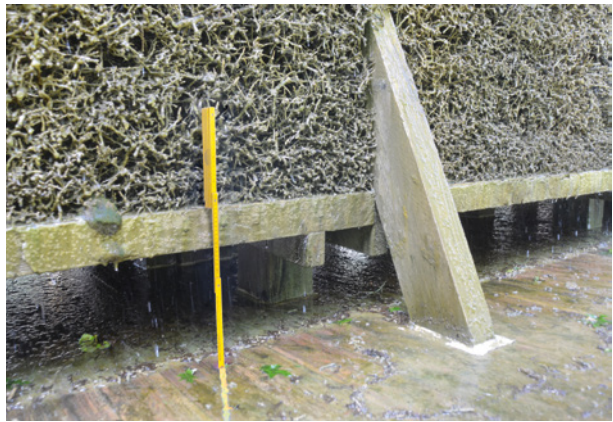
Bild 138 ■ Stützen und Streben der Tragkonstruktion für die Bedornung durchdringen den Ablaufboden.
