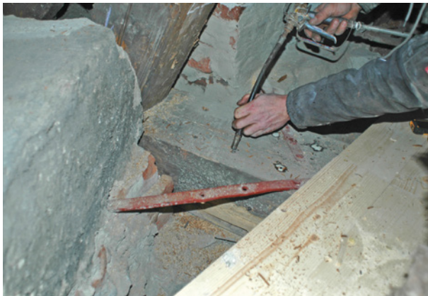
Bild 102 ■ Bohrlochdrucktränkung an einem Deckenbalkenkopf im Rahmen einer Bekämpfungsmaßnahme
