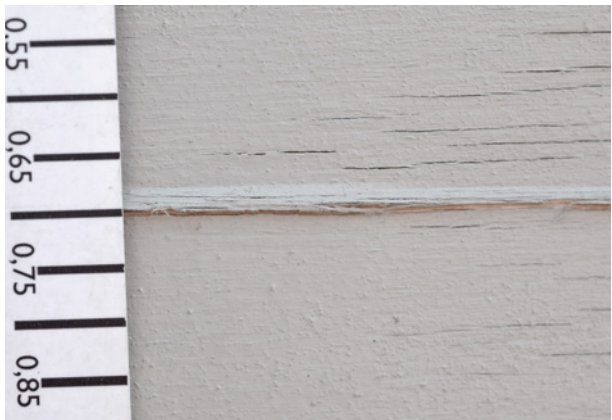
Bild 162 ■ Furnieraufwölbung im Rissbereich
