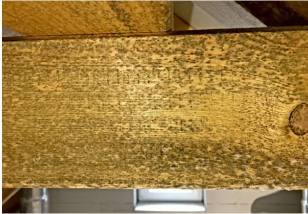
Bild 190 ■ Es ist ein dicker Myzelrasen auf der Holzoberfläche entstanden.
