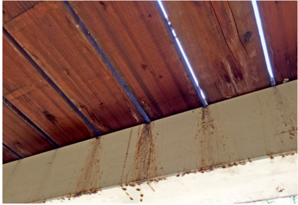
Bild 142 ■ Ablaufspuren am Träger zwischen den Belagsfugen
