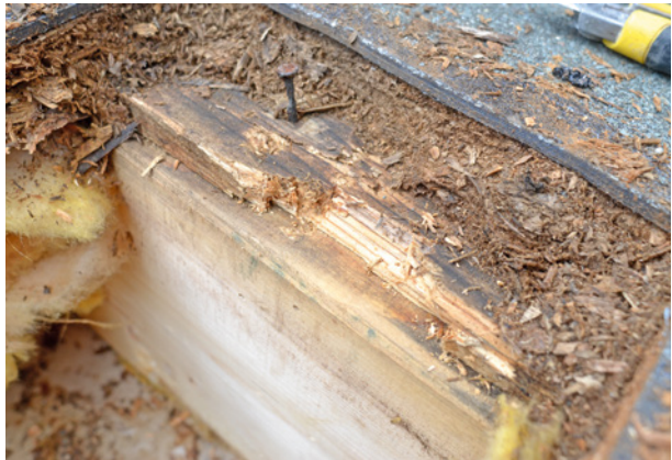
Bild 184 ■ Braunfäuleschädigung am Gefällekeil und an der Sparrenoberseite
