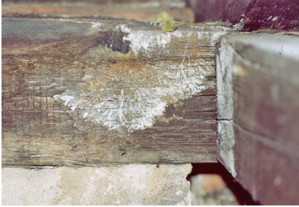
Bild 43 ■ Eisblumenartiges, schneeweißes Oberflächenmyzel des Weißen Porenschwamms
