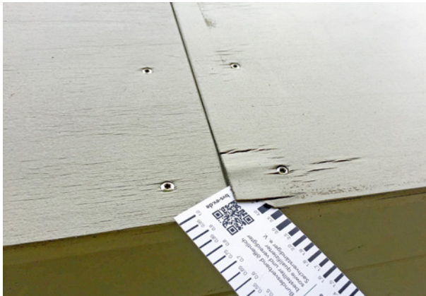
Bild 164 ■ Ablösung des Deckfurniers von der Plattenkante ausgehend
