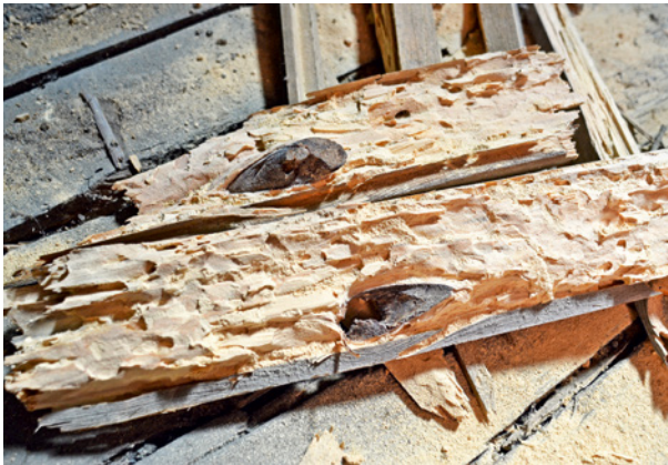
Bild 200 ■ Vollständig zerfressene Holzsubstanz unterhalb der visuell intakt erscheinenden Holzoberfläche
