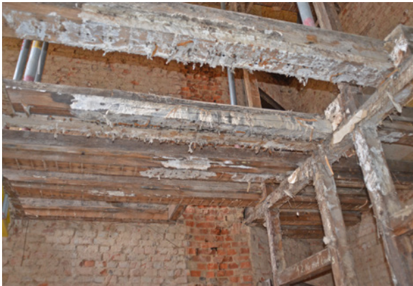
Bild 22 ■ Vom Weißen Porenschwamm als Holzerstörer überwachsene Holzkonstruktion im Altbau
