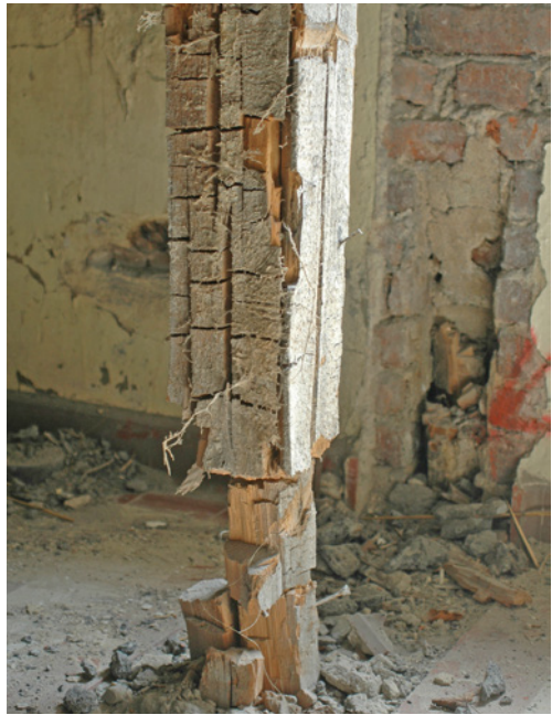
Bild 29 ■ Großer Würfelbruch als typisches Merkmal für den Echten Hausschwamm
