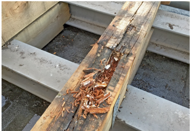
Bild 186 ■ Vollständig an der Oberseite zerstörte Holzsubstanz durch Pilzbefall
