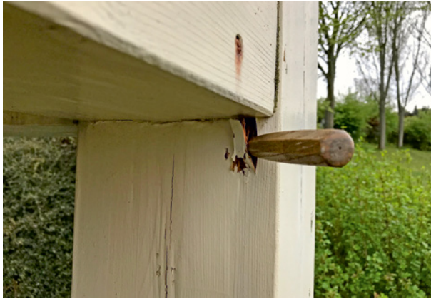
Bild 145 ■ Braunfäule Holzsubstanz an der Stütze unterhalb der Anschlussfuge
