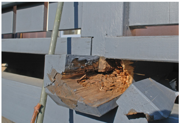
Bild 132 ■ Im Holzinneren zerstörter Balkenkopf. Über den Riss an der Balkenoberseite ist Feuchtigkeit eingedrungen und hat Pilzwachstum hervorgerufen.
