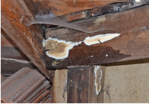
Bild 40 ■ Brauner Fruchtkörper mit weißem Rand des Braunen Kellerschwamms im Bereich einer Einregestelle am Dach
