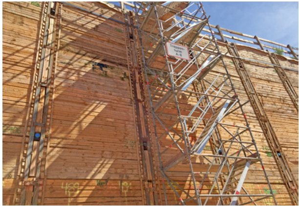
Bild 117 ■ Rückverankerte Trägerbohlwand mit Holzausfachung
