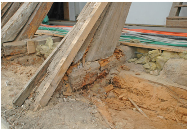
Bild 194 ■ Durch den Pilz zerstörte Holzbauteile des Dachstuhls
