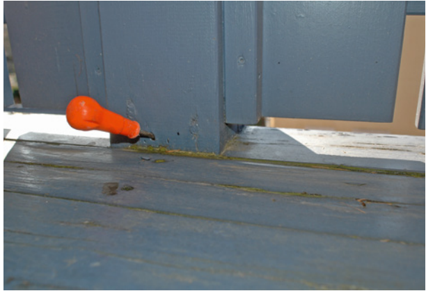
Bild 130 ■ Zerstörte Holzsubstanz unter der Beschichtung
