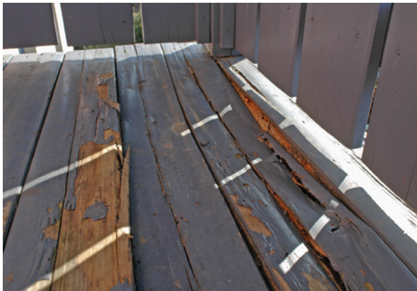
Bild 128 ■ Vollständig zerstörter Bohlenbelag
