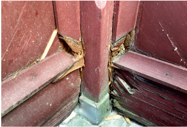
Bild 147 ■ Pilzfruchtkörper des Großporigen Feuerschwamms und durch den Pilz biotisch abgebaute Holzsubstanz am Brüstungsstiel und den Füllungen
