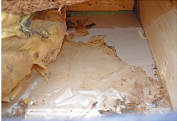
Bild 183 ■ Feuchtebedingte Ablaufspuren auf der Dampfbremse
