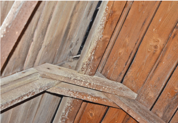
Bild 61 ■ Der Schimmelpilzbefall hat die Holzoberfläche grau verfärbt.
