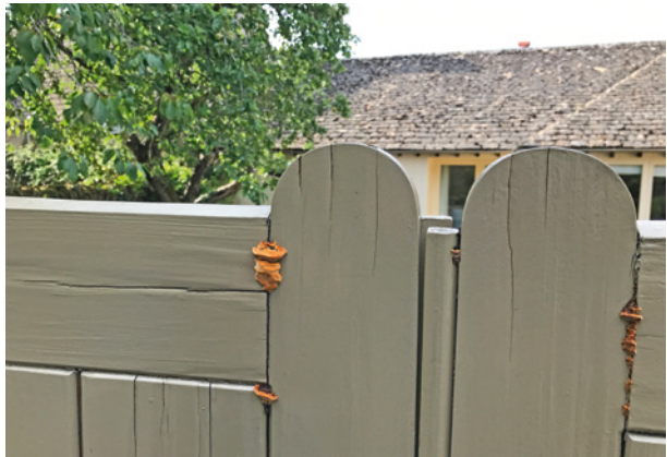
Bild 53 ■ Fruchtkörper des Tannenblättlings als übereinander stehende Konsole an einem Zaun mit bereits deutlich sichtbarer Zerstörung der Holzsubstanz
