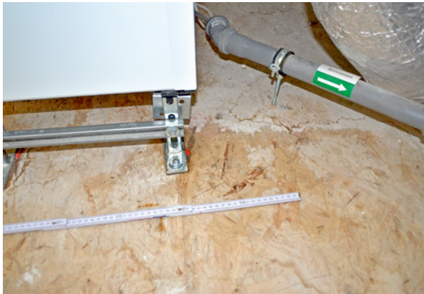
Bild 193 ■ Sichtbare Feuchteränder auf der OSB-Platte infolge von Glykoleintrag
