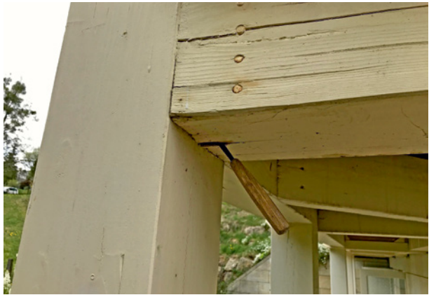
Bild 143 ■ Sichtbare Stabdübel und Riss- bildung im Holz; an der Unterseite ist es bereits zur Pilzschädigung gekommen.
