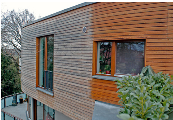
Bild 173 ■ Gegenüberstellung von behandeltem und unbehandeltem Holz: links beginnende Vergrauung von unbehandeltem Lärchenholz und rechts Holz mit aufgebracht Lasur
