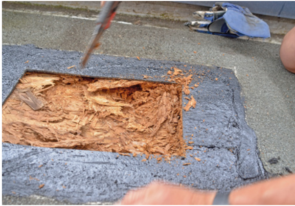
Bild 181 ■ Die OSB-Platte als obere Beplankung hat sich aufgrund von Feuchteeinwirkung und pilzlichem Abbau stark aufgelöst.
