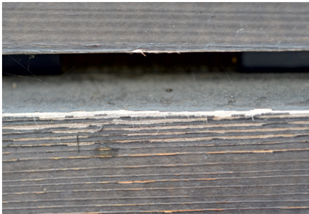
Bild 167 ■ Von der Kante ausgehende Ablösung der Lasurbeschichtung
