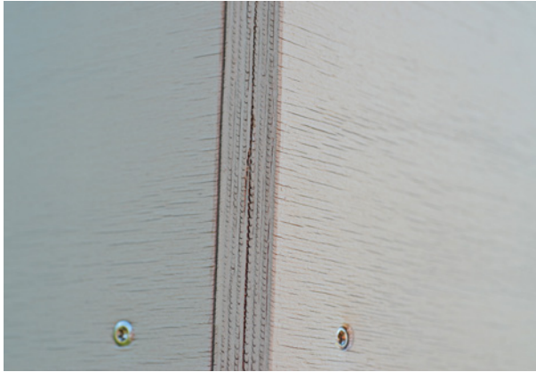
Bild 163 ■ Rissbildung und sichtbare Furnierlagen an der Plattenkante
