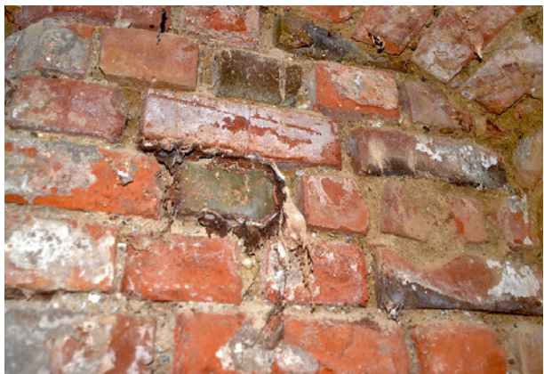
Bild 35 ■ Unschein- barer Altfruchtkörper des Echten Hausschwamms am Kellermauerwerk
