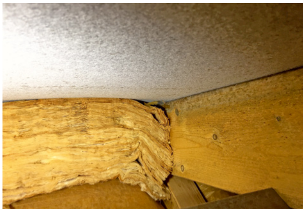
Bild 192 ■ Verschlussene Zuluftöffnung an der Traufe
