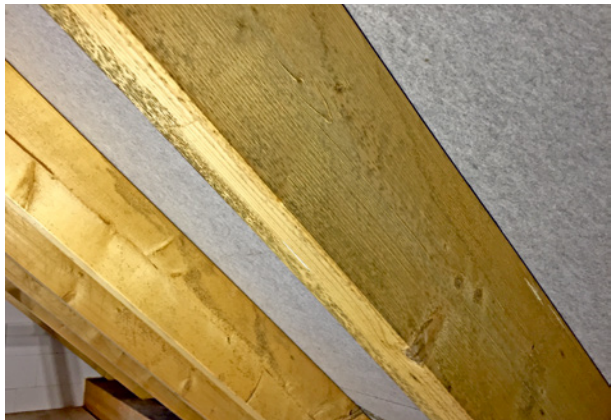
Bild 189 ■ Flächiger Schimmelbefall an den Sparren aus Konstruktionsvollholz
